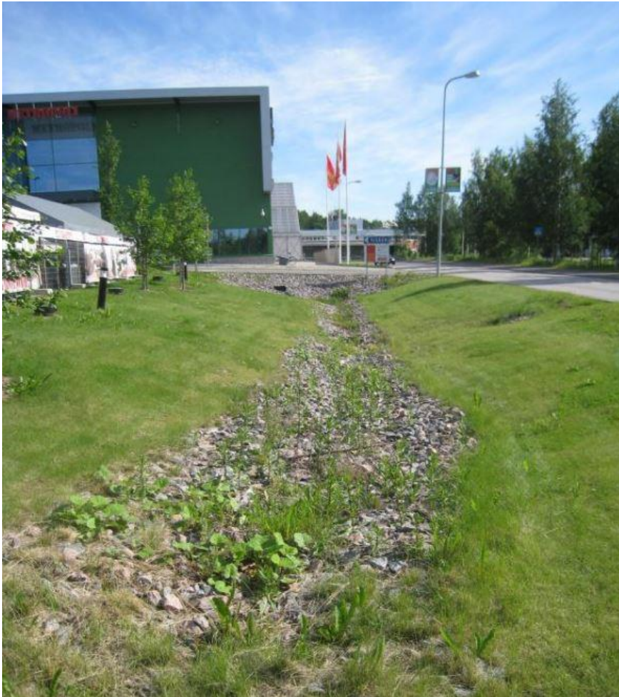
Kuva 5. Hulevesipainanne (Lähde: https://www.ymk-projektit.fi/suunnitteluopas/files/2014/07/3.2.Hulevesien-hallintarakenteet-ja-niiden-kunnossapito_ty%C3%B6kalu.pdf )
