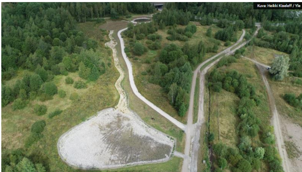
Kuva 8. Hulevesiallas Lahden Hennalassa (kuva: https://yle.fi/uutiset/3-10927924 ).
