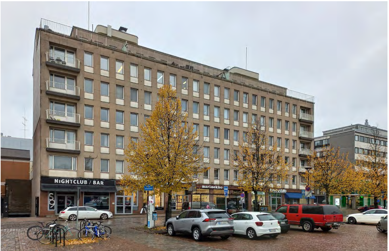
Kuva 5 Hämeentorin julkisivu torin suuntaan.
