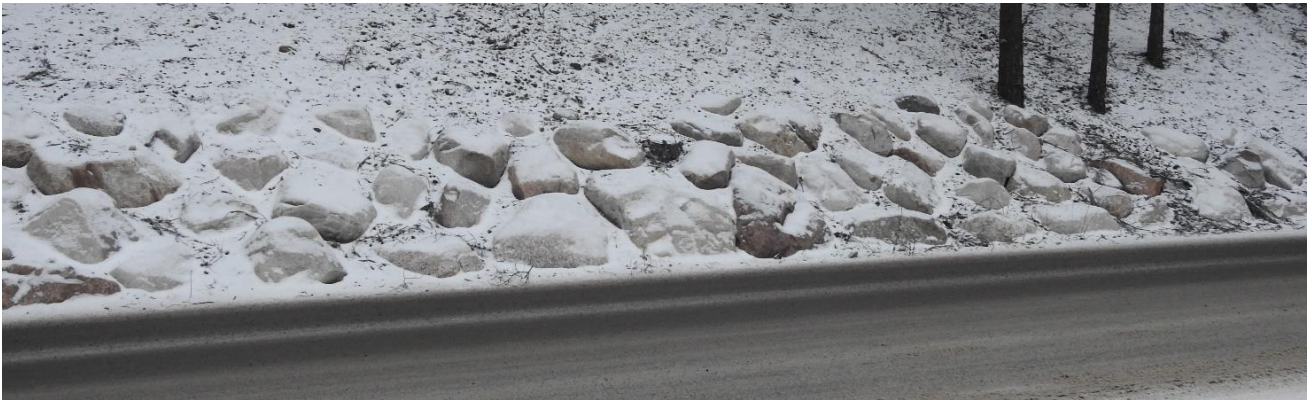
Kuva 2. Tontilta löytyviä luonnonkiviä hyödynnetään pengerryksissä.
