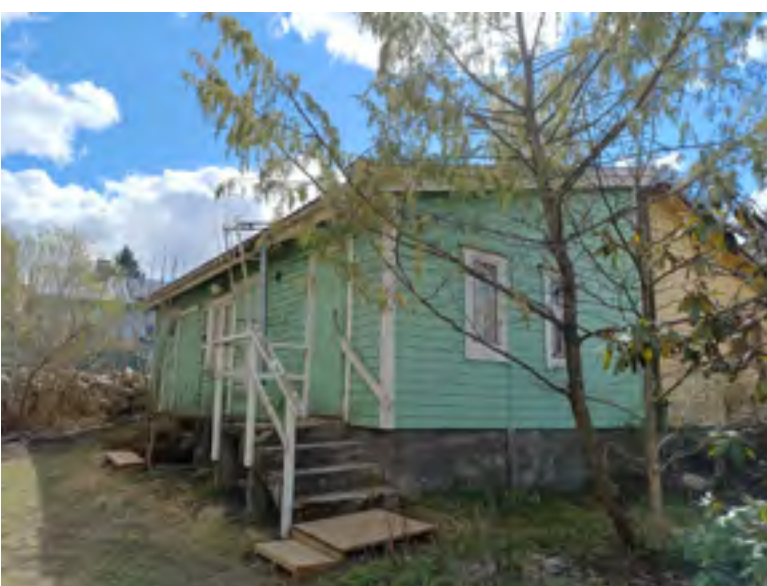
Alkuperäinen ulkorakennus Kankaistenkadulla. Rakennuksessa on käytössä oleva sauna.
