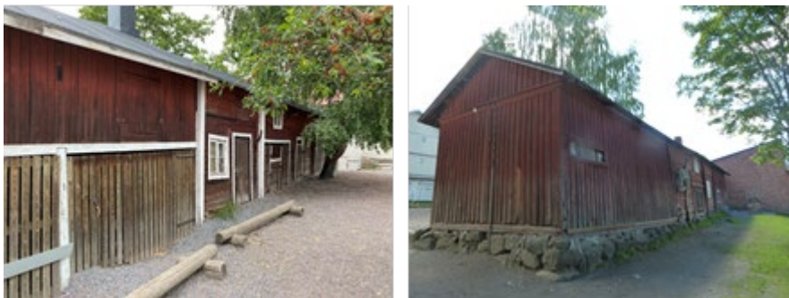
Kuvat 19-20. Puinen varastorakennuksen pitkät julkisivut.
