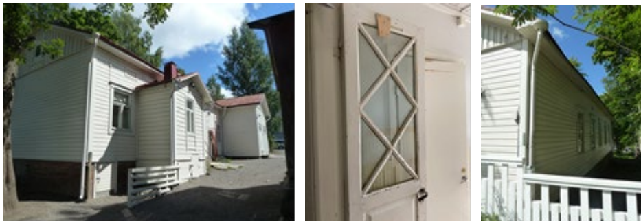
Kuva 13-15. Tapolan talo, sisäovi ja julkisivu koilliseen.
