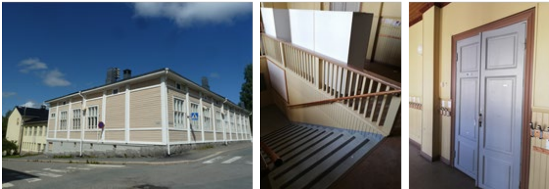
Kuvat 4-6. Puukoulu, portaikko ja aulan pariovet.
