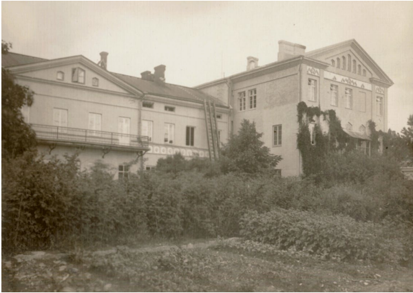
Kuva 7. Rakennukset pihalta päin. Siellä on sijainnut kasvimaata.
