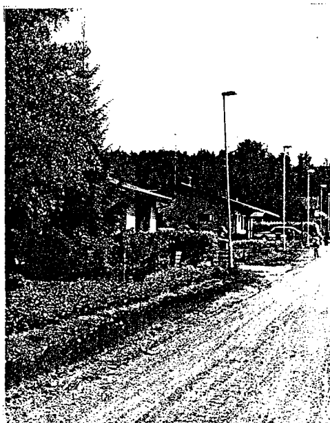
Vuorentaan asevelikylään sopimaton uutta rakennuskantaa. Rakennusten korkeus, kattokulma, materiaalit ja sijoitus tonteille poikkeavat perinteisestä tavasta.
