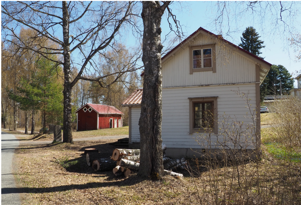
Etualalla terveydenhoitajan talo, takana kylmä varastorakennus
