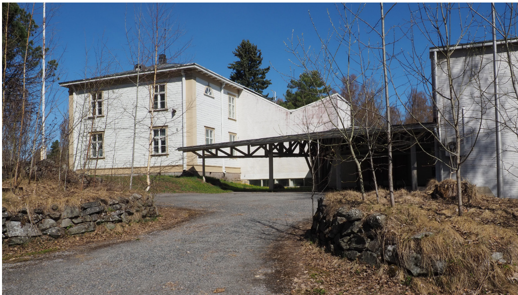
Puu- ja kivisiipien yhtymäkohta
