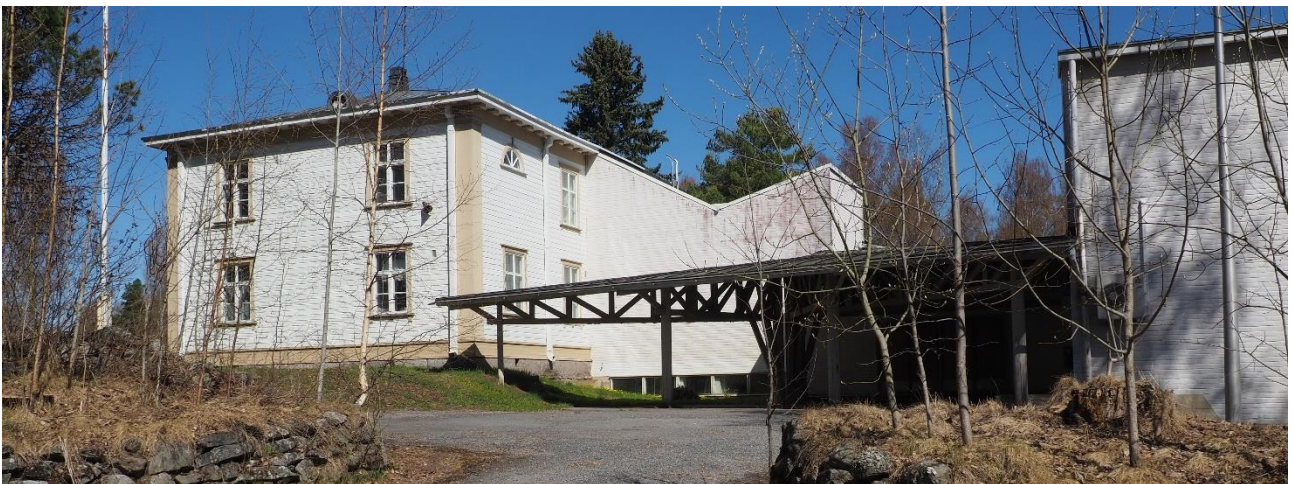
Kuva 14. Alkuperäisen rakennusosan ja lisäsiipien yhtymäkohta rakennuksen lounaispuolella.
