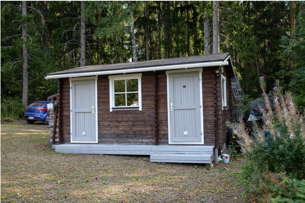
Kiinteistön Mäkiranta 109-454-1-164 pihassa oleva talousrakennus.
