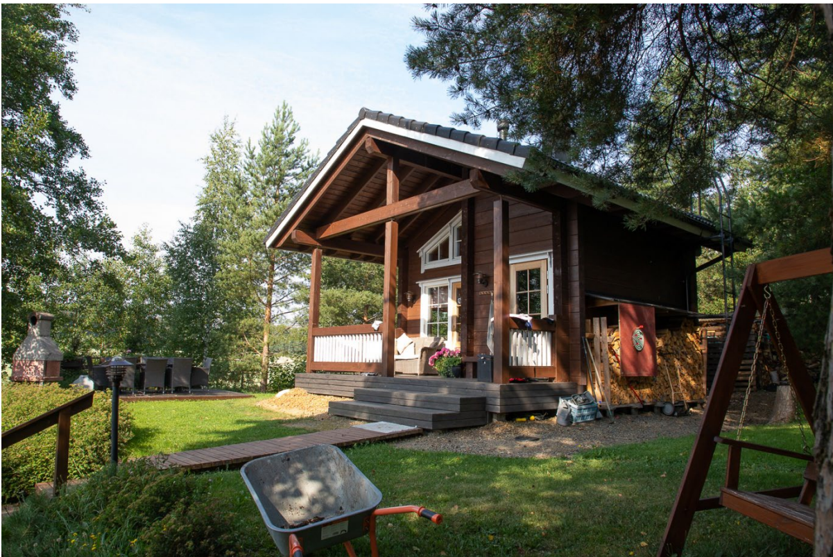
Kiinteistön Kauranen 109-454-1-89 rannassa sijaitseva rakennus.
