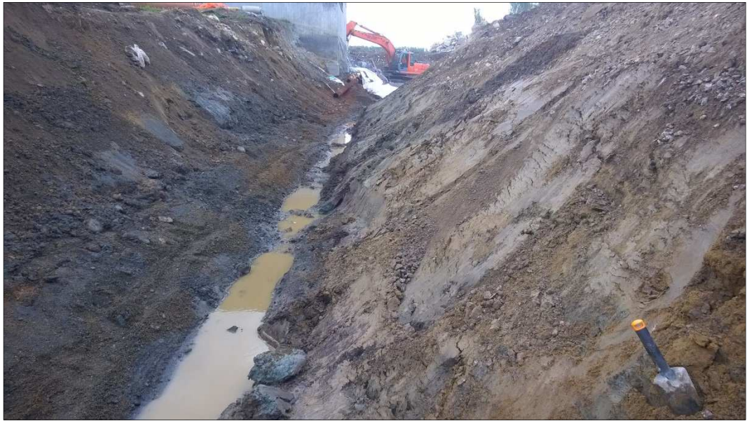
Kuva 3. Putkiliinja kävelytieltä (pohjoisesta) laajennusosalle.
