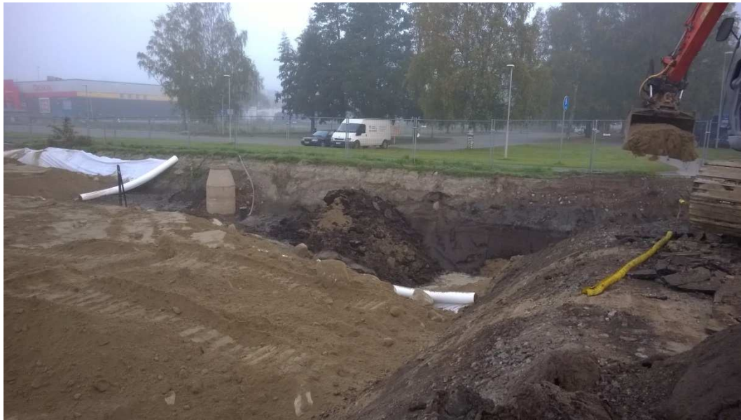
Kuva 7. Jalkakäytävän (pohjoisen) puoleiselle kaivantoseinämälle asennettiin suodatinkangas.
