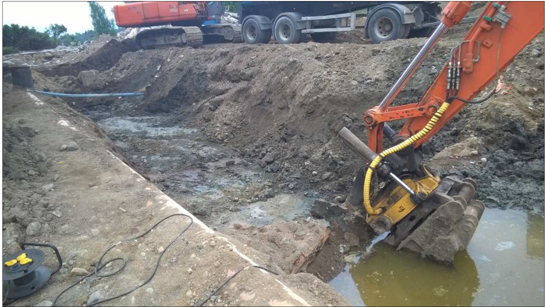
Kuva 1. Laajennusosan pohjan kaivua.
