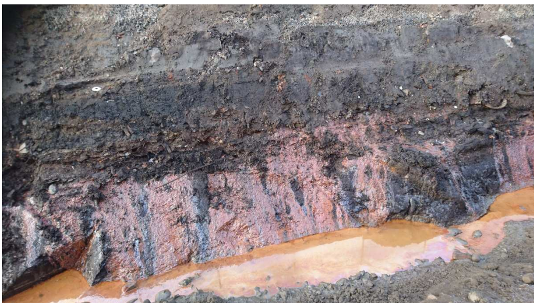
Kuva 9. Jäteseinämää tenniskentän (lännen puolella) laidalla.
