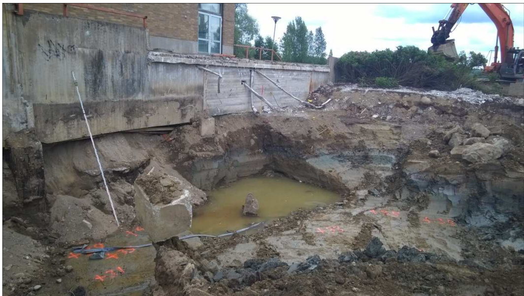
Kuva 2. Laajennusosan pohjan kaivua.
