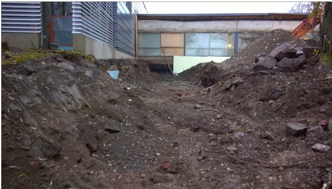
Kuva 12. Maalämpöputkien asennuskaivanto. Kaivantoon asennettiin HDPE-kalvo.
