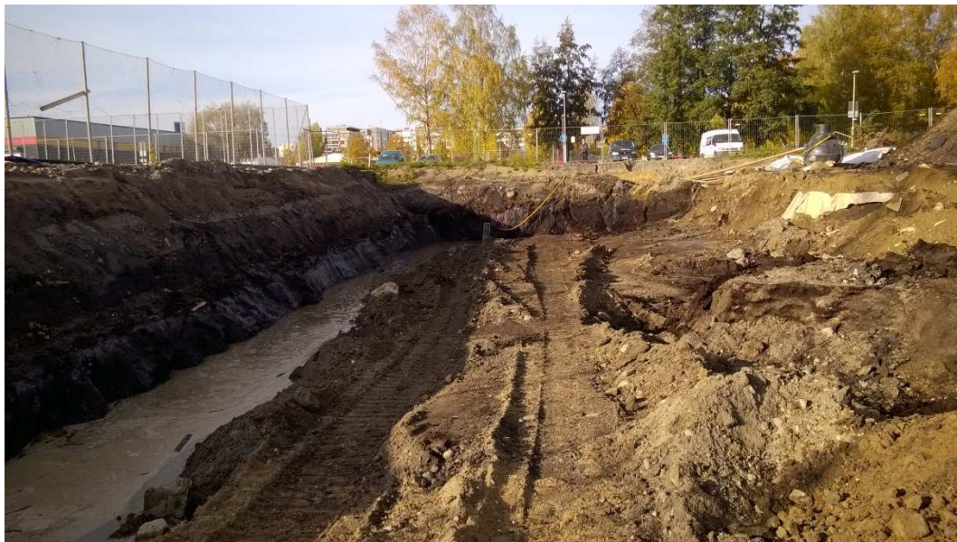
Kuva 8. Tulevan parkkipaikan ja tenniskentän (lännen) välinen seinämä.
