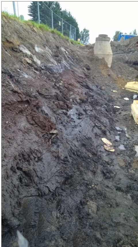
Kuva 6. Jalkakäytävän (pohjoisen) puoleinen kaivantoseinä.
