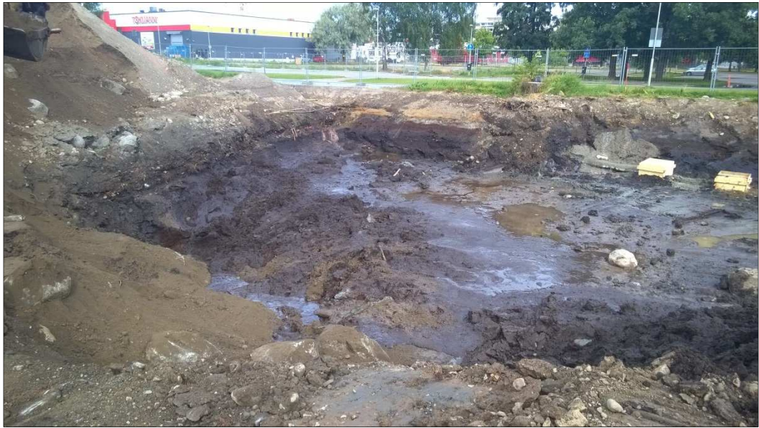
Kuva 5. Tulevan parkkipaikan turvekerroksen poistoa.
