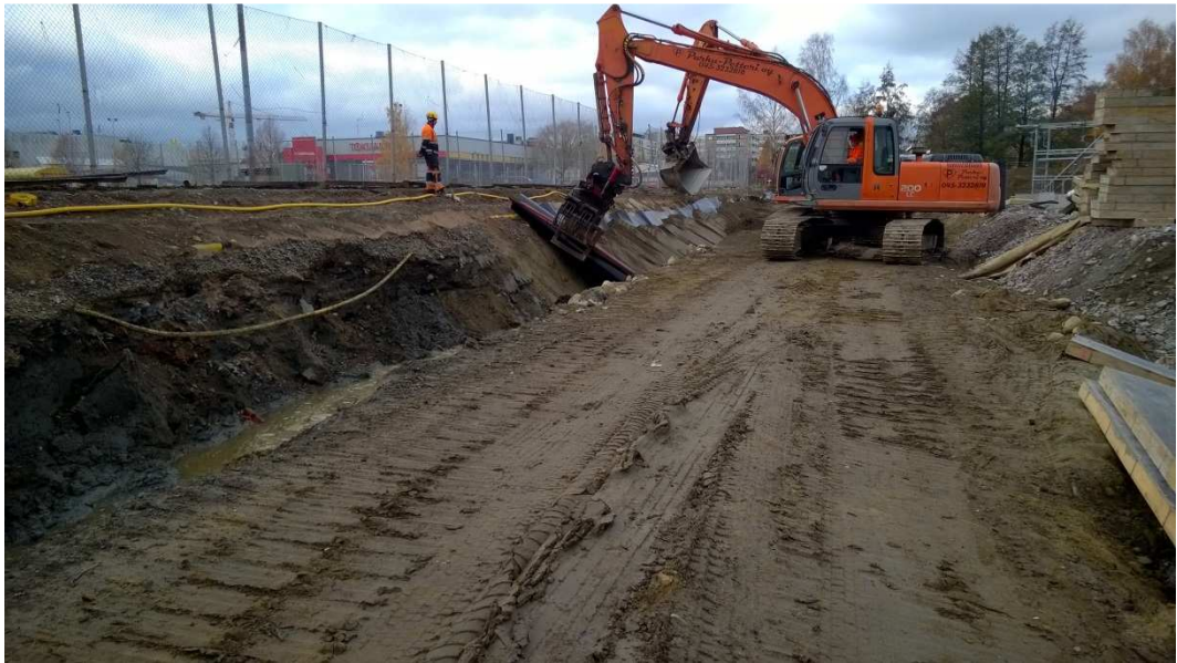
Kuva 13. HDPE-kalvon asennus tenniskentän (lännen) vastaiselle seinämälle.
