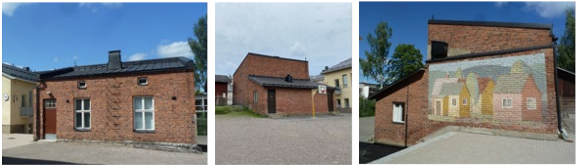
Kuvat 16-18. Tiilirakennus eri suunnista.
