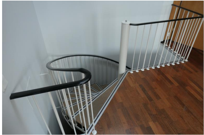
6d Kuudennen ja viidennen kerroksen välille on puhkaistu ylimääräinen portaikko.
