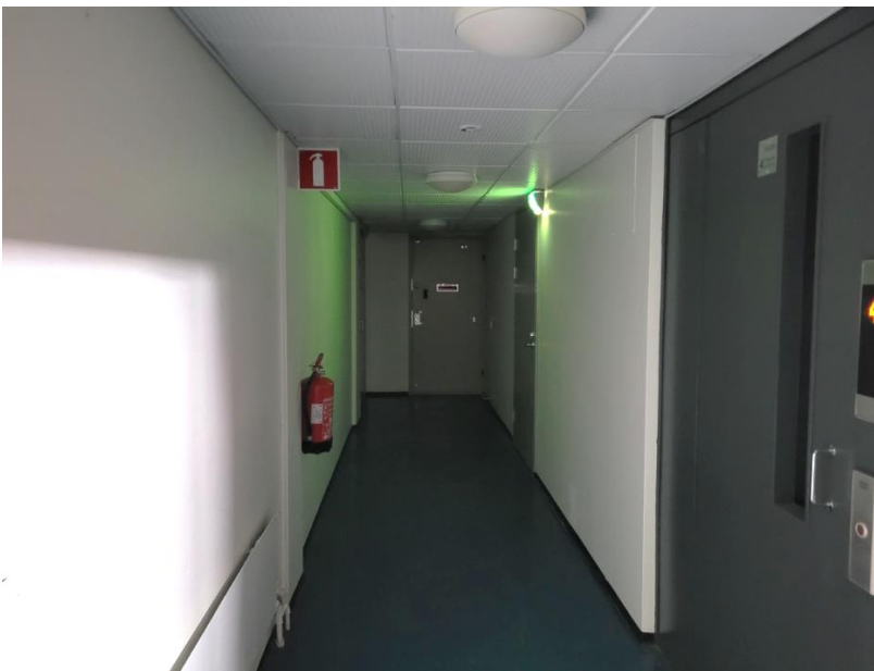
3e C-osassa toimistoiksi muutettuihin entisiin asuinhuoneistoihin kuljetaan tavanomaisen porraskäytävän kautta.
