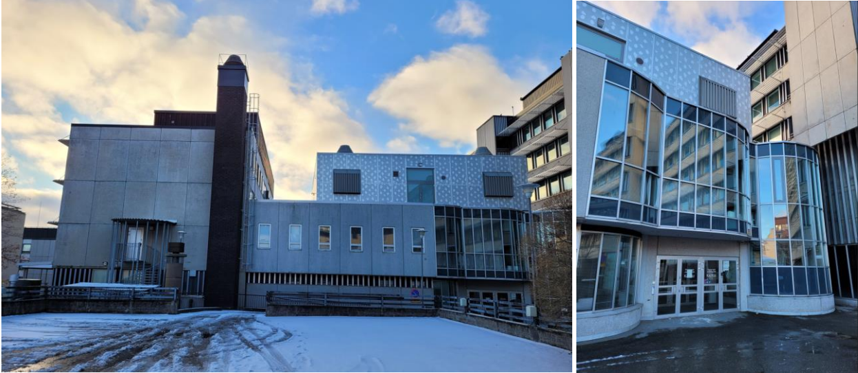
Kuva 34 1980-luvun laajennusosan julkisivu erottuu selkeästi alkuperäisistä osista etenkin terästä ja lasia yhdistelevän sisäänkäynnin osalta. Katolle sijoitettiin 2010-luvulla uusi ilmastointikonehuone, joka peitti alkuperäiset valokatteet.
