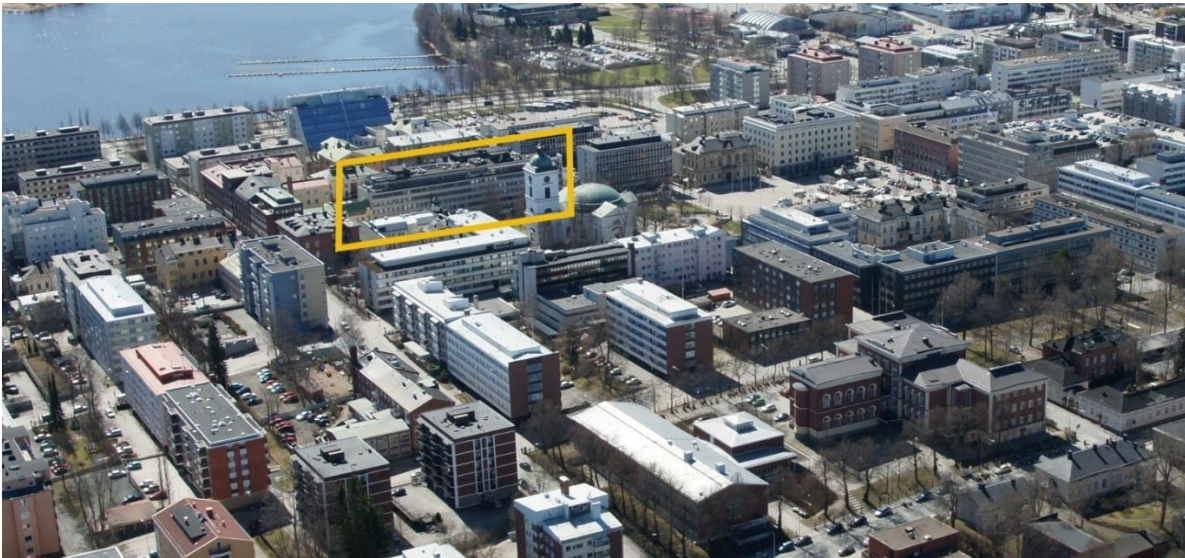
Kuva 63 Rakennus osana kaupunkirakennetta koillisesta katsottuna. Kuva: Hämeenlinnan kaupunki.
