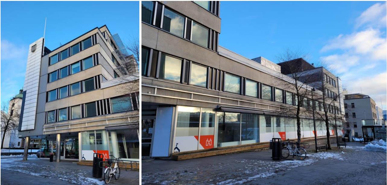
Kuva 52 Kadunpuoleisesta julkisivusta Linnakadun puolella on enemmän korkeusvaihtelua. Julkisivu nauhaikkunoineen noudattaa samaa tyyliä ja rakennusosien välikin hahmottuu samanlaisena leveämpänä pystylinjana kuin Raatihuoneenkadun puolellakin. Suoraan katulinjassa kiinni olevat pohjakerroksen suuret ikkunat hahmottuvat selkeämmin kuin Raatihuoneenkadulla pienen lipan alla. Vasemmanpuoleisessa kuvassa erottuu myös toria kohti suunnattu sisäänvedetty pääsisäänkäynti.
