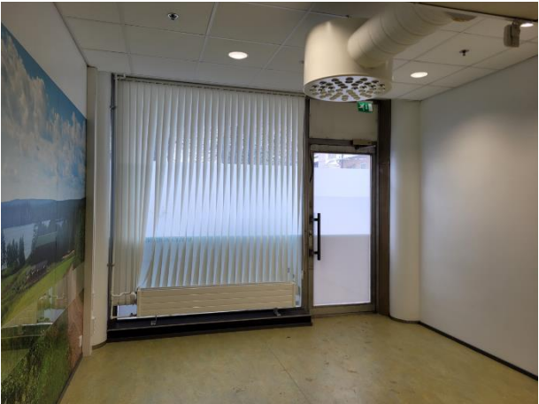
1c Yksi B-osaan Rattihuoneenkadun puolelle sijoittuvista pienehköistä työhuoneista. Kantavat pilarirakenteet näkyvissä.
