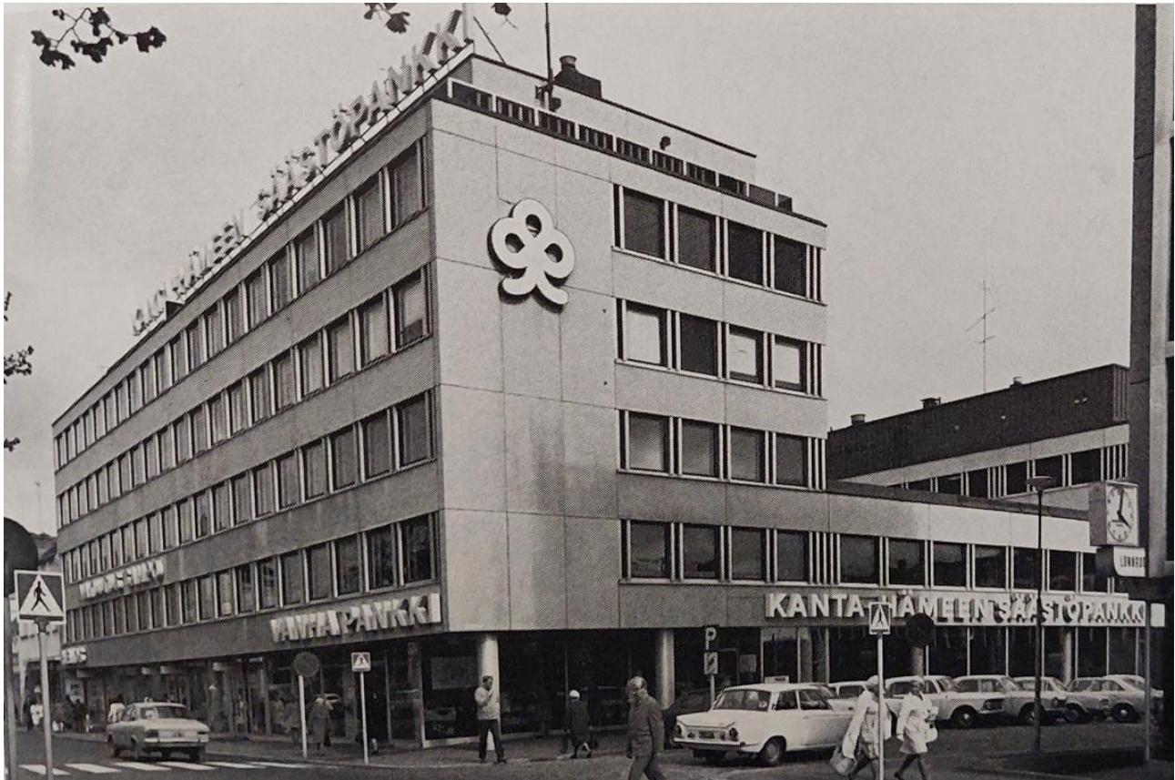
Kuva 29 Rakennuksen julkisivu koostui betonielementeistä ja vertikaalista vaikutelmaa tuoneista nauhaikkunoista. Ylimmän kerroksen lisäksi myös pohjakerros oli hienoisesti sisäänvedetty, mikä hieman piilotti liiketiloja ja sisäänkäyntejä rakennusmassan alapuolelle. Kuva teoksesta: Hämeenlinnan Vanha säästöpankki 1956–1971.
