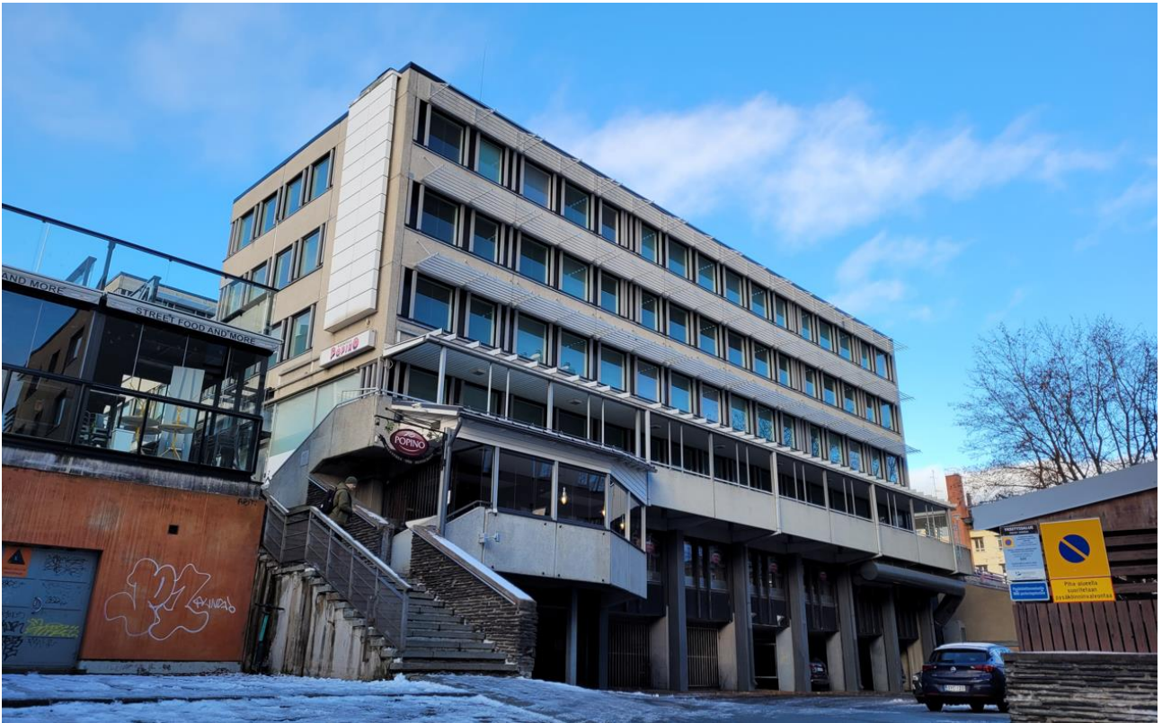
Kuva 55 C-osan julkisivu kuvattuna Linnakadulta linja-autoaseman suunnasta. Portaiden katkaiseman kadun alapäästä julkisivu hahmottuu selkeästi korkeampana kuin Linnakadun yläosasta kuvattuna. Rakennusta kannattelevat molempien kellarikerrosten korkuiset betonipylväät, joiden yläpuolella erottuvat parvekemaisina rakenteina ravintolan terassi sekä kadulta sisäpihalle rakennuksen kyljessä johtava jalankulkukäytävä. Etualan portaikosta ja portinpielestä voidaan hahmottaa myös vuolukivisen tukimuurin rakenne.
