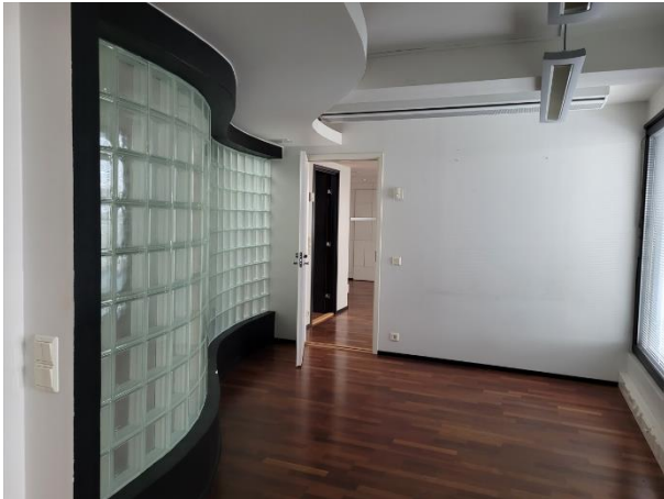
6c Käytävien muutokieltä elävöittävät samalla valoa tuovat lasitiiliseinät.
