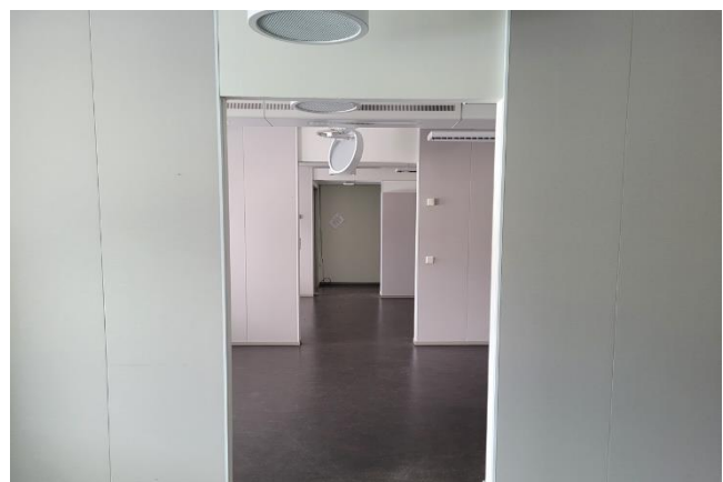
3b Toimistohuoneet on erotettu toisistaan kevyillä väliseinillä, jotka ovat paikoin mahdollistaneet eri tilojen yhdistämisen toisiinsa.
