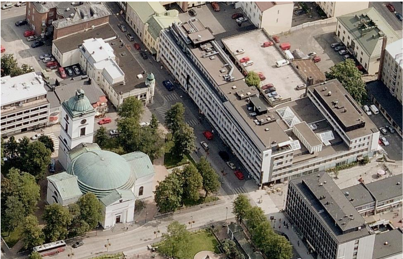
Kuva 39 Selvityskohde päiväämättömässä ilmakuvassa ennen 2010-luvun puolivälissä toteutettua ilmanvaihtoremonttia, jonka myötä keskiosassa sisäpihan puolella näkyvä kahdesta pyramidinmuotoisesta kattoikkunasta muodostunut valokate jäi laajentuneen ilmanvaihtokonehuoneen alle. Kuva: Hämeenlinnan kaupunki.
