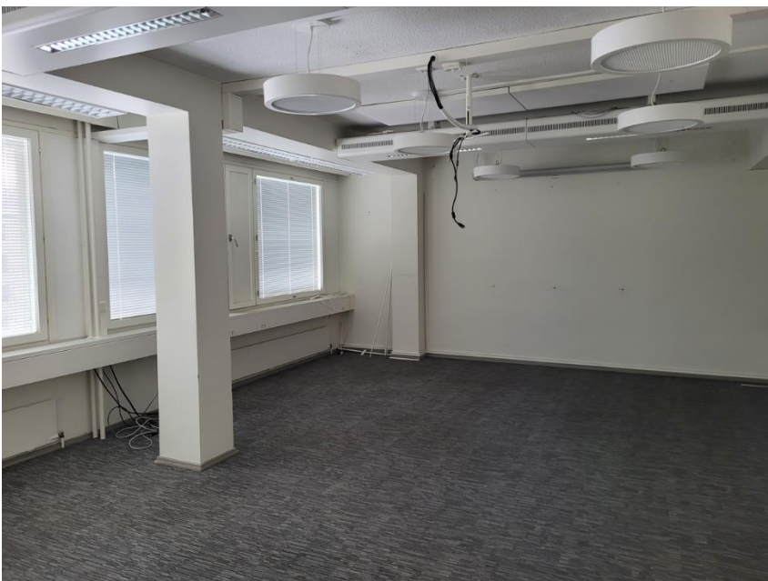
4a Neljännen kerroksen toimistuhuoneissa erottuu hyvin joka kerroksessa paikoin toistuva ratkaisu kantavien pilareiden sijoittelusta hieman ulkoseinästä sisäänvedetysti.
