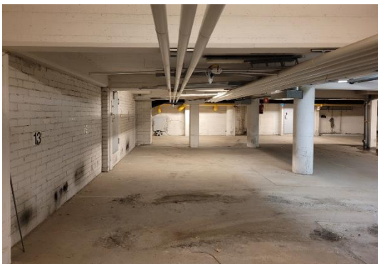
K1a Matalahko parkkihalli on tuettu betonipylväillä ja vuorattu valkoisilla tiiliseinillä.
