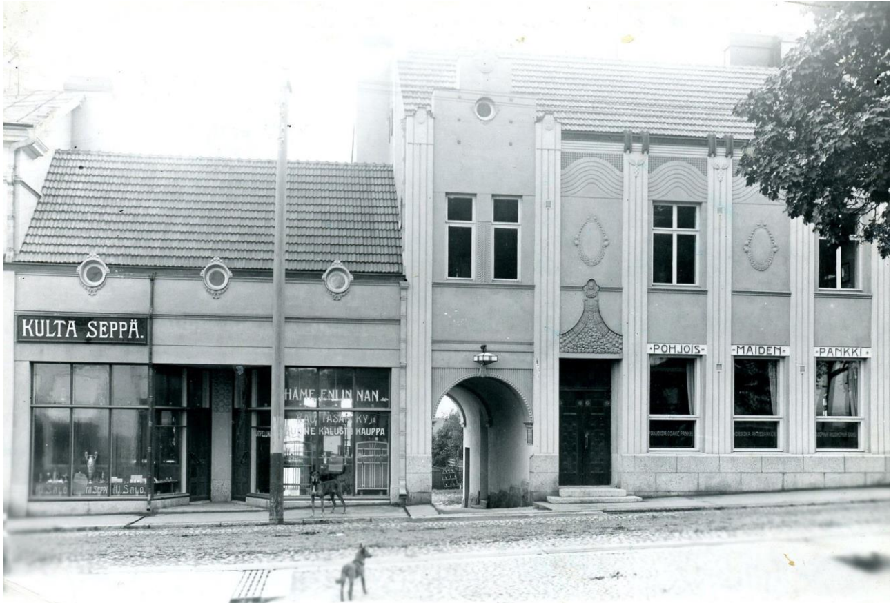
Kuva 4 Ennen selvityskohteen rakentamista osoitteessa Raatihuoneenkatu 9 sijaitsi kaksi liikerakennusta, joista yksikerroksisessa toimi kuvan ottamisen aikaan 1900-luvun alkuvuosikymmeninä kultasepäliike ja kalustekauppa sekä kaksikerroksisessa Pohjoismaiden osakepankki. Kuva: Muistojen Hämeenlinna.
