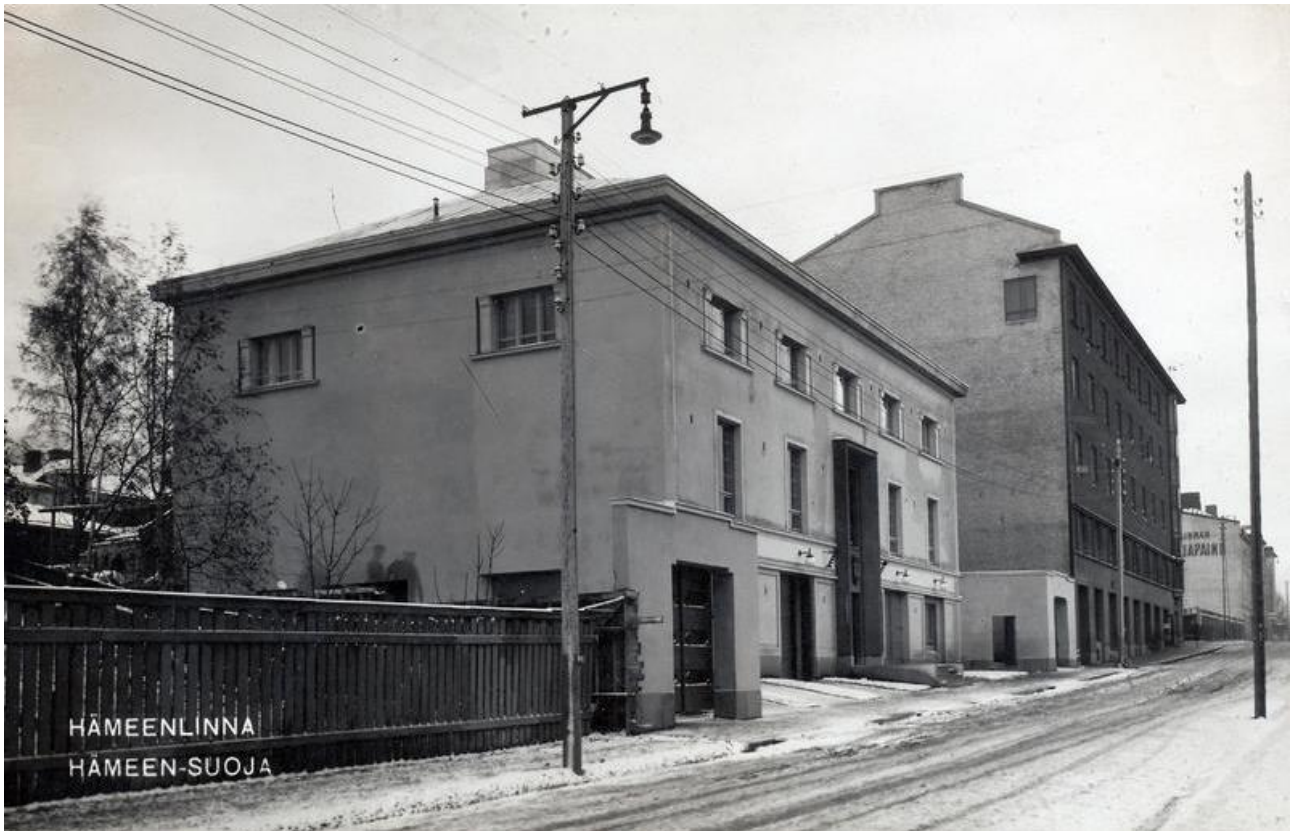
Kuva 4 Hämeen suoja kuvattuna 1930-luvun alussa pian valmistumisensa jälkeen. Alkuperäinen ulkoasu on säilynyt nykypäiviin asti, mutta rakennusta reunustavat muurit portteineen on purettu ja kadulle avautuneita varastoja ja talleja muutettu liiketiloiksi. Kuva: Muistojen Hämeenlinna.
