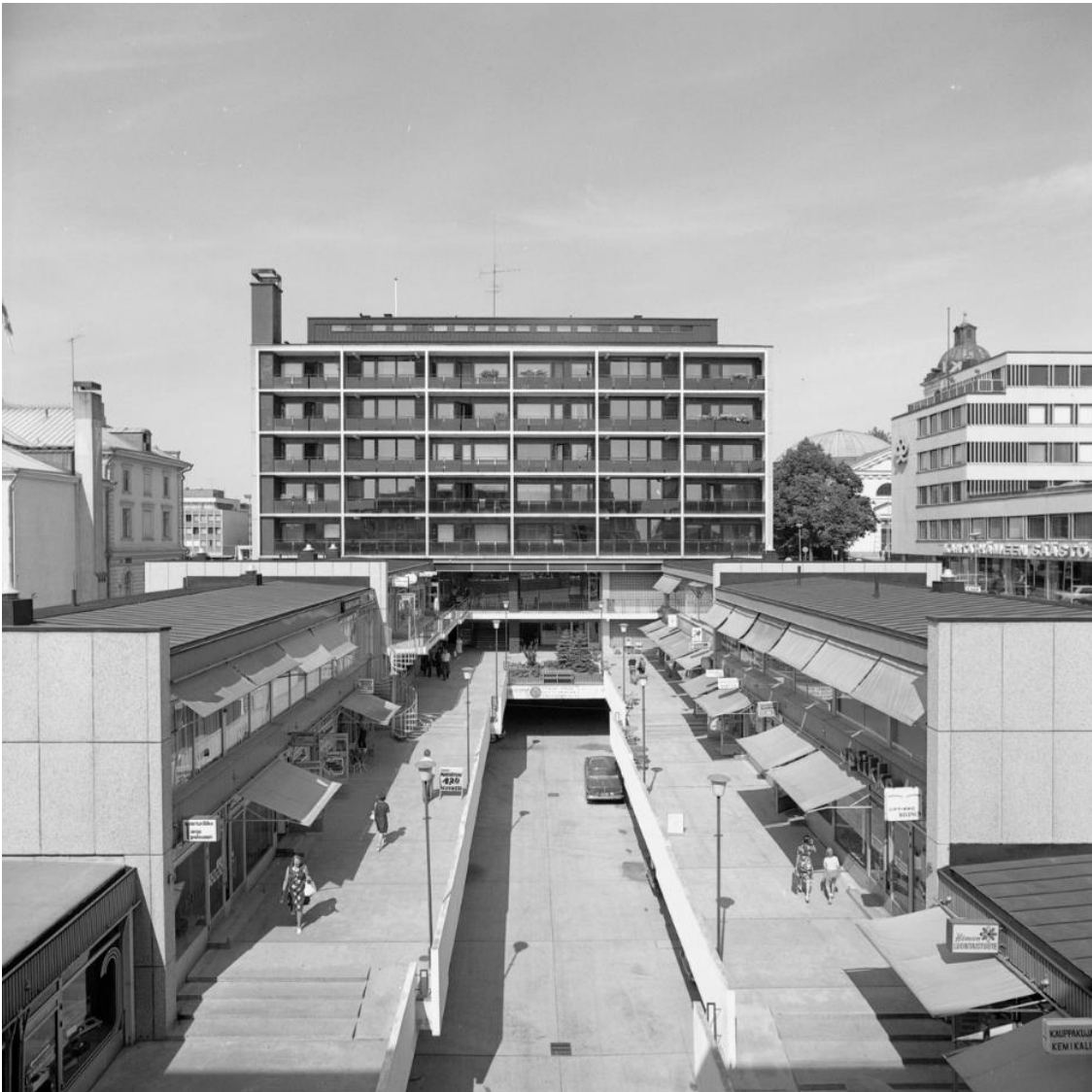
Kuva 7 Vuonna 1964 avattu niin ikään Mika Ernon suunnittelema Hämeenlinnan keskustalo on yksi Hämeenlinnan keskustan parhaiten säilyneistä modernin aikakauden liikerakennuksista. Sen sisäpihalla liikennemuodot eroteltiin eri tasoihin yhteiskunnan muutenkin autoistuessa. Selvityskohde erottuu kuvan oikeassa laidassa alkuperäisessä asussaan. (Kuva: Teuvo Kanerva, Museovirasto, 1975)
