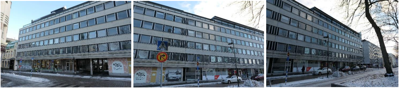
Kuva 50 A-D-rakennusosien Raatihuoneenkadulle avautuva julkisivu. Ulkoasultaan yhtenäisten rakennusosien vaihdos näyttäytyy julkisivussa ikkunoiden välissä olevana leveämpänä pystylinjana alumiiniprofiileineen.
