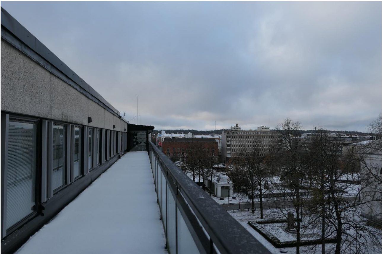
Kuva 60 Näkymä kuudennen kerroksen parvekkeelta kohti toria.
