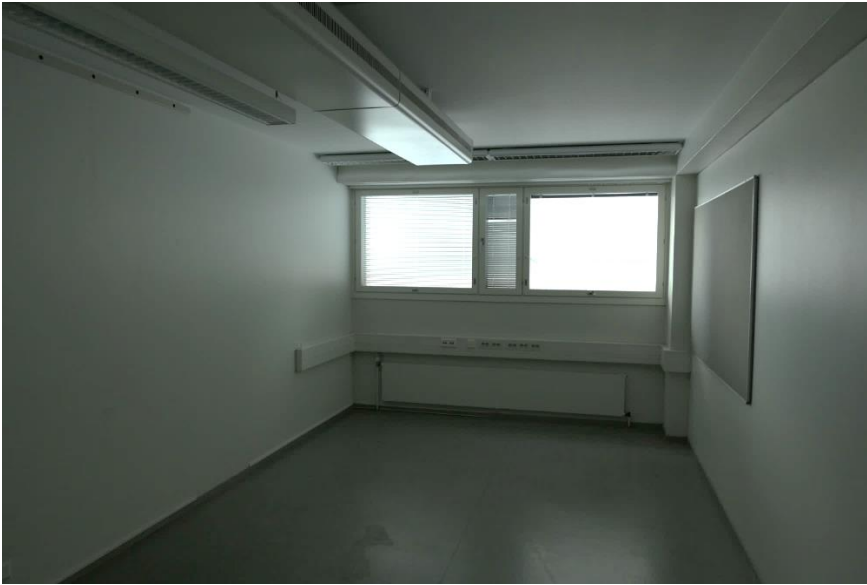
3c Joissain toimistohuoneissa rakenteelliset ratkaisut ovat pakottaneet sijoittamaan ikkunat tavanomaista korkeammalle.
