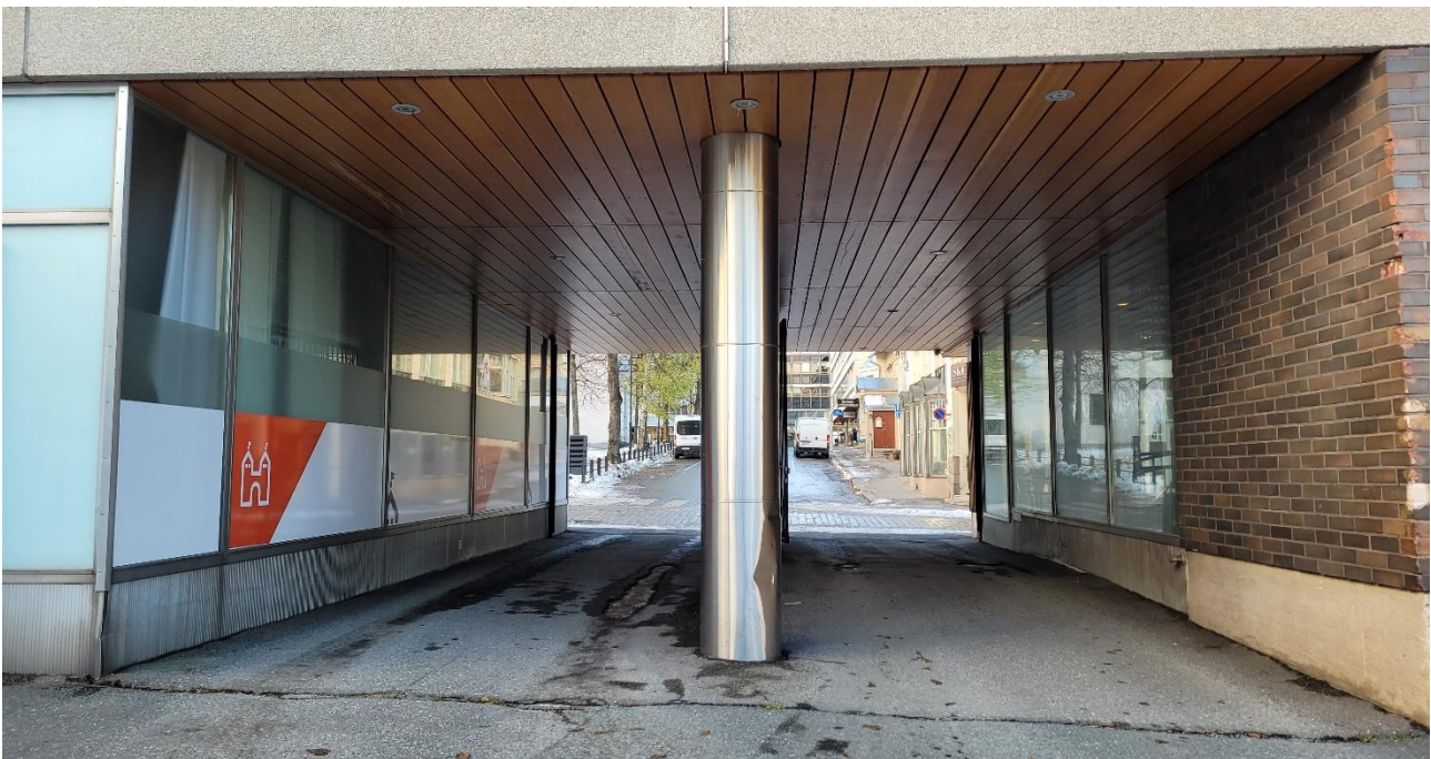
Kuva 65 Porttikonki sisäpihan puolelta katsottuna.
