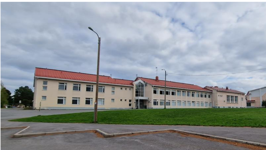
Kuva 6. 80-luvulla rakentunut koulurakennuksen osa.
