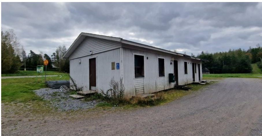
Kuva 9. Palloilukenttiä palveleva ulkorakennus.
