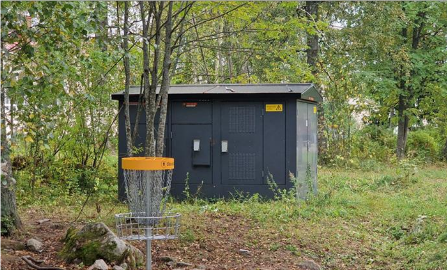
Kuva 15. Puistoalueella sijaitseva muuntamorakennus.
