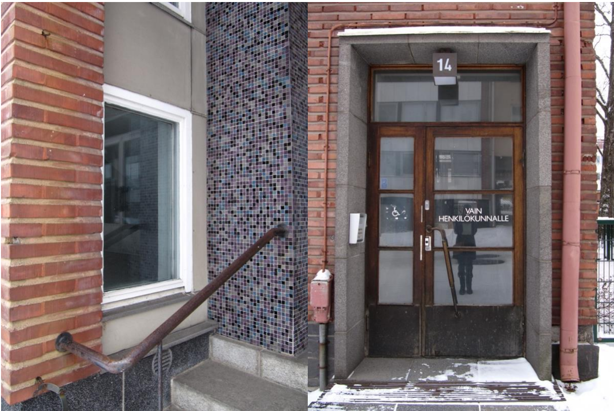
Julkisivumateriaalien yksityiskohtia (yllä). Viistosaumattu tiiliverhous, liuskekivinen sokkeli ja mosaiikkilaatoitus. Pääsisäänkäynnin yhteydessä on säilynyt vanha käsijohde (alla). Kerrostalo-osan sisäänkäynnillä on graniittikivinen kehys (alla).
