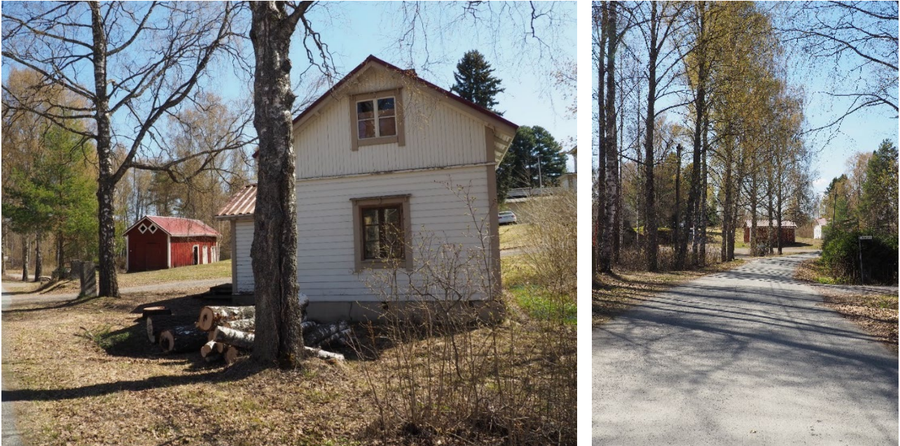
Kuva 18. Punainen rakennus on kylmä varistorakennus ja vaalea nk. terveydenhoitajan talo
