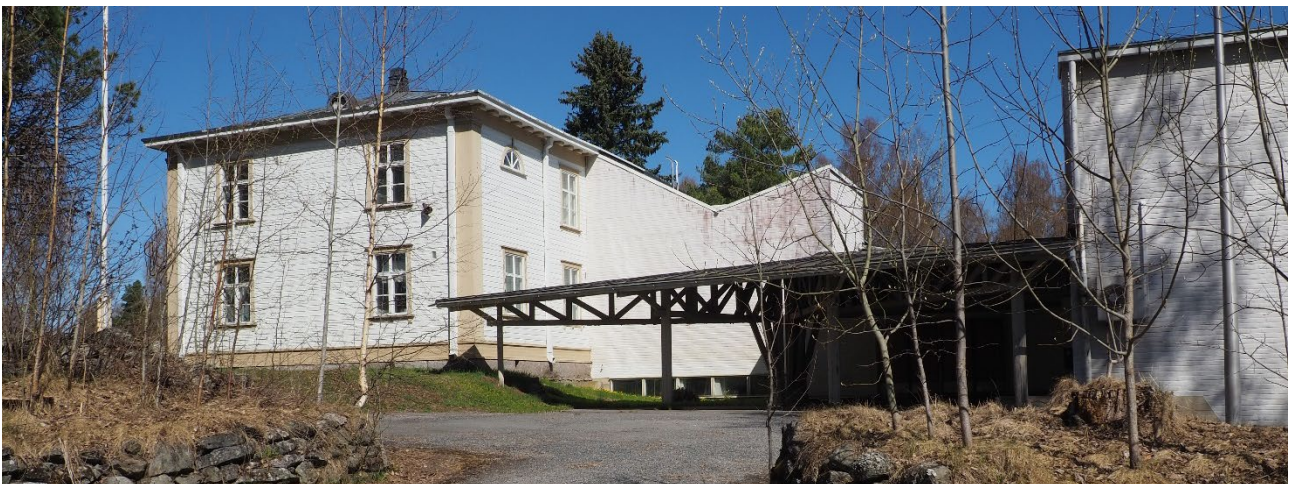
Kuva 14. Alkuperäisen rakennusosan ja lisäsiipien yhtymäkohta rakennuksen lounaispuolella.
