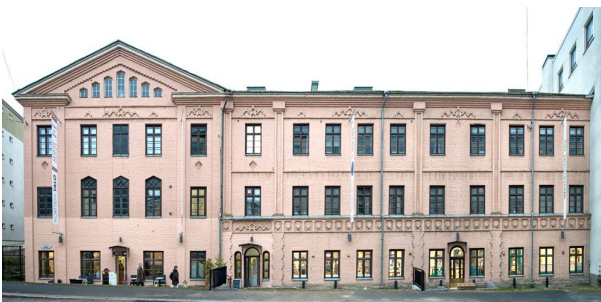
Kuva 10. Vanhan osan nykyinen 3-kerroksinen fasadi.
