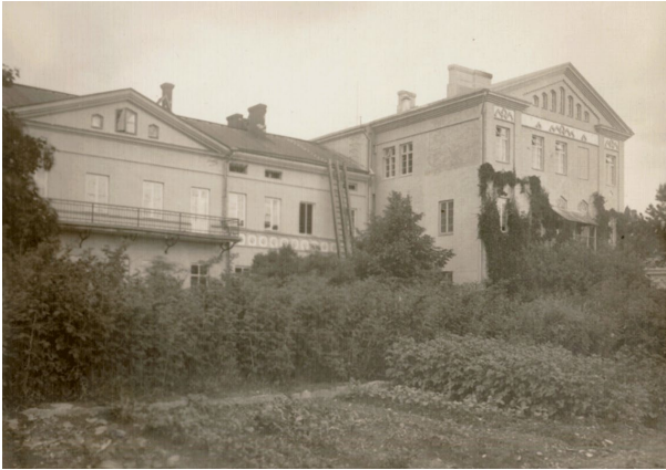
Kuva 7. Rakennukset pihalta päin. Siellä on sijainnut kasvimaata.
