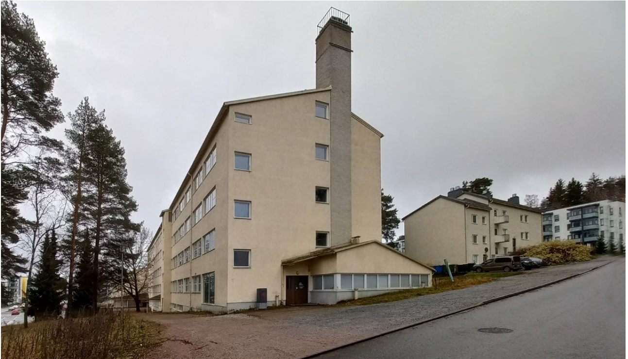
Kuva 16 Kuva rakennuksen pohjoispäädystä Korkeakoulunkadulta kuvattuna.
