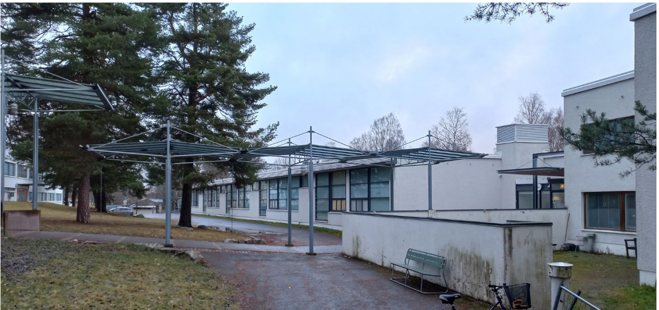
Kuva 15 Kuva rakennusten väliseltä sisäpihalta pohjoisen suuntaan.
