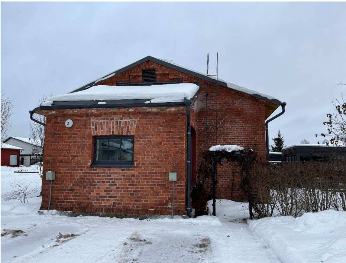
Kuva 28. Rakennuksen lounaispääty. Päätyjen tiilimuurausten halkeamat on korjattu. Lautarakenteiset rehuvarastonurkkaukset on molemmista päädyistä purettu. Kuva 10.1.2024.
