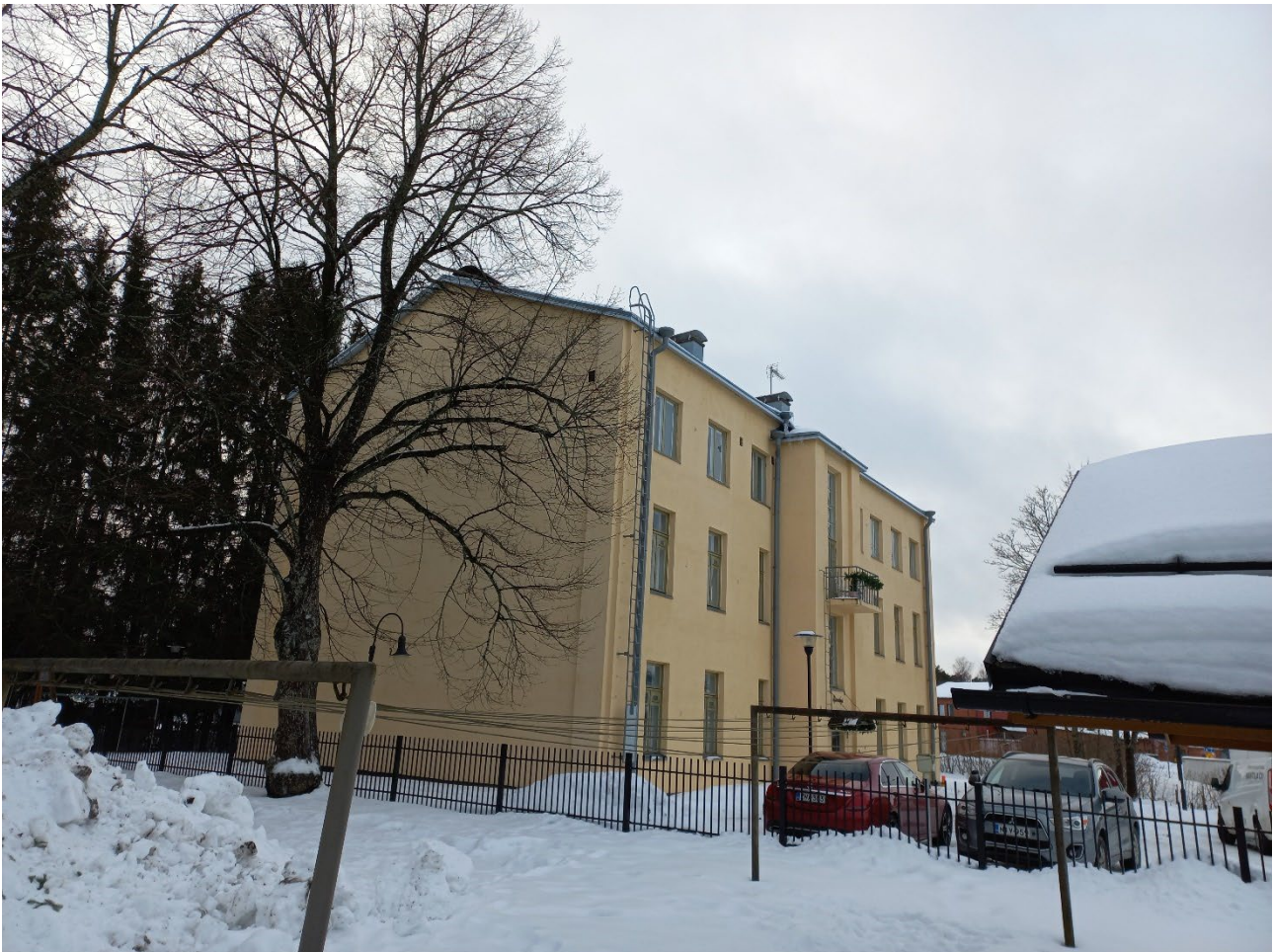
Kuva 35. Läntinen päällystörakennus on korotettu kolmikerroksiseksi ja sen julkisivu on rapattu. Kuva 10.1.2024.
