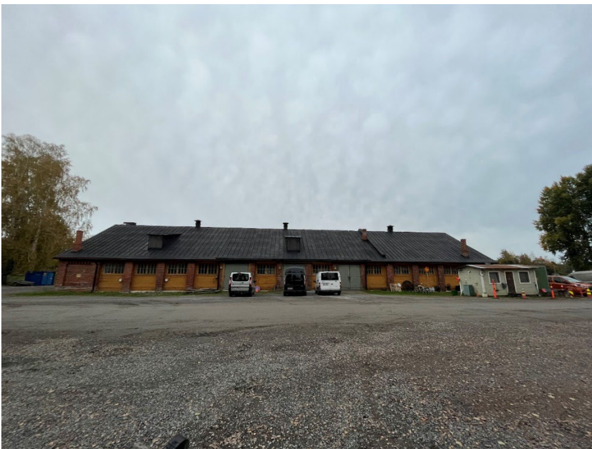
Kuva 49. Kasakkatallirakennuksen julkisivu lännestä päin. Kuva 4.10.2023.
