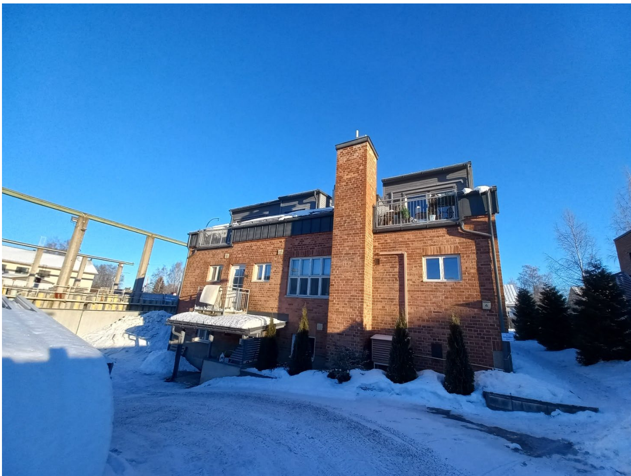
Kuva 41. Entinen leipomo Poltinahontien varressa on muutettu asuinkäyttöön. Rakennuksessa on kuusi loft-huoneistoa. Kuva 26.1.2024.
