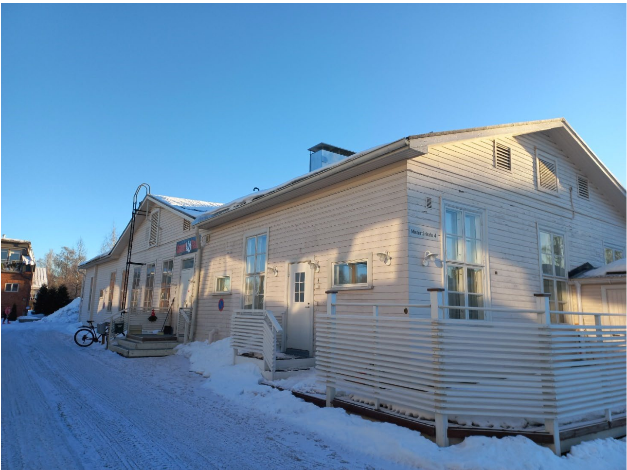
Kuva 44. Entisessä keittiörakennuksessa toimii nykyisin kuntosali. Kuva 26.1.2024.
