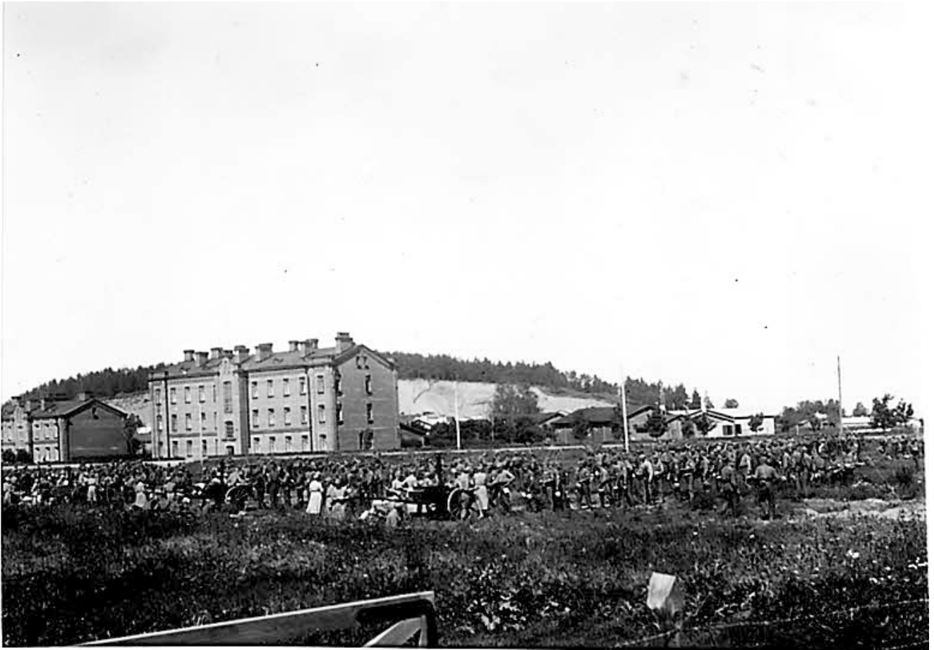
Kuva 14. Näkymä Hattelmalantieltä kohti Poltinahon kasarmialuetta. Taustalla näkyy Ahveniston harjun soranottoaluetta. Edessä kaksi 1910-luvulla rakennettua päällystön rakennusta Turuntien varressa. 2-kerroksinen rakennus korotettiin myöhemmin 3-kerroksiseksi ja rapattiin. Kuva 1930-1940 -luvulta. Kuva Hämeenlinnan kaupunginmuseo.
