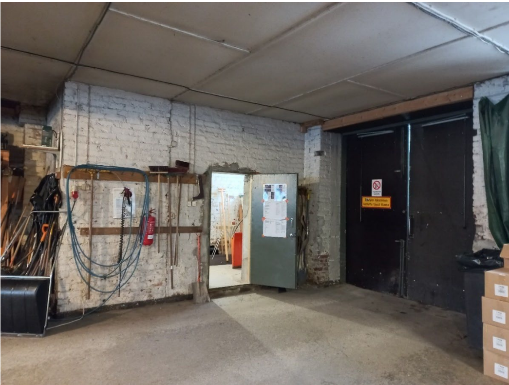
Kuva 67. Keskimmäisen hallitilan kautta kuljetaan rakennuksen eteläisimpään osaan.
