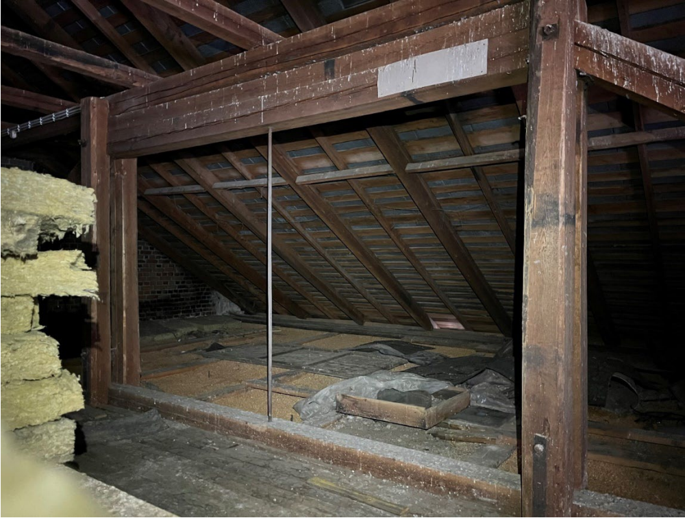
Kuva 76. Välikaton keskiosassa on vanha pintalautoitus. Välikaton kautta on todennäköisesti pudotettu heiniä alas talliin. Kuva 10.1.2024.
