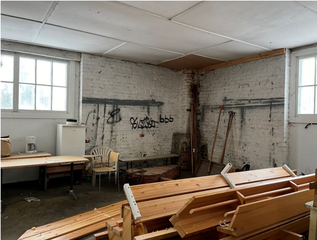
Kuva 64. Kasakkatallirakennuksen luoteisnurkasta on purettu pönttöuuni. Kuva 10.1.2024.
