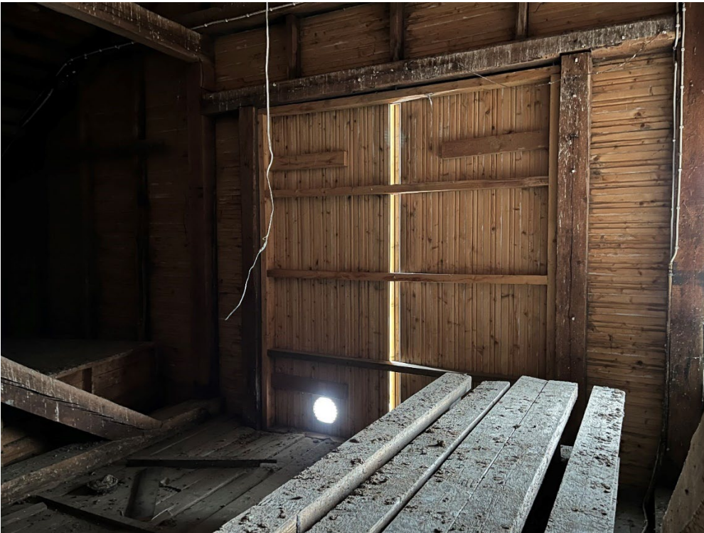
Kuva 77. Rakennuksen eteläpäätymiossa on vastaava pariovillinen aukko kuin pohjoispäädysssäkin. Kuva 10.1.2024.
