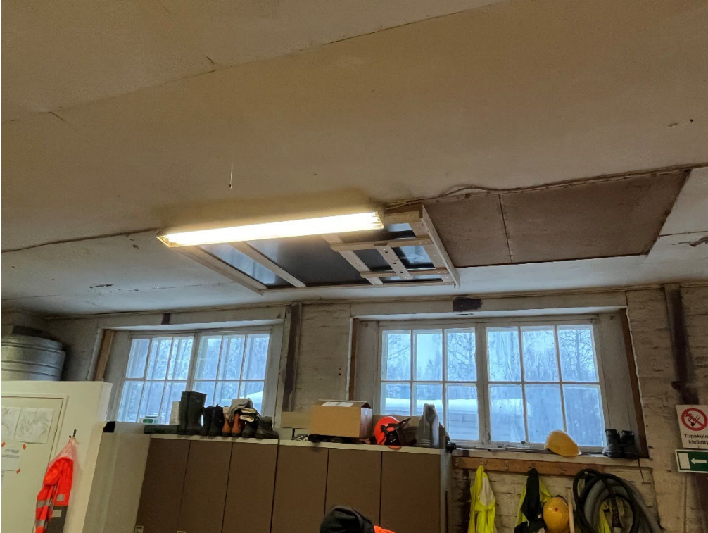
Kuva 79. Välikatolle pääsee kiipeämään taukotilan sisäkaton aukosta. Myös rakennuksen lounaisnurkassa on pönttöuuni. Kuva 10.1.2024.
