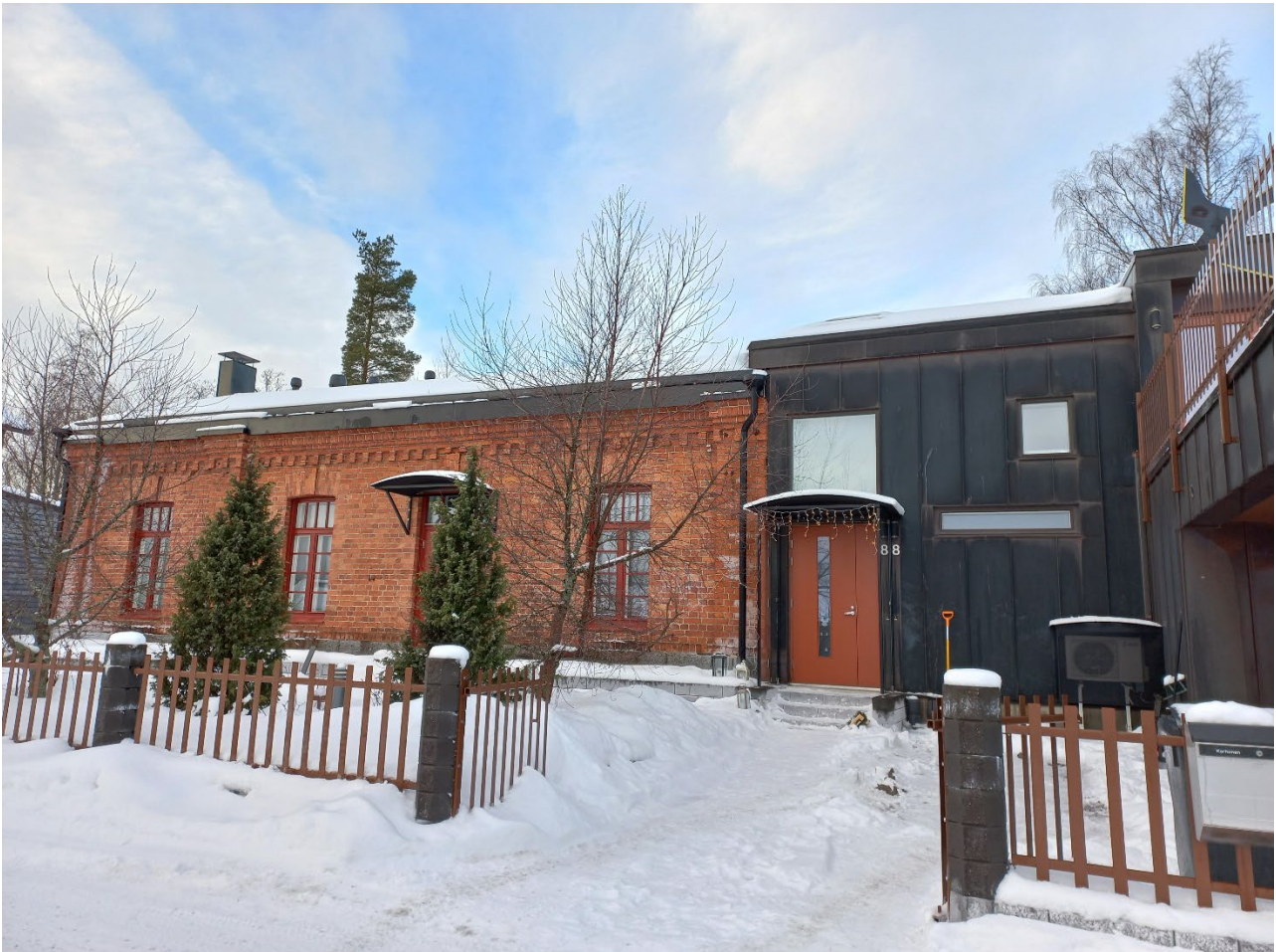
Kuva 31. Entistä varastorakennusta on laajennettu peltikatteisella rakennusosalla käyttötarkoituksen muuttuessa asuinkäyttöön. Kuva 10.1.2024.
