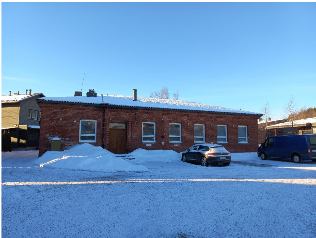
Kuva 39. Entinen saunarakennus sijoittuu taloyhtiön sisäpihalle. Uudisrakentaminen on toteutettu rakennuksen ympärille kaareutuen. Kuva 26.1.2024.
