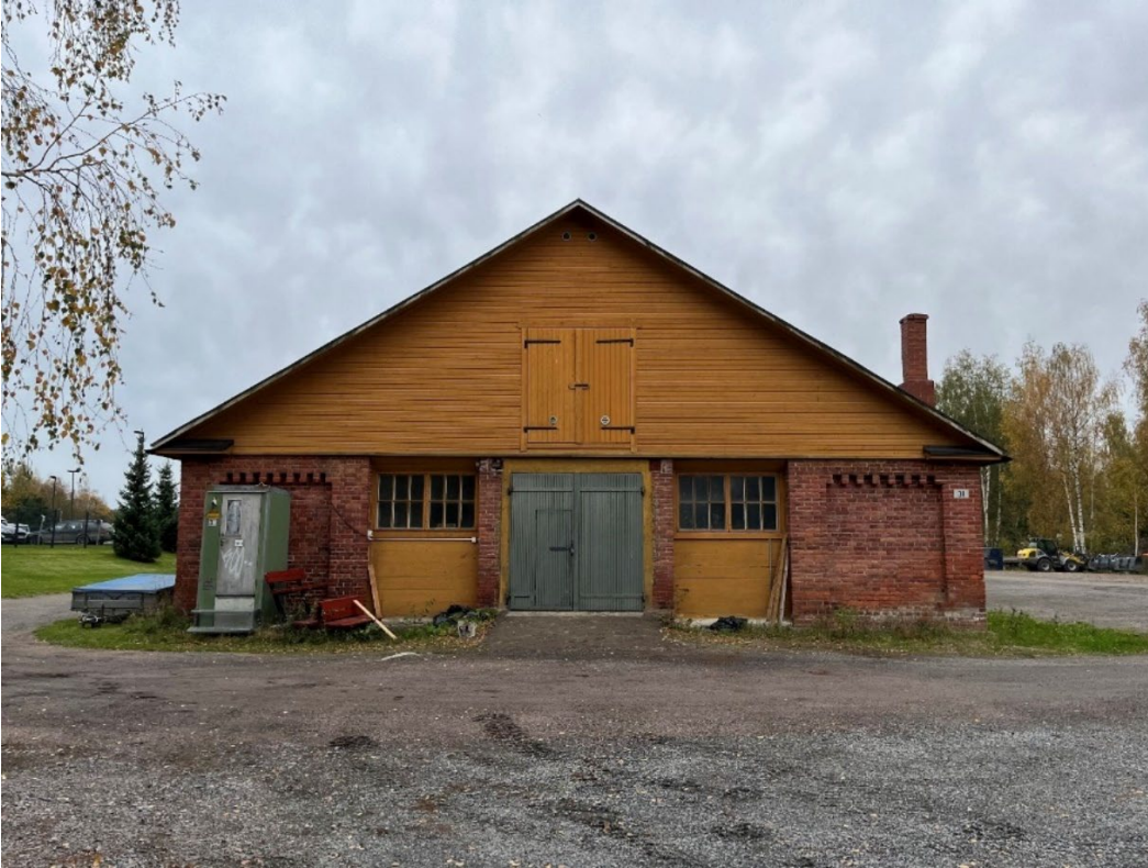
Kuva 60. Kasakkatallirakennus pohjoisesta päin kuvattuna. Kuva 3.10.2023.
