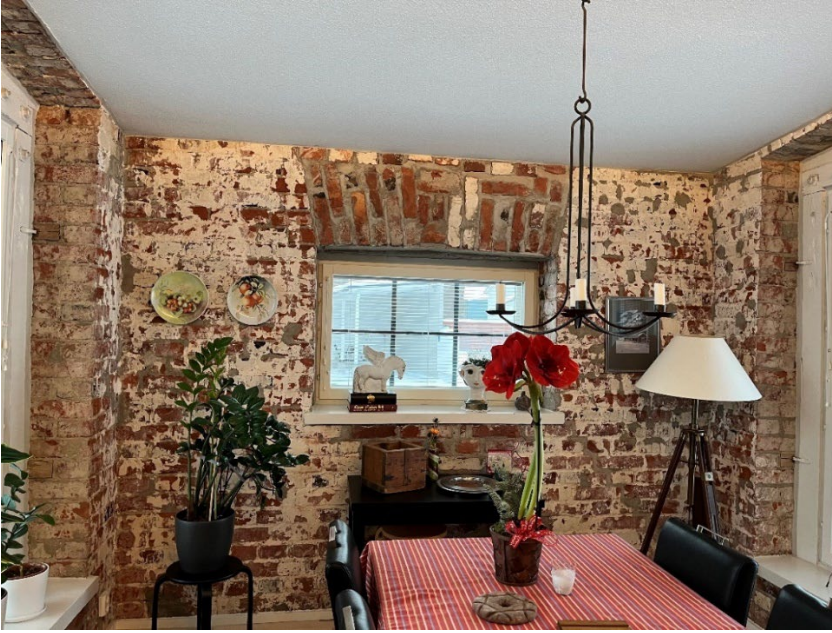
Kuva 29. Lounaispäädyn uloke asunnon sisäpuolelta. Kuva 10.1.2024.
