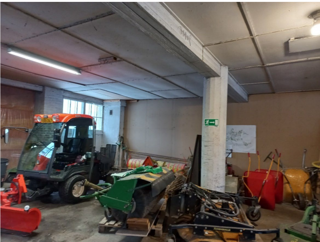
Kuva 69. Tiedossa ei ole milloin rakennukseen on toteutettu lautamuottisia betonitukia. Kuva 10.1.2024.
