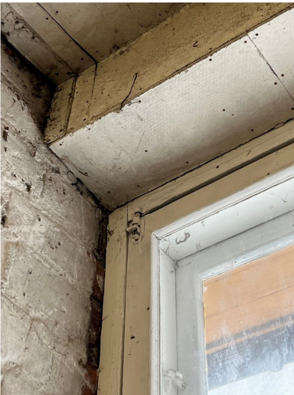
Kuva 83. Yksityiskohta samasta ikkunaruuudusta. Saranoita ei ole, vain helat. Kuva 10.1.2024.
