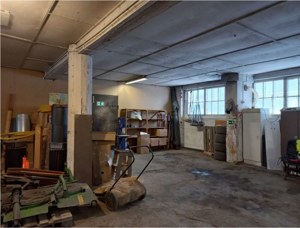
Kuva 70. Keskimmäisen hallitilan ja pohjoispäädyn puuverstaan välissä on kevytrakenteinen väliseinä.
