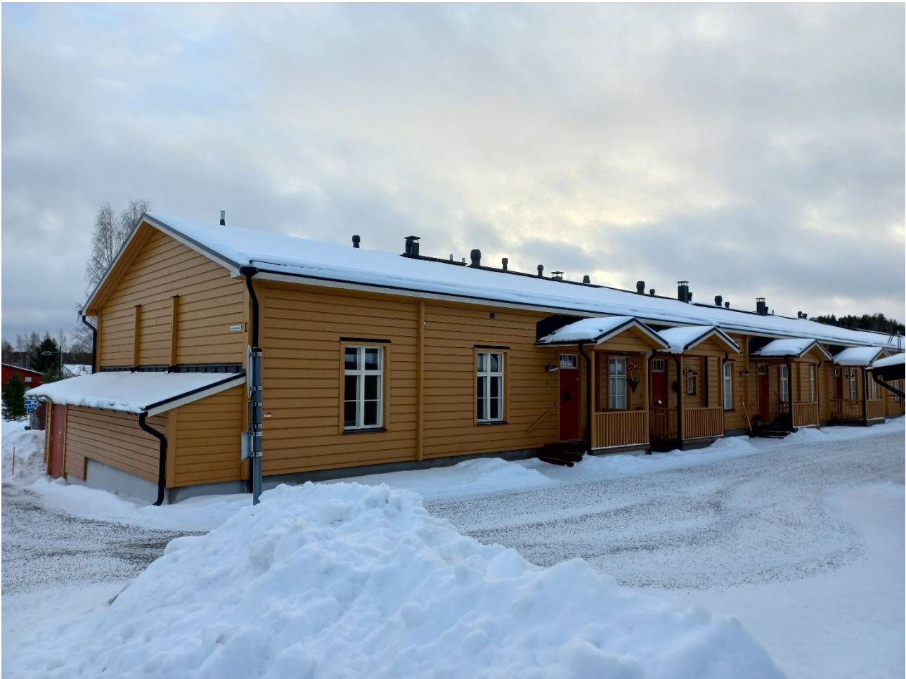
Kuva 25. Entisen sairaalaparakkirakennuksen paikalle toteutui vastaavankokoinen rakennus asuinkäyttöön. Kuva 10.1.2024.
