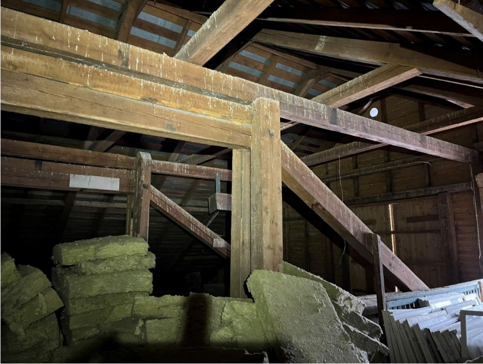
Kuva 74. Rakennuksen välikaton eteläpäätä. Katteen alla on harvalaudoitus. Kate on ilmeisesti uusittu 2000-luvulla. Kuva 10.1.2024.
