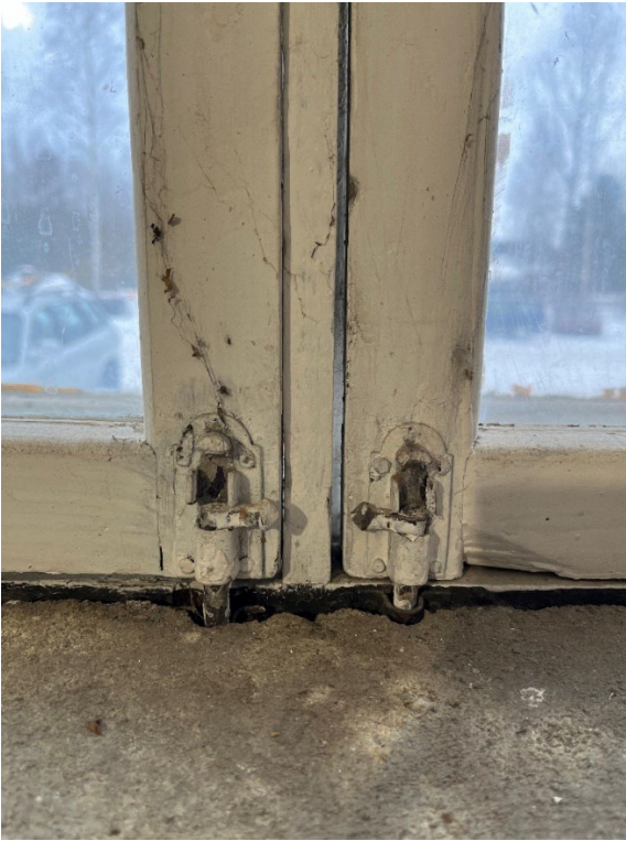
Kuva 81. Rakennuksessa on 28 ikkuna-aukkoa. Yksityiskohta yhden länsisivun ikkunaruuudun keskijaosta.
