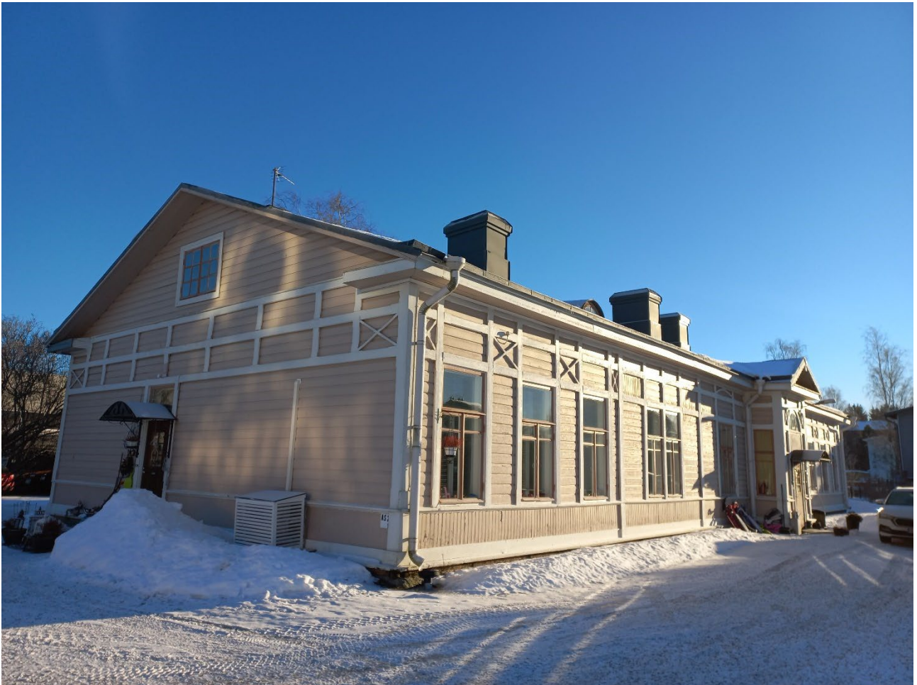
Kuva 40. Hirsirunkoisessa rakennuksessa on nykyisin asuntoja. Rakennus sijoittuu saman taloyhtiön tontille kuin entinen saunarakennuskin. Kuva 26.1.2024.
