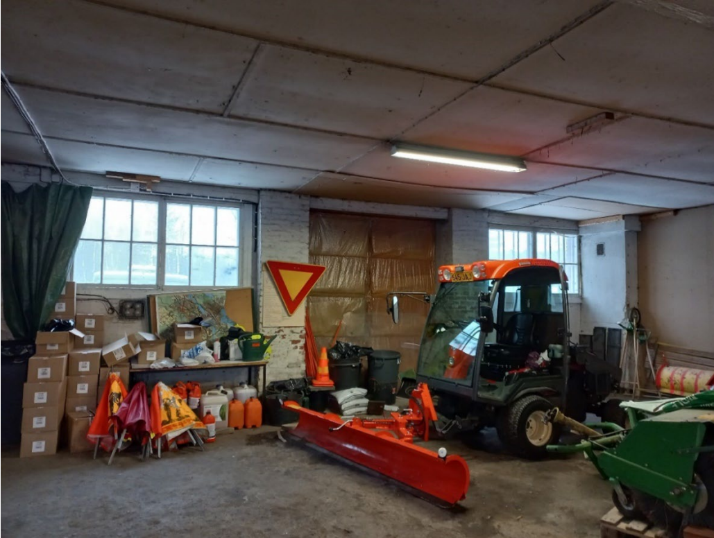
Kuva 68. Keskimmäisen hallitilan vanhoista parioviaukoista toinen on peitetty sisäpuolelta. Kuva 10.1.2024.
