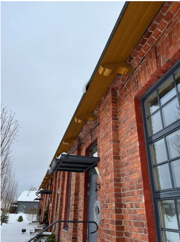
Kuva 30. Räystäiden alapuolisten kattoristikkopuiden päät ovat uusittu vanhaa kunnioittaen. Kuva 10.1.2024.
