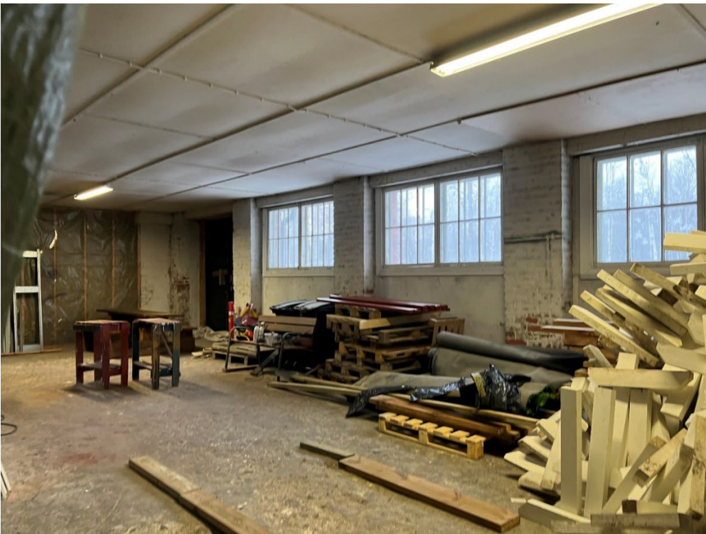
Kuva 63. Kasakkatallirakennuksen pohjoispäädystä toimii vankitoimintaan liittyvä puutyöverstas. Kuva 10.1.2024.
