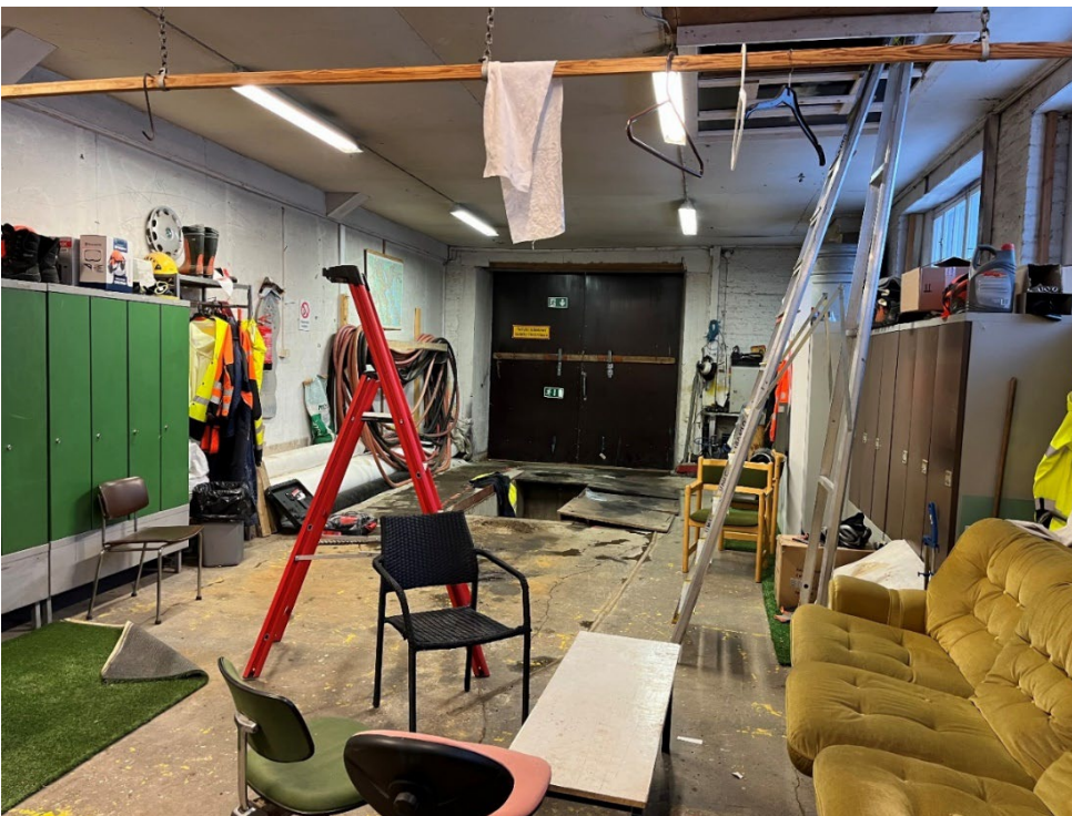
Kuva 71. Kasakkatallirakennuksen eteläpäädyssä on henkilökunnan taukotilaa ja lokerikkokaapistot. Talliovien edessä on ajoneuvohuoltoa varten aikoinaan tehty rasvamonttu.
