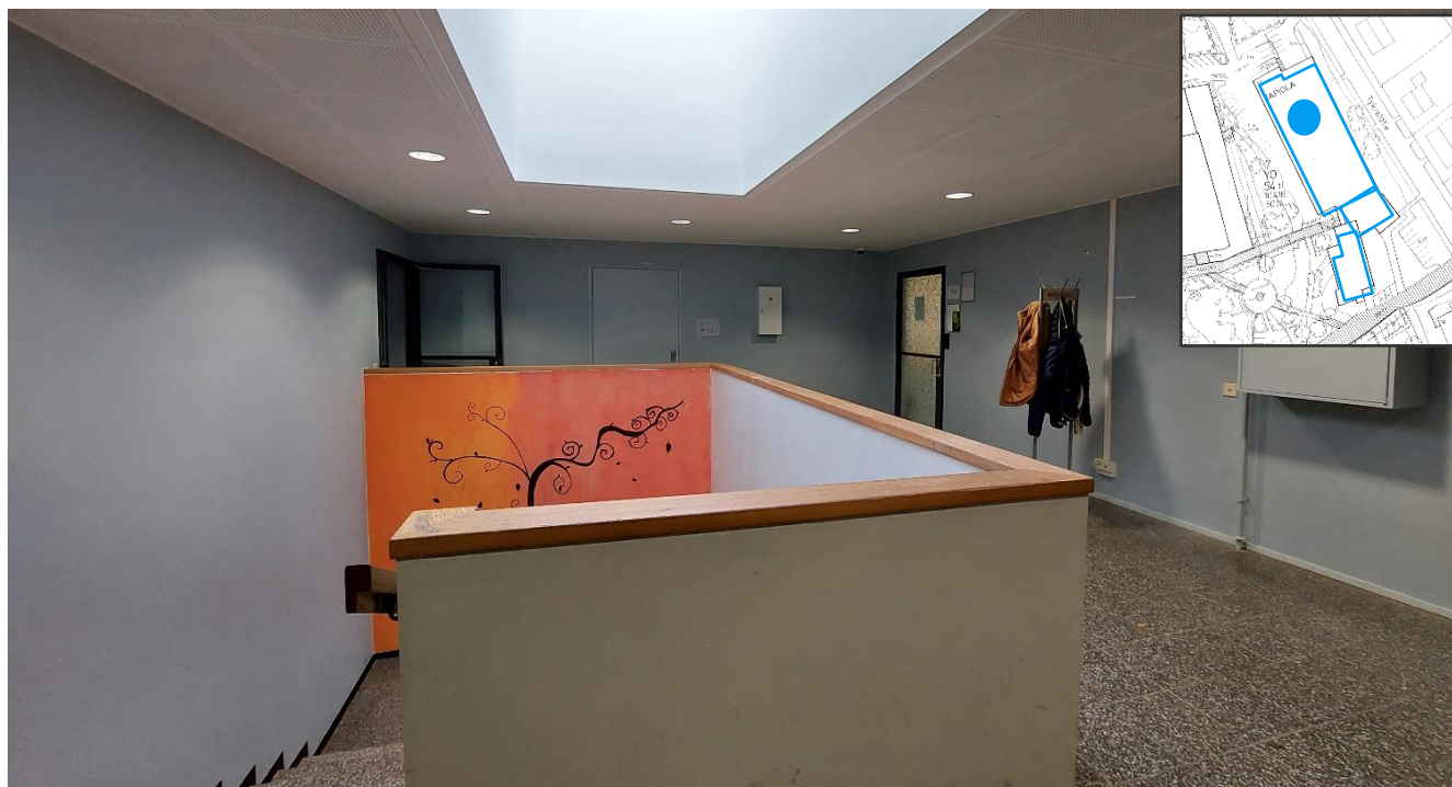
Kuva 71. Käytävien varrella, rakennuksen rungon keskellä on kolme samanlaista porrashuonetta, joihin kattoikkunat tuovat luonnonvaloa.
