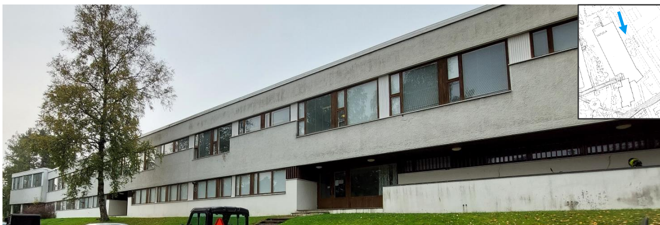
Kuva 63. Tapiolan itäisellä julkisivulla on kaksi sisäänvedon ansiosta katettua sisäänkäyntiä.
