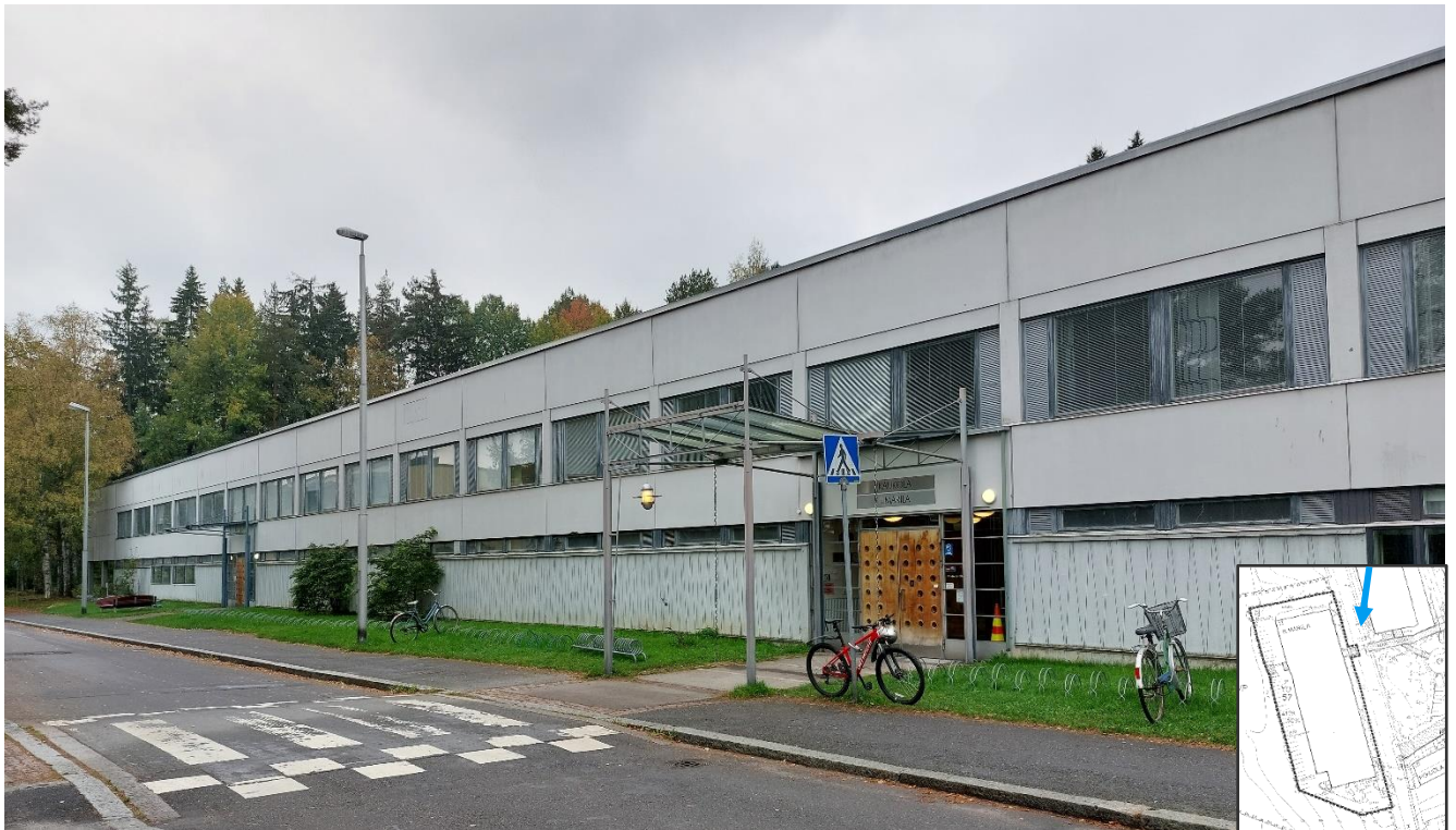
Kuva 134. Katujulkisivu on Ilmarilan näyttävin julkisivu.
