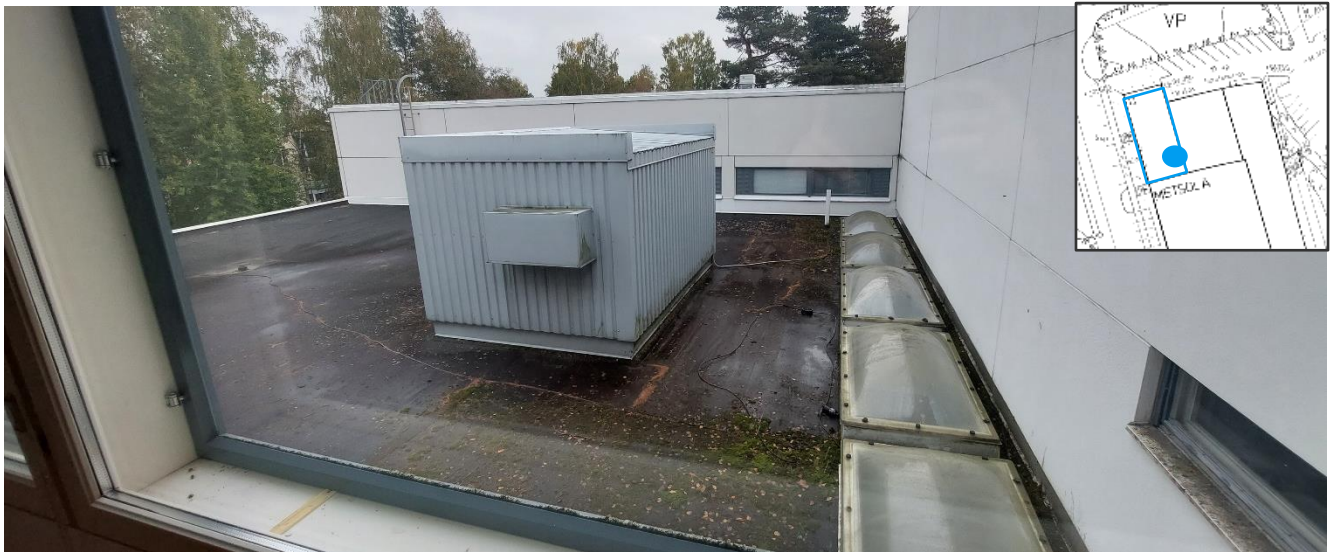
Kuva 116. Toisen kerroksen asunnosta näkyvät auditorion katon päälle asennettu IV-kone ja kattoikkunat sekä oikeassa reunassa porraskäytävän matalat ikkunat.
