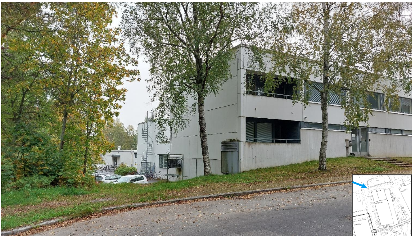
Kuva 99. Rakennusten pohjoisseinät ovat pääasiassa ikkunattomat.
