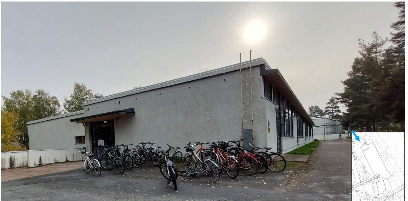
Kuva 65. Pihakannen päällä on pyörien säilytyspaikka ja saneerauksessa lisätty sisäänkäynti toiseen kerrokseen.
