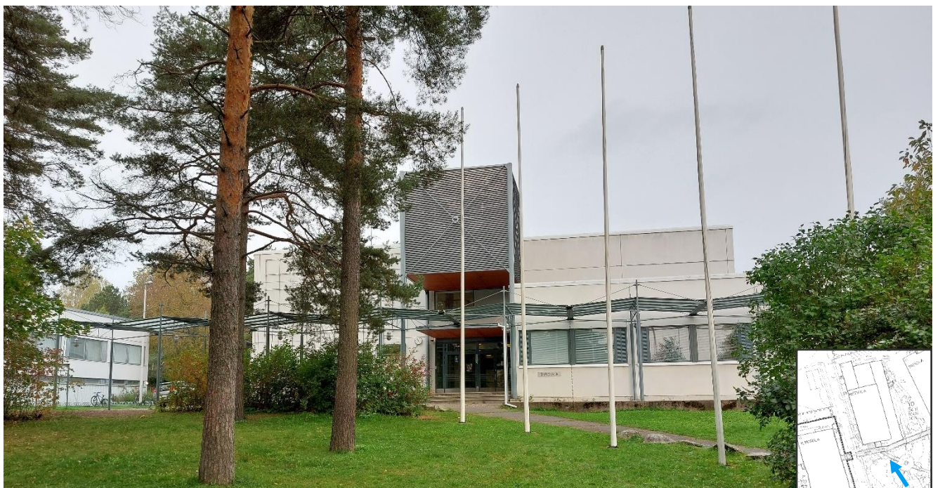
Kuva 94. Metsolan eteläinen julkisivu oleskelupihalta kuvattuna. Pääsisäänkäynnin tummat puupaneloinnit korostuvat vaaleassa taustassa. Yhdyskatos on kevyt ja sulautuu rakennuksen ulkonäköön.
