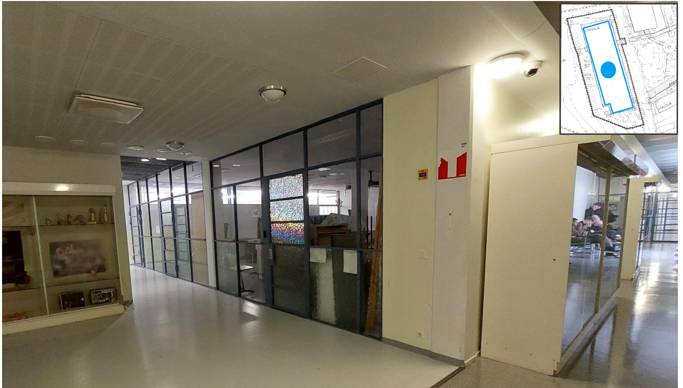
Kuva 143. Kapeita, rungon sisäisiä käytäviä on kevennetty lasiseinillä ja -ovilla.
