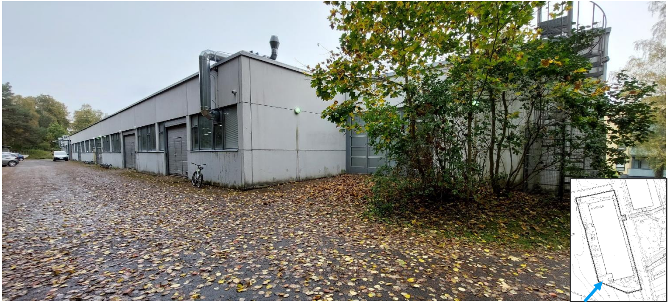
Kuva 137. Lounaiskulmassa on sisäänkäynti ylemmän kerroksen työopetustiloihin, jotka on remontoitu jo 1980-luvulla.
