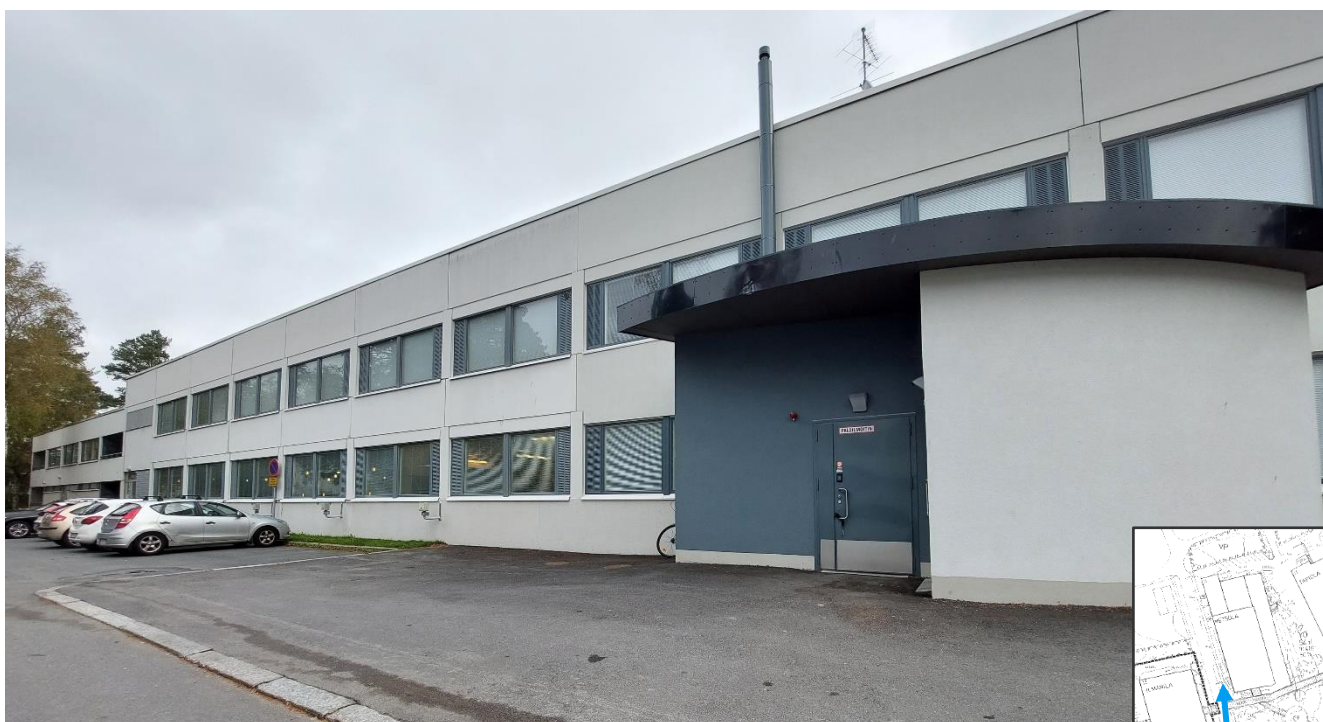
Kuva 101. Metsolan uusi osa on keittiön huoltokatos, joka uudelleenrakennettiin tulipalon jälkeen al- kuvuodesta 2020.
