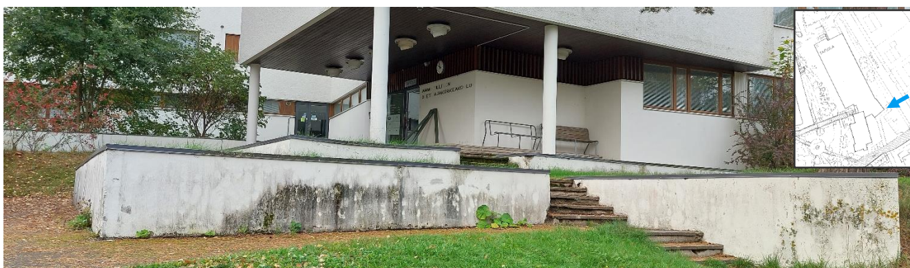
Kuva 62. Betonisilla tukimuureilla on muotoiltu rinteistä piha-aluetta.
