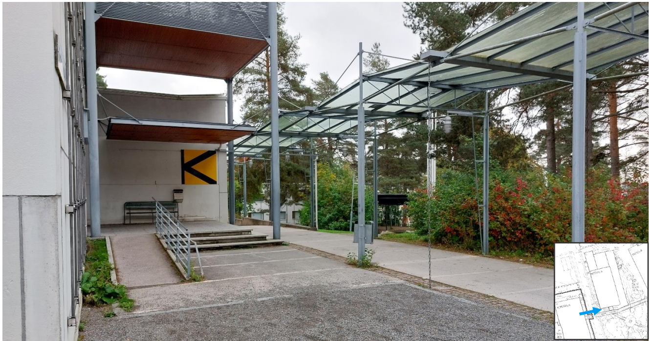
Kuva 93. Metsolan pääsisäänkäyntiä korostavat teräs-puupaneli-katos ja suuri opaste.
