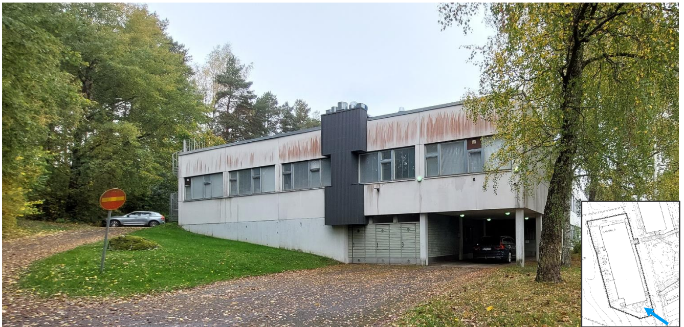
Kuva 136. Eteläjulkisivulla nähdään pohjakerroksen sisäänveto Rinnetien puoleisessa kulmassa. Sen viereiset puupaneloidut ovet ovat alun perin johtaneet kemikaalien varastointitiloihin.
