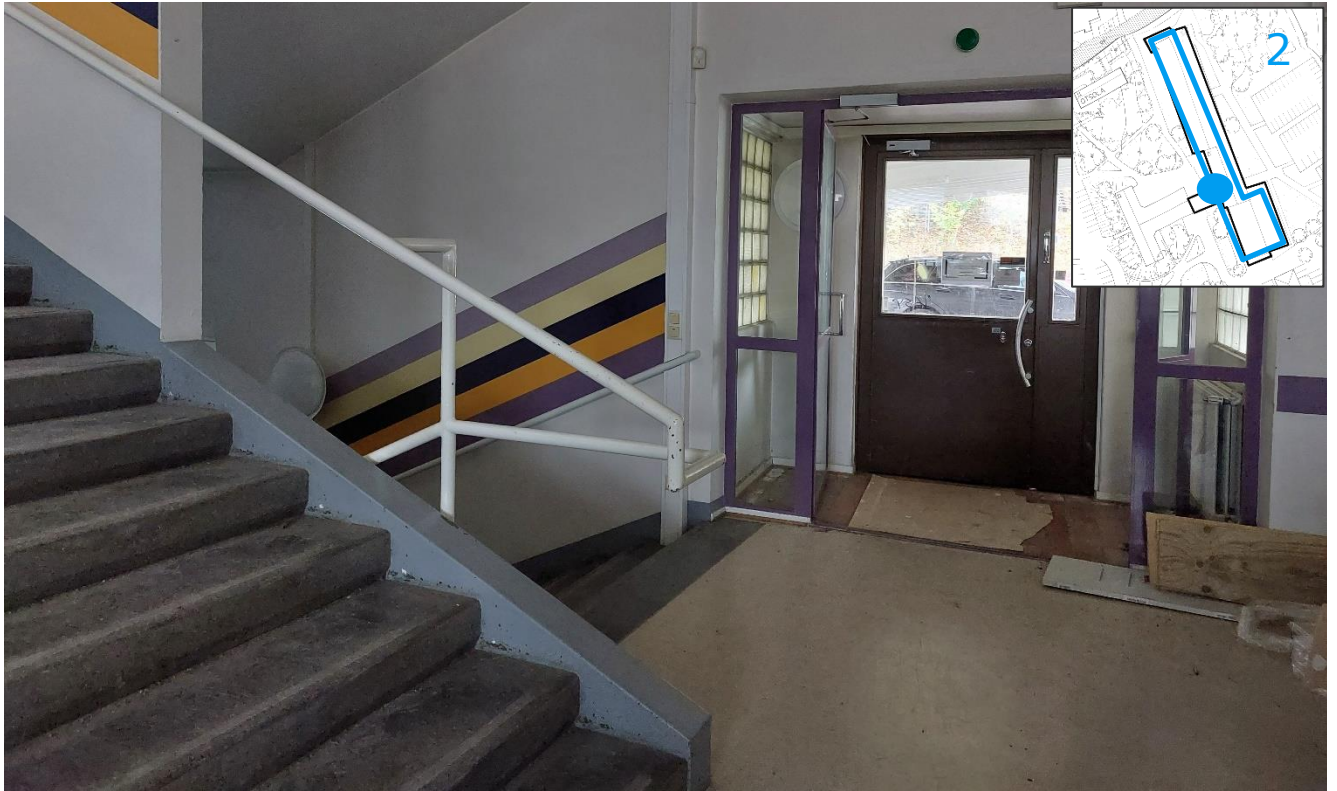
Kuva 41. Pääsisäänkäynti johtaa aulaan ja pääportaikkoon.
