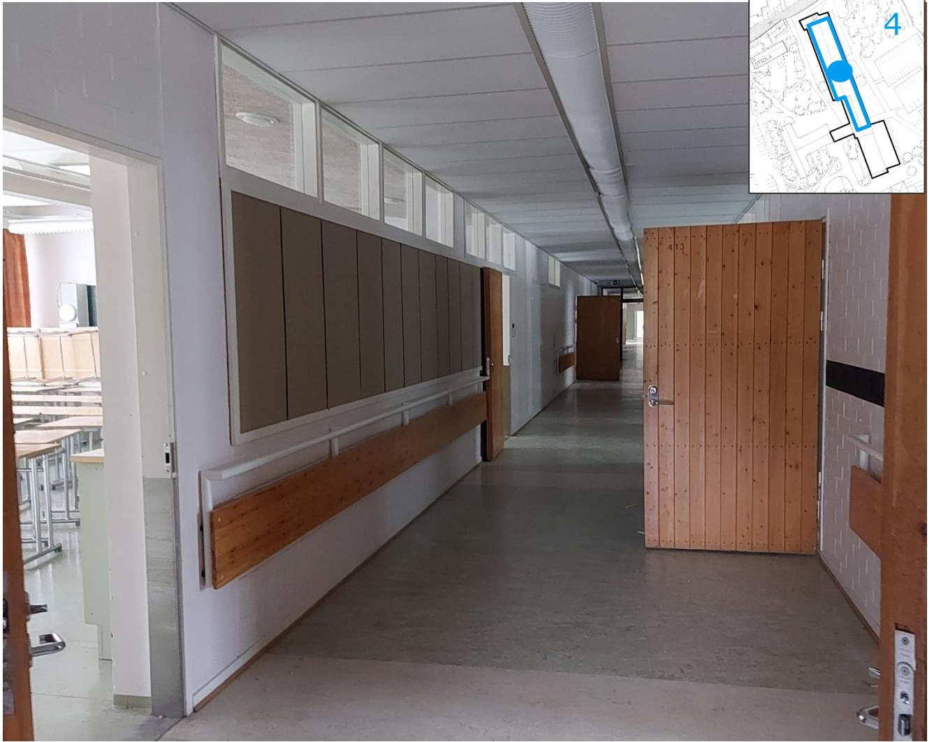
Kuva 44. Keskipäivätilalle on tuotu luonnonvaloa väliseinän yläosan ikkunoilla.
