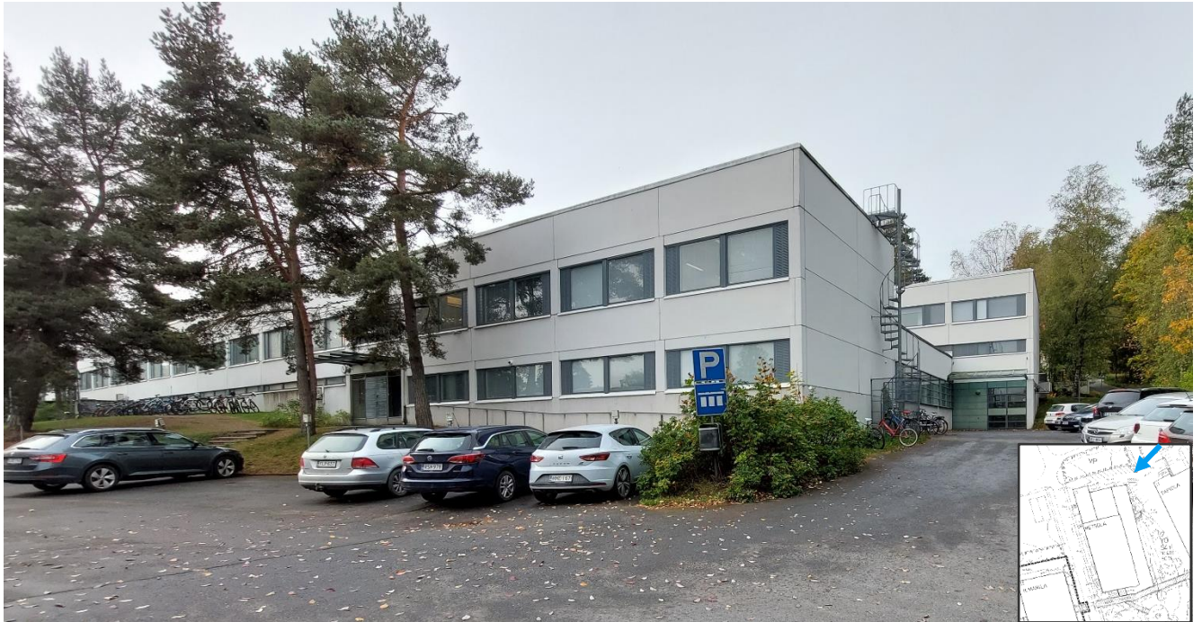
Kuva 98. Metsolan koillis- ja pohjoispuolella on opetustiloja pohjakerroksessakin. Taustalla näkyvän asuntolasiiven pohjakerroksessa näkyy musiikkiluokkatilojen sisäänkäynti.
