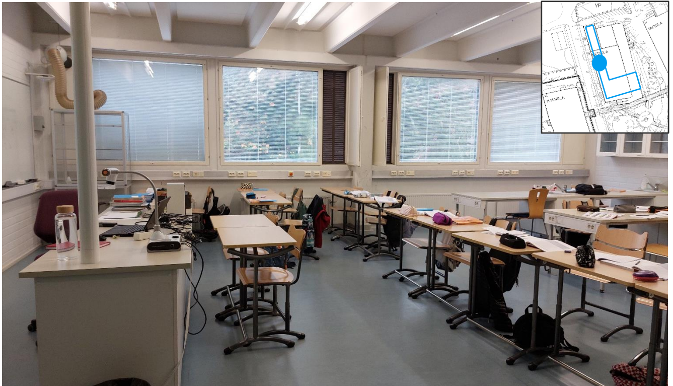
Kuva 109. Luokkatiloissa jatkuu rakennuksen selkeä tyyli ja värimaailma. Rakennuksen pilari-palkki-rakenne erottuu hyvin, sillä luokissa ei ole alakattoja.
