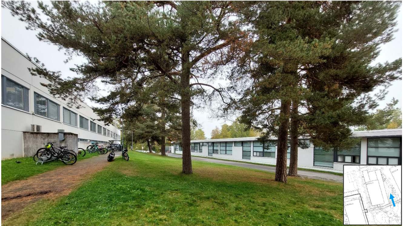
Kuva 96. Metsolan pohjakerroksen kaakkoiskulmassa sijaitsee väestönsuoja ja pukuhuoneita. Ikkunattomalla julkisivuosalla säilytetään polkupyöriä. Kuvan oikeassa reunassa näkyy rinteessä alempana sijaitseva Tapiola.
