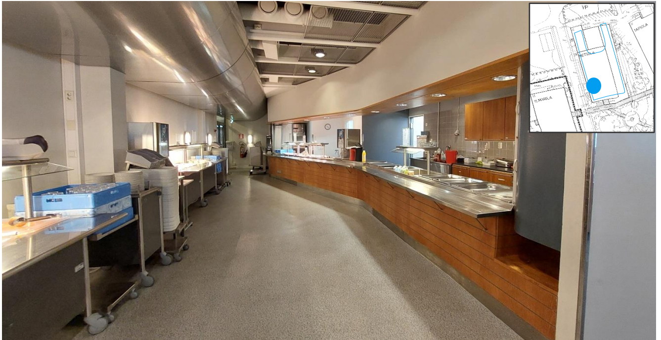
Kuva 105. Liikuntasalin ovien vieressä on kulku 2020-luvulla uudistetulle ruokalan linjastolle. Alakattojen sijaan talotekniikkaa on piilotettu vasemmalla, erikoisruokavaliolinjaston päällä näkyvän metallirakenteen taakse.
