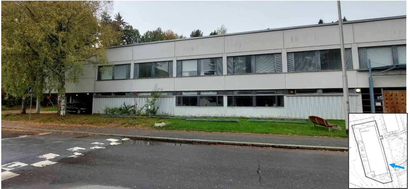
Kuva 135. Ilmarilan kaakkoiskulma on pohjakerroksesta avonainen. Ylempää kerrosta kannattelevat pilarit. Pohjakerroksen seinän säleiköllä ei kasva köynnöskasveja. Ikkunoita on laajennettu.
