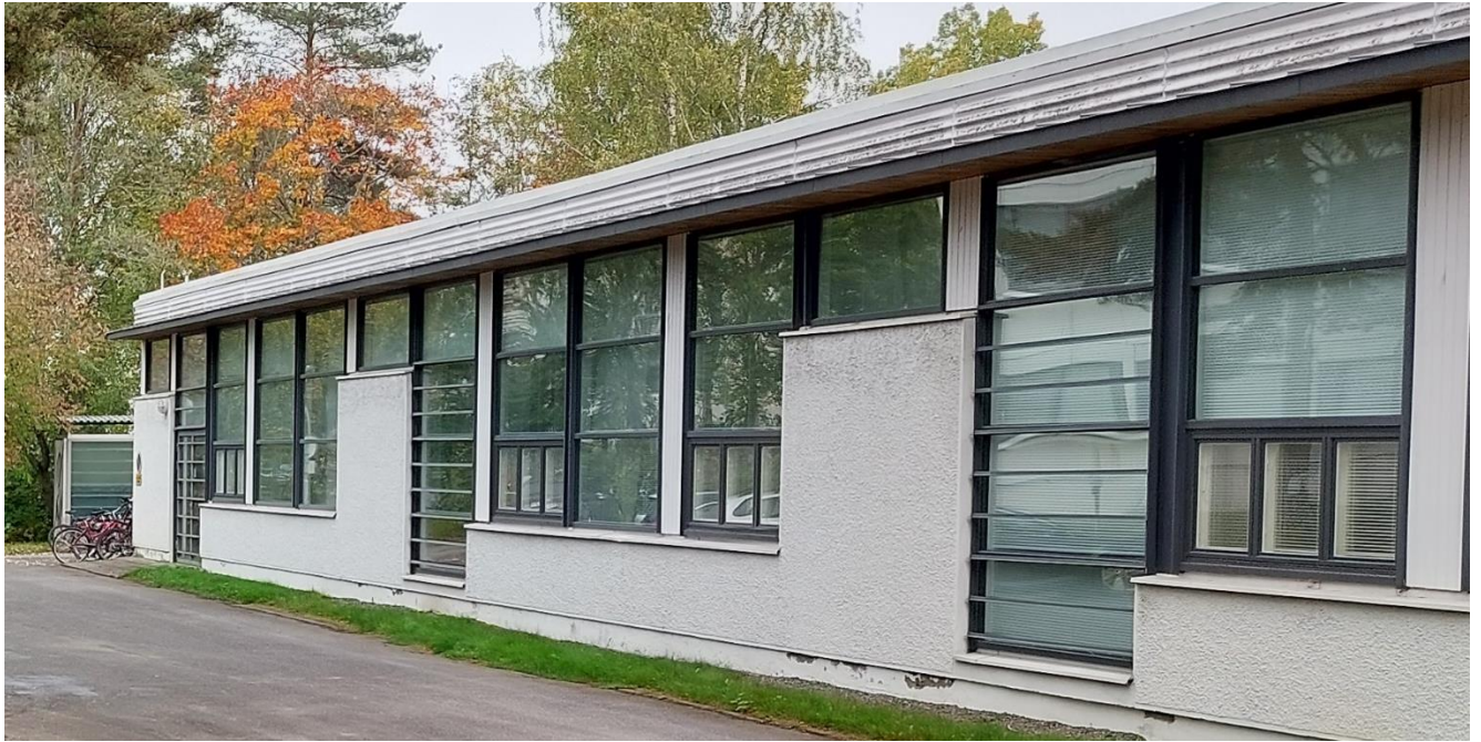
Kuva 59. Länsijulkisivulla on muutettu aukotusta ja poistettu työpajojen ulko-ovet. Ajankohta on epäselvä.
