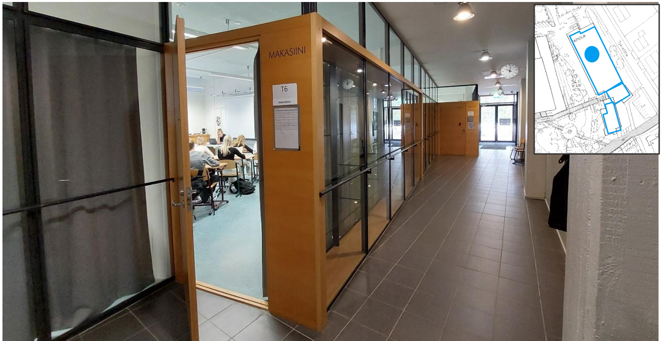
Kuva 72. Ylemmän kerroksen luokkatilat ja niitä yhdistävät käytävät on muotoiltu uudestaan kevyillä lasiseinillä, joissa on käytetty tehosteena puupanelointia.
