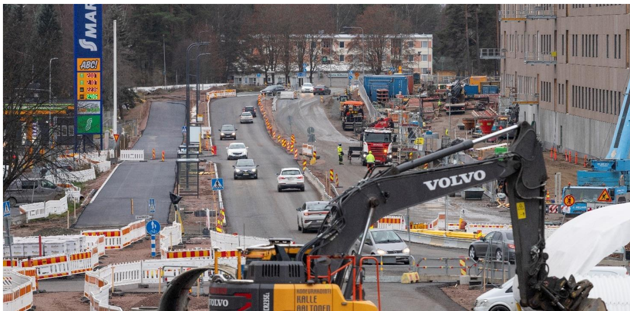
Kuva 6 Ahvenistontien rakennustyöt saatiin arviointivuoden aikana päätökseen.
