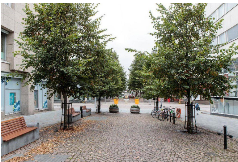
Kuva 32. Vuonna 2004 toteutetulla kävelykadun jatkeella on käytetty pääasiassa luonnonkiveä eri muodoissa; punertavaa noppakiveä suomuladonnalla sekä harmaita graniittilaattoja roomalaisella ladonnalla.
