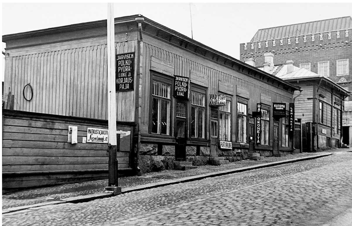
Kuva 21. Sibeliuksenkatu. Ensimmäisessä vaiheessa ajoradan keskelle vaihdettiin nupukivet hevoskärryjä varten, kun reunoilla säilyivät vielä mukulakivet.
