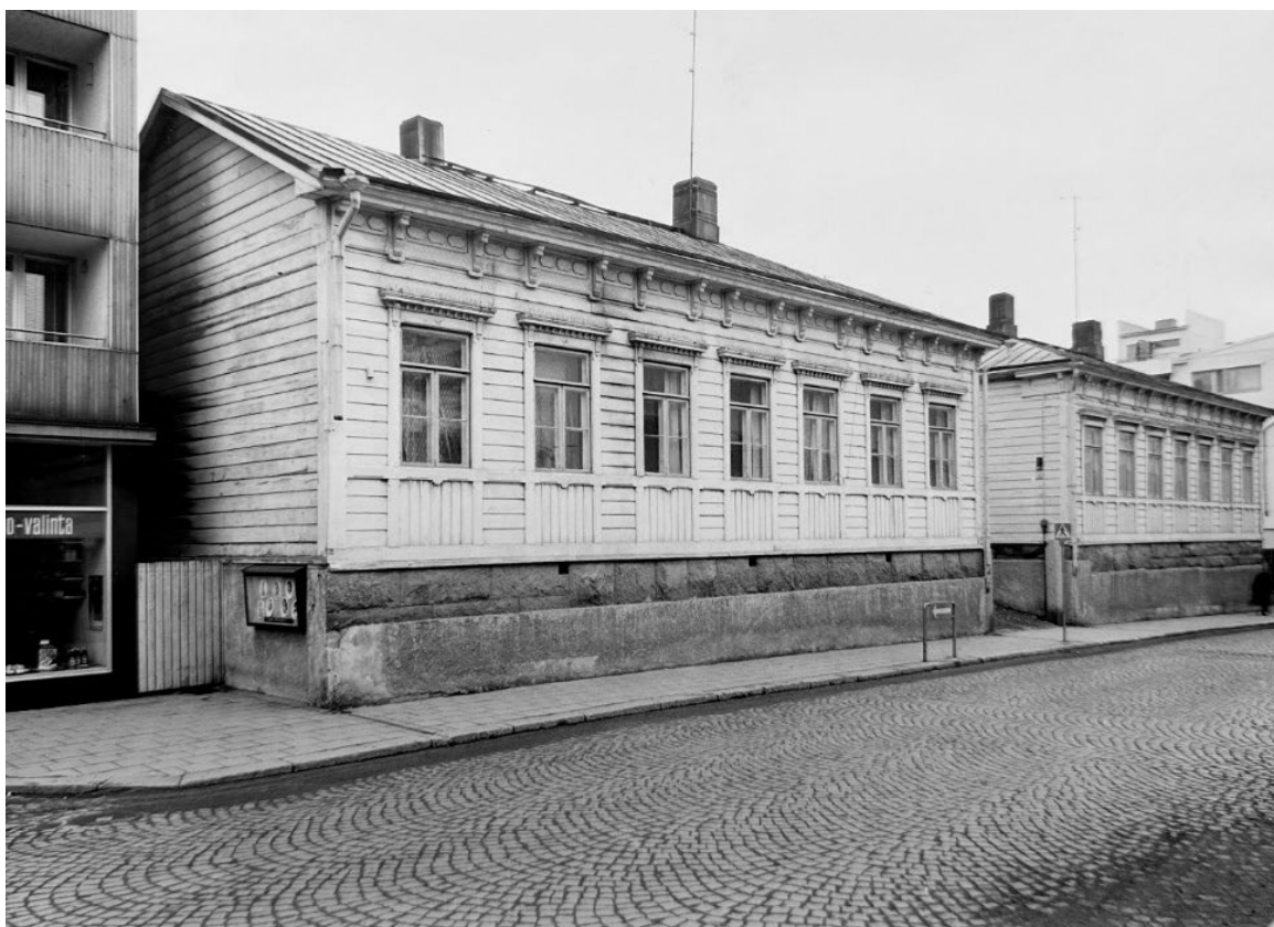
Kuva 25. Kaariladottuja noppakiviä Hallituskatu 6 kohdalla.
