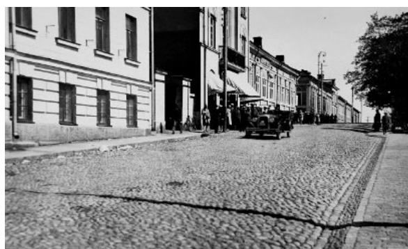
Kuva 22-23. Hallituskadun katupinnoituksenmuutos mukulakivestä nupukiveen torin kohdalla.
