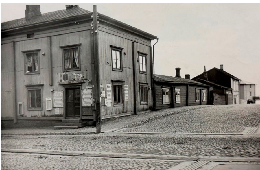
Kuva 11. Raatihuoneenkadun ja Rauhankadun kulma.
