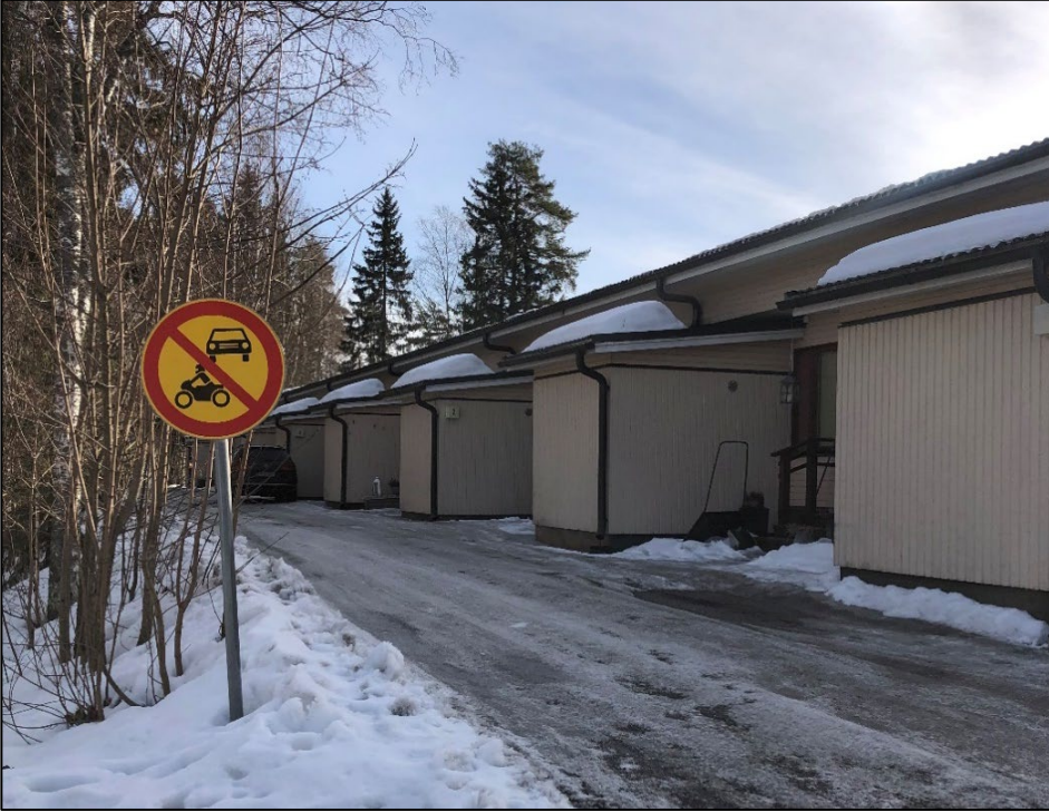
Kuva 7. Kuvassa näkyy rakennus pääsisäänkäyntien ja varastojen puolelta.
