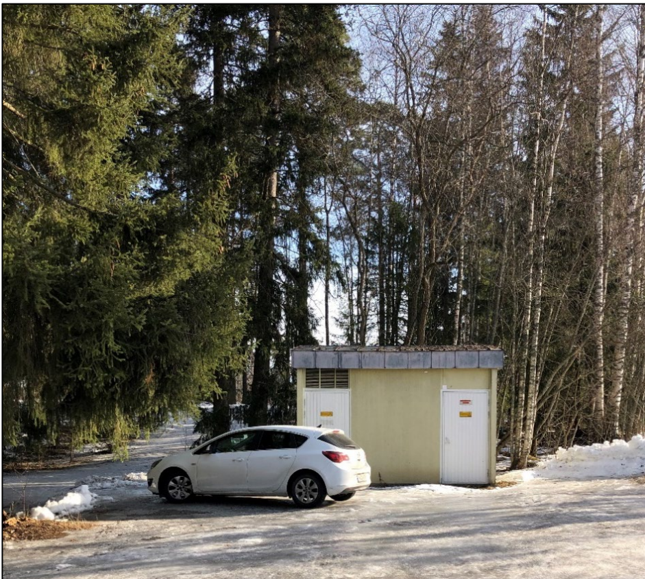
Kuva 8. Kuvassa näkyy tontin vieressä sijaitseva muuntamo.
