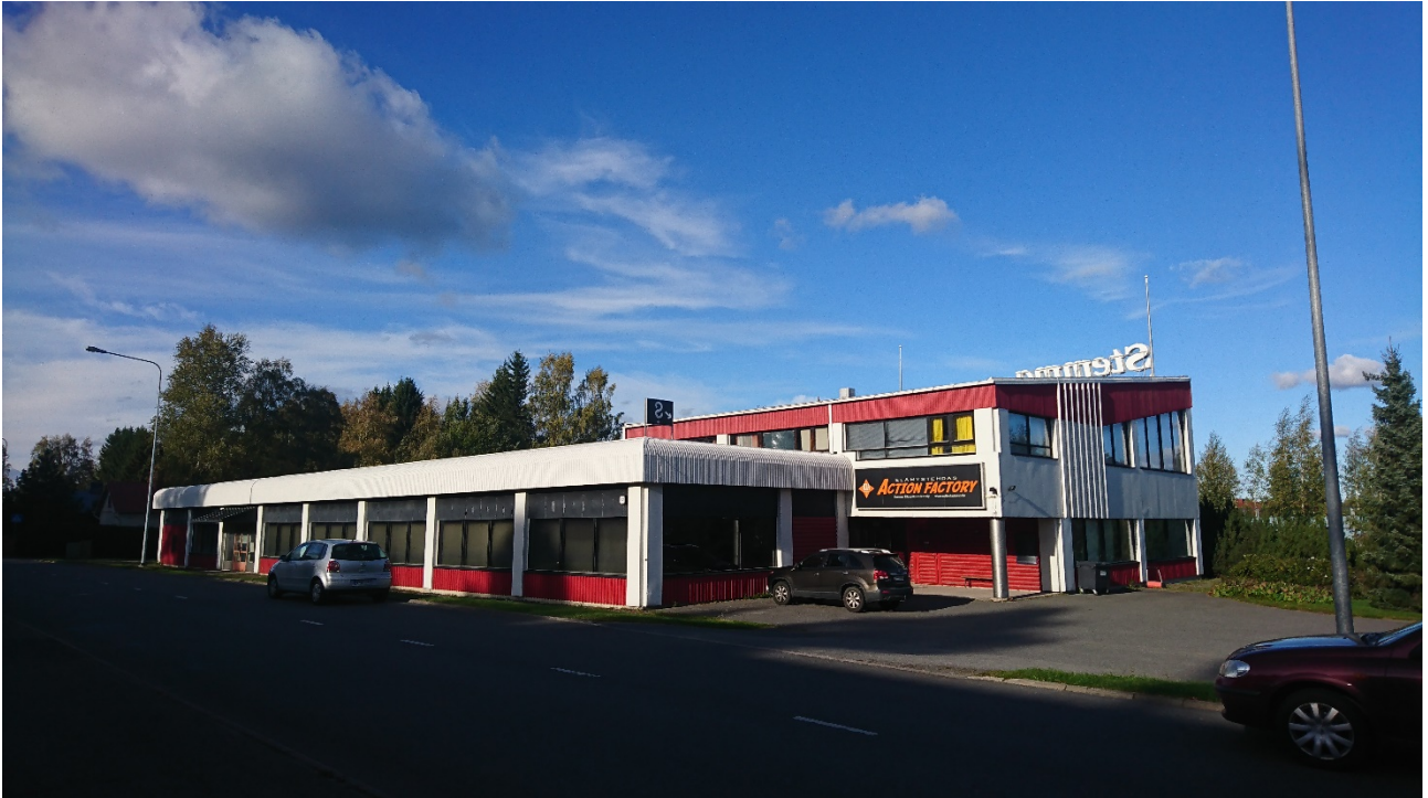
Myymälärakennus suunnittelualueen pohjoisosassa.
