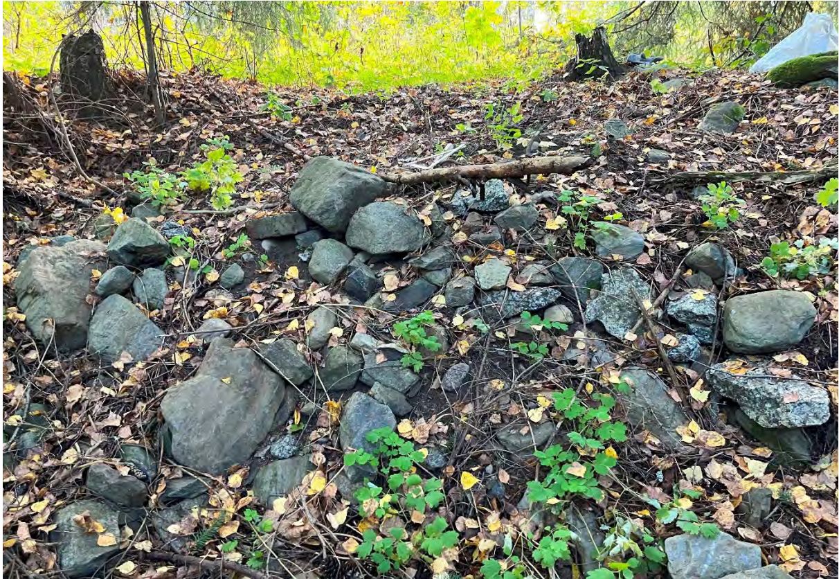
Kuva 18. Rakennuksen eteläpuolen rinteeseen on todennäköisesti tuotu kiviä rakennuksen purkamisen jälkeen. Tähän viittaavat ainakin kivien keskenäinen erilaisuus. Kuvattu etelään.
