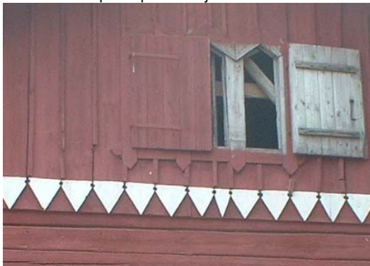
Koristeellisesti lovetut leveiden pystylautojen päät. Peiterimat ovat ohuet.
