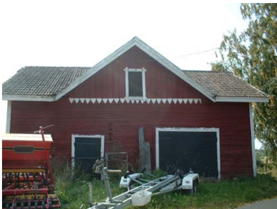
Rakennuksen pihan puoleista julkisivua.
