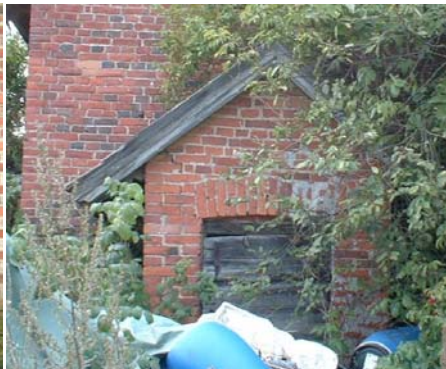
Kellarin ovi on Vanajaveden puoleisessa päädyssä.
