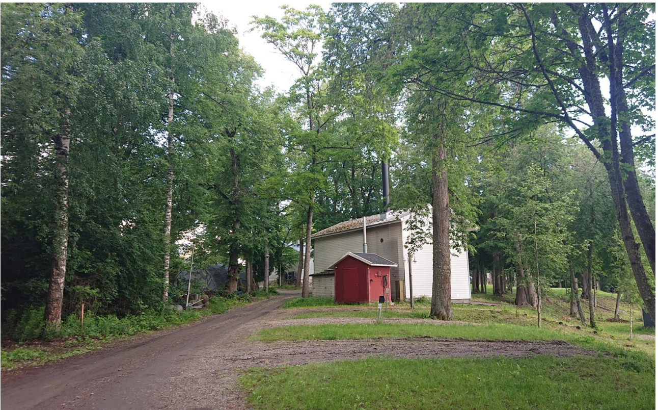
Kuva 13. Lämpölaitos Vanajaveden suunnasta 14.6.2024 kuvattuna.
