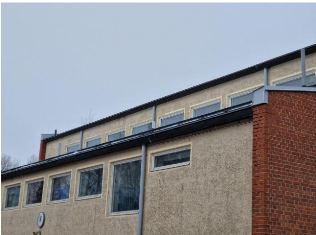
Kuva 36. Rakennuksen vesikatto on uusittu saneerauksen yhteydessä.
