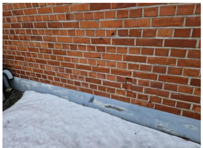
Kuva 26. Tiilipinnoissa vaurioita.
