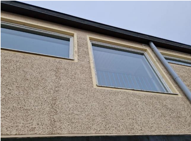
Kuva 27. Rakennuksen ikkunat ovat alkuperäiset.
