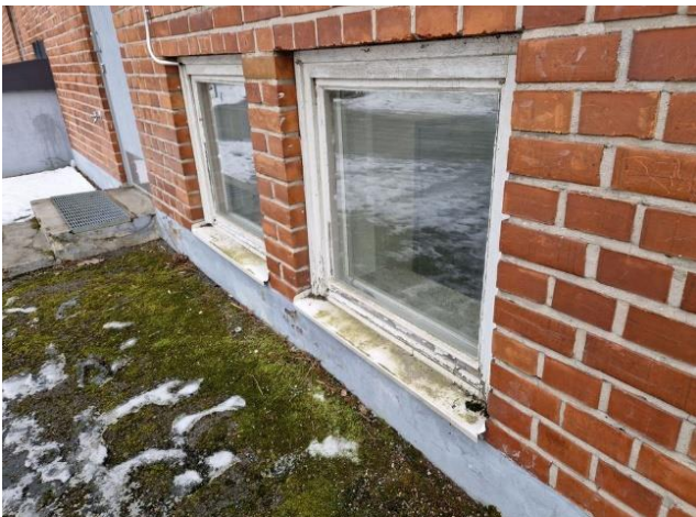
Kuva 29. Rakennuksen ikkunat ovat alkuperäiset.
