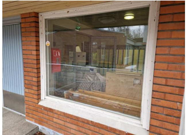
Kuva 28. Rakennuksen ikkunat ovat alkuperäiset.
