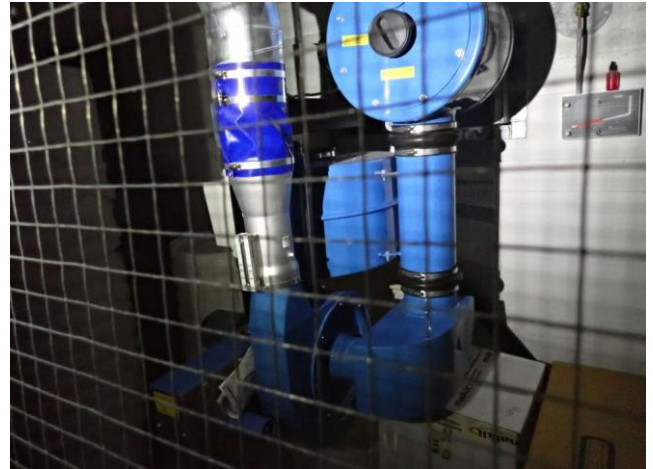
Kuva 21. Väestönsuojan laitteisto.
