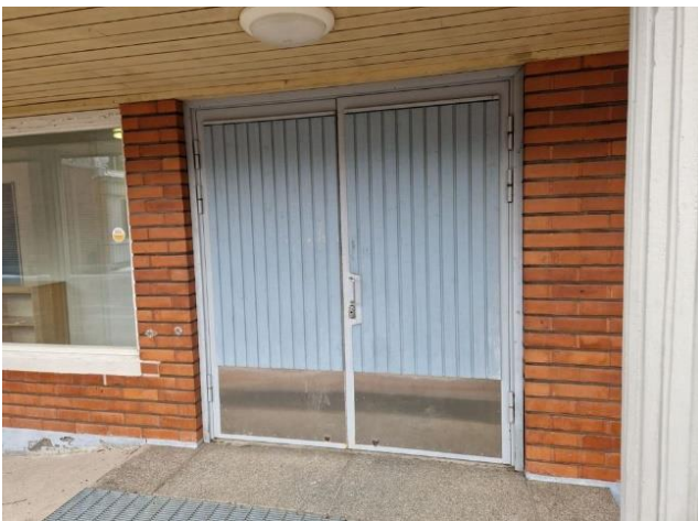
Kuva 33. Rakennuksen ulko-ovet ovat alkuperäiset.
