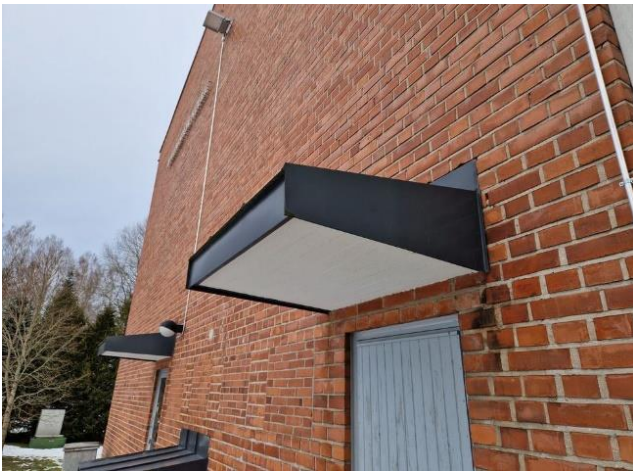
Kuva 35. Sisäänkäyntien yläpuolella on teräsrakenteisia katoksia.
