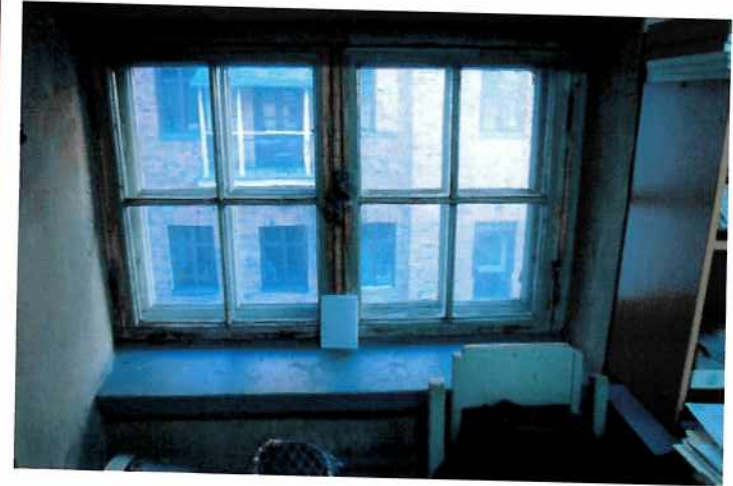
Ikkuna 2. kerroksen välitilassa
