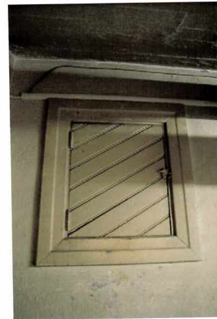
Luukku ovettomaan tilaan 2. kerroksessa
