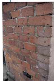
Hiekkapuhallettu tiiliseinä pihan puolella
