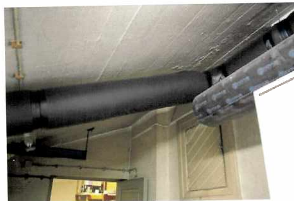
Iv-putket ovat näkyvissä
