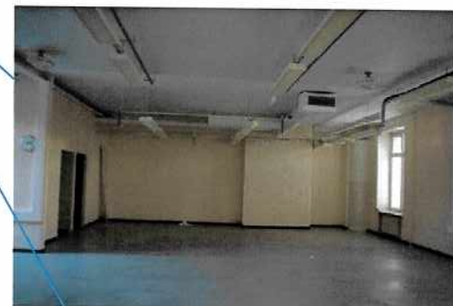
Luokkatiloissa on runsaasti sähkö- ja jäähdytysputkivetoja
