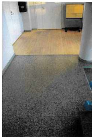
Tornin porrashuoneen mosaiikkibetoni lattia on hyvässä kunnossa
