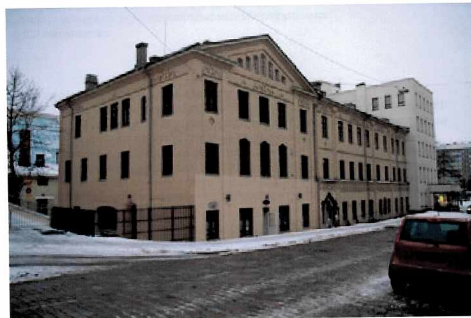
Wetterhoffintalo nykykunnossa, aita lisättiin 2011 remontin yhteydessä
