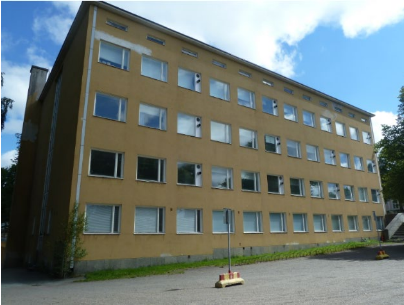
Kuva 1. Keskuskoulu lännen, hiekkakentän, puolelta.
