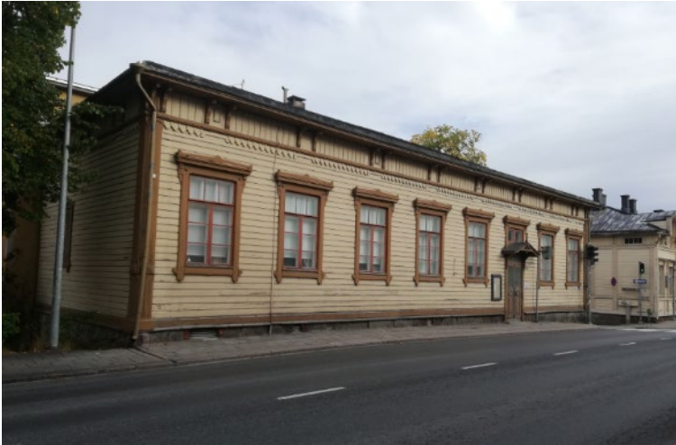
Kuva 3. Gaddin talon puinen yksikerroksinen osuus, rakennettu 1877-1881.
