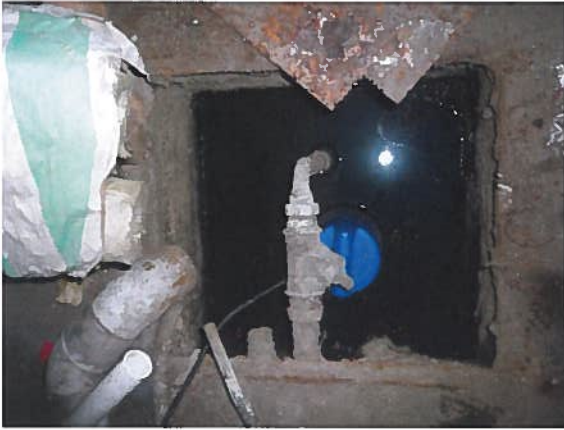
Kaivo K kellarissa
