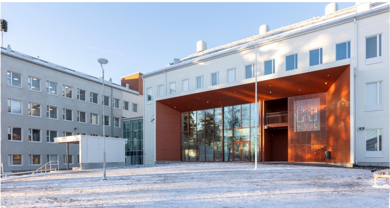
Kuva 5: Hämeenlinnan yhteiskoulun (HYK) uudisrakennus otettiin käyttöön tammikuussa 2025.
