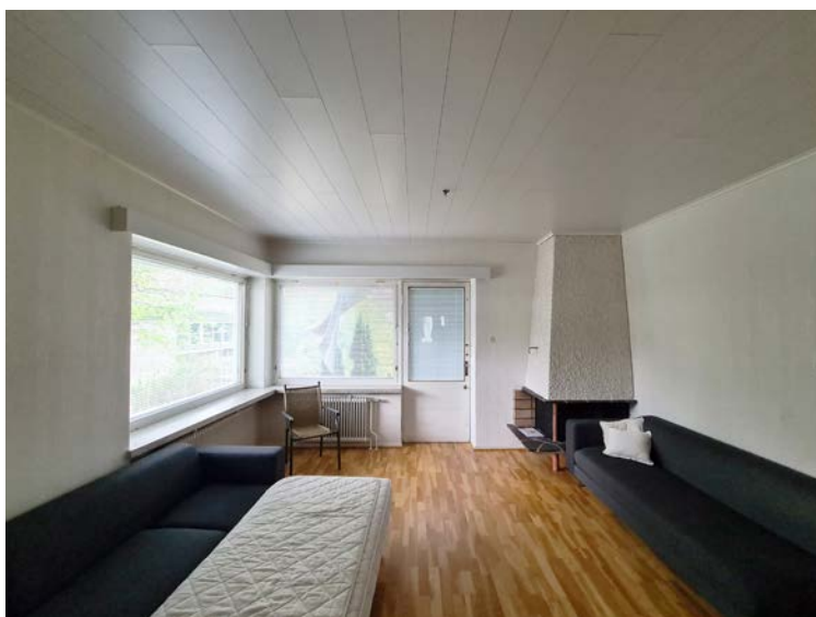
Kuva: 156. Rehtorin asunnon olohuoneen nurkassa sijaitsee myös arkkitehdin suunnittelema avotakka. Takka on rakenteeltaan asuntolan takkaa kevyempi, sillä sen tukeutuminen lattiaan on täysin takan metallijalan varassa.
