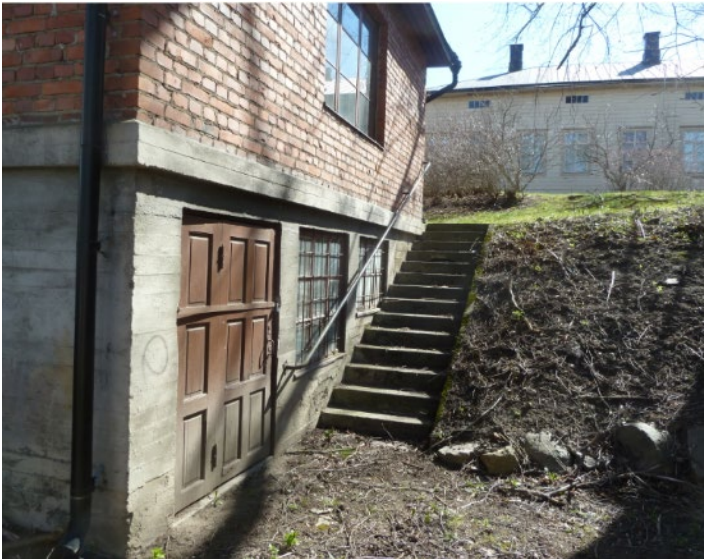
Kuva 12. Puiseen talousrakennukseen liittyvä tiilinen saunaosa.
