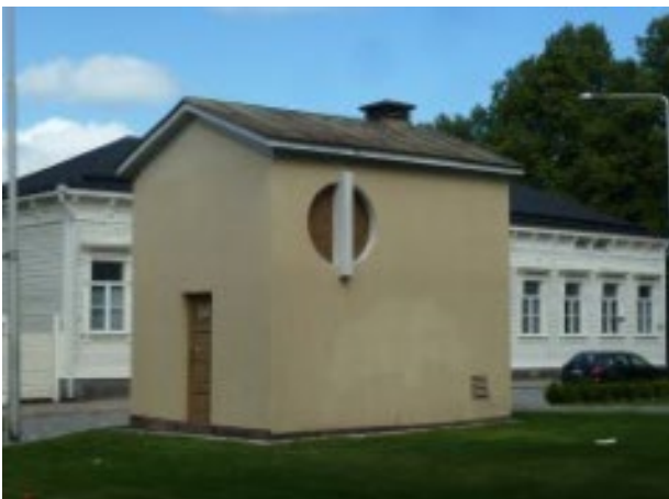
Kuva 21. Muuntamorakennus, joka on valmistunut vuonna 1937.
