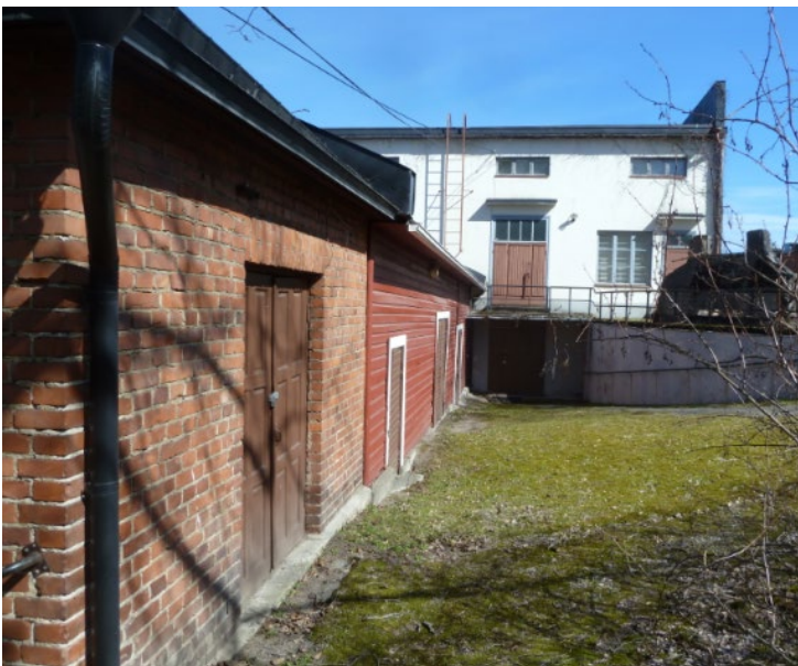
Kuva 10. Palanderin talon pihassa oleva talousrakennus ja ns. kivipiirin rakennus.
