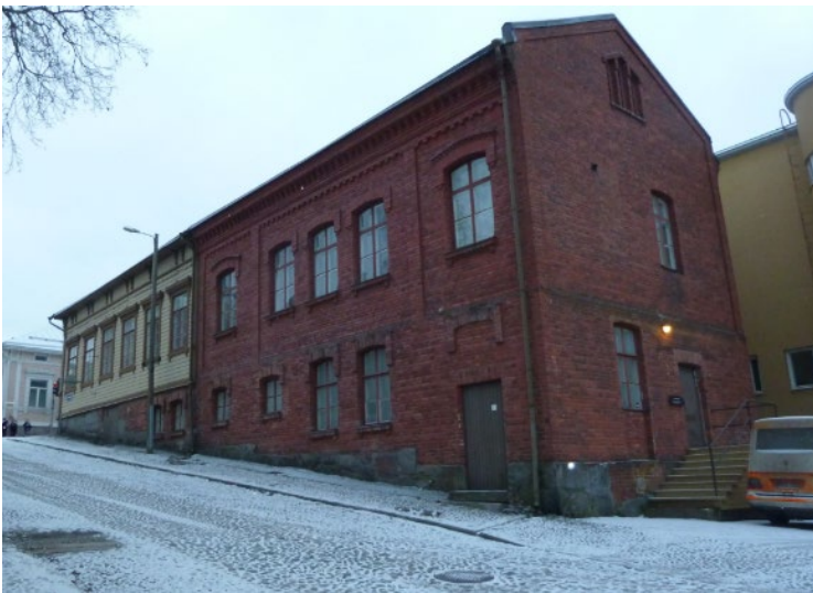
Kuva 4. Gaddin talon kaksikerroksinen tiiliosuus, rakennettu 1877-1881.
