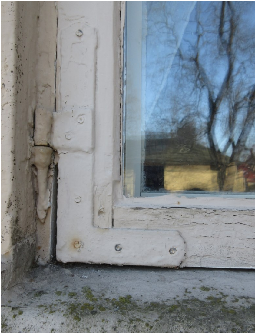
Linnankadun päädyssä ja pihasivuilla ikkunat ovat vanhempaa 8-ruutuista mallia.
