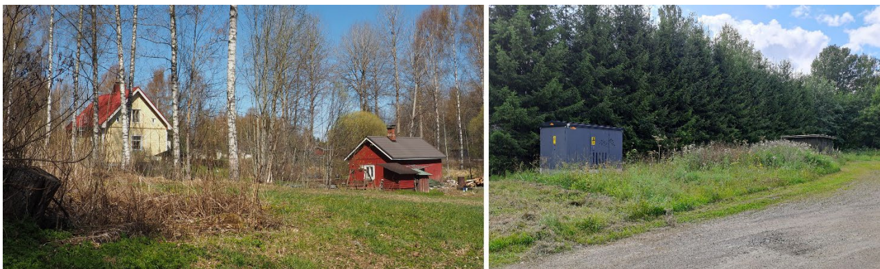
Kuva 14. Vasemmalla suunnittelualueella sijaitsevan pientalotontin rakennuksia. Oikealla toinen alueen puistomuuntamoista sekä pieni varistorakennus.
