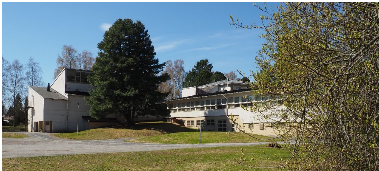
Kuva 9. Vasemmalla juhlasalisiipi ja oikealla luokkasiiven luokkahuoneiden ikkunarivistö.
