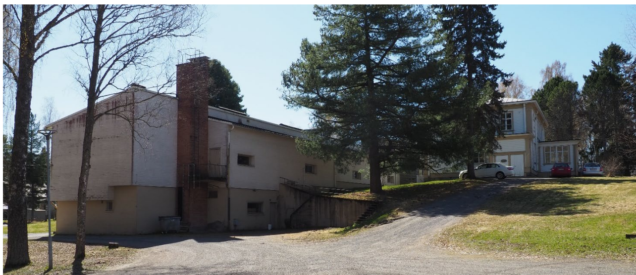
Kuva 10. Luokkasiipi ja puurakenteinen siipi.
