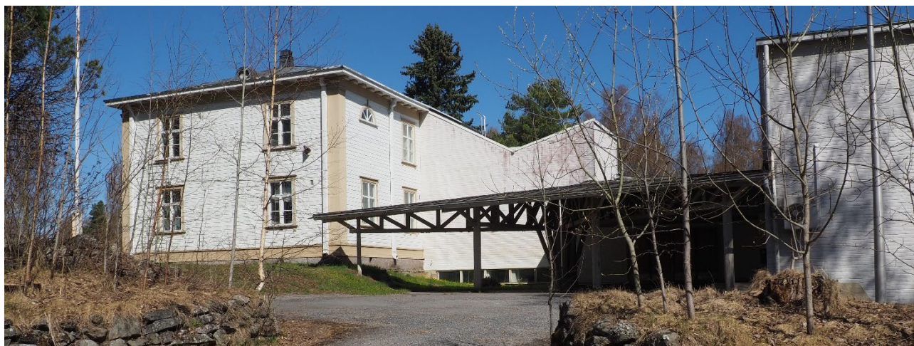
Kuva 12. Alkuperäisen rakennusosan ja lisäsiipien yhtymäkohta rakennuksen lounaispuolella.
