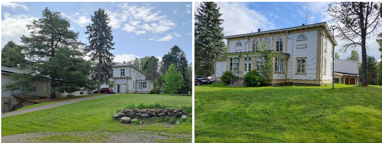
Kuva 13. Nuhalan koulu nähtynä koillisesta ja luoteesta. Vasemmanpuoleisessa kuvassa näkyy keuhällä 2024 puretun piharakennuksen kivijalka. Oikeanpuoleisessa kuvassa näkyy, että läheltäkin katsottuna liikuntasalisiipi jää maisemassa puurakenteisen koulun taakse.
