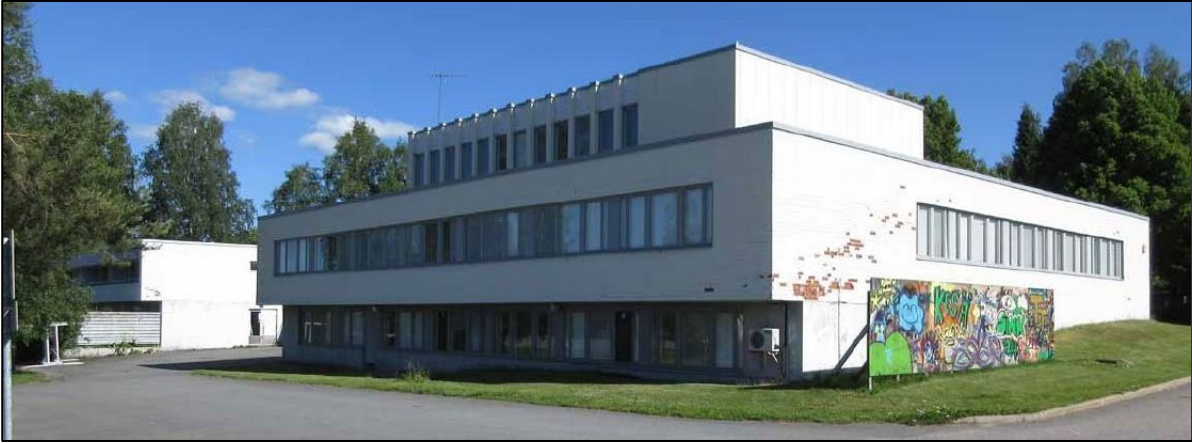
Kuva: Kunnantalon urheilukentän puoleinen julkisivu
