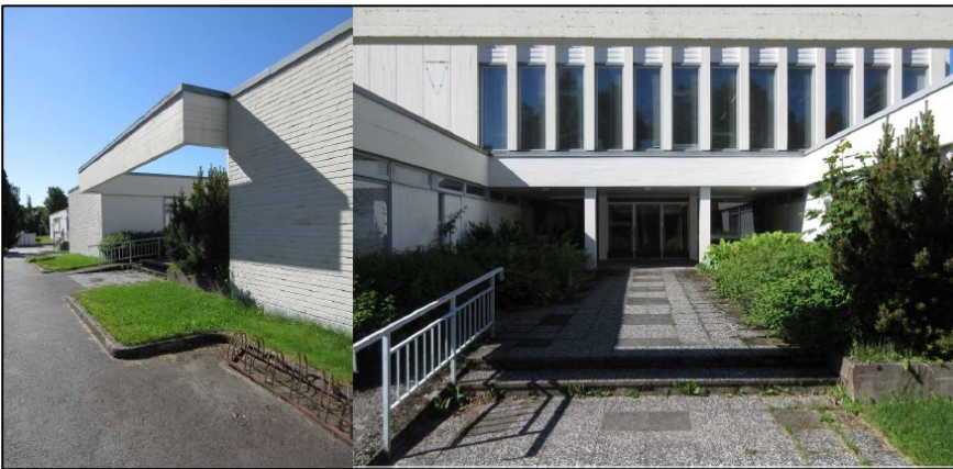
Kuvat: Kunnantalon sisäänkäynti Evontien suuntaan
