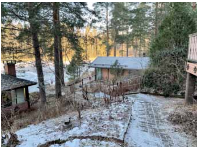
3. Keittokatos ja sauna asuinrakennuksen edestä nähtynä.
