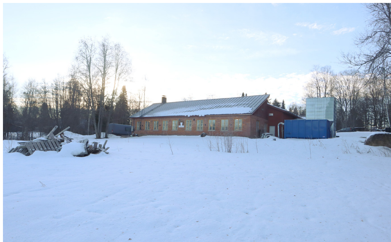
Tampereen valtatie suuntaan avautumassa näkymässä herättää huomiota pihapiirin reunalla sijaitseva vanha pajarakenus.
