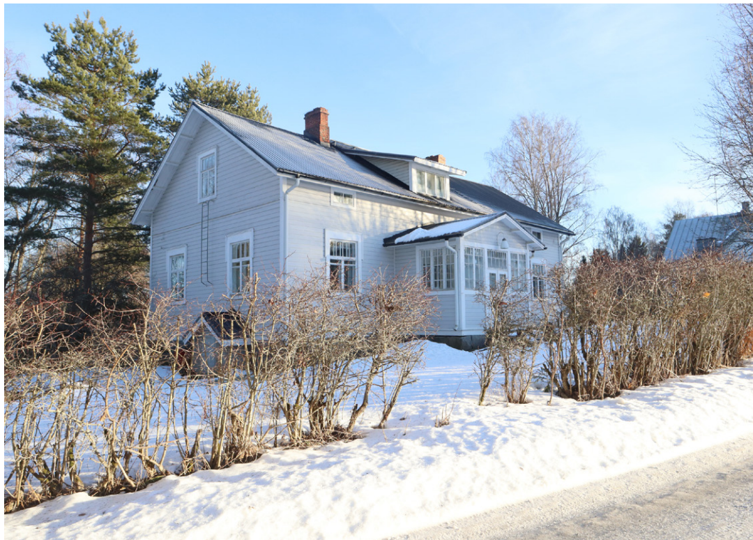
Maurits Koskisen v 1918-19 rakentama Vanhan Akkalan päärakennus Pappilantien varressa.
