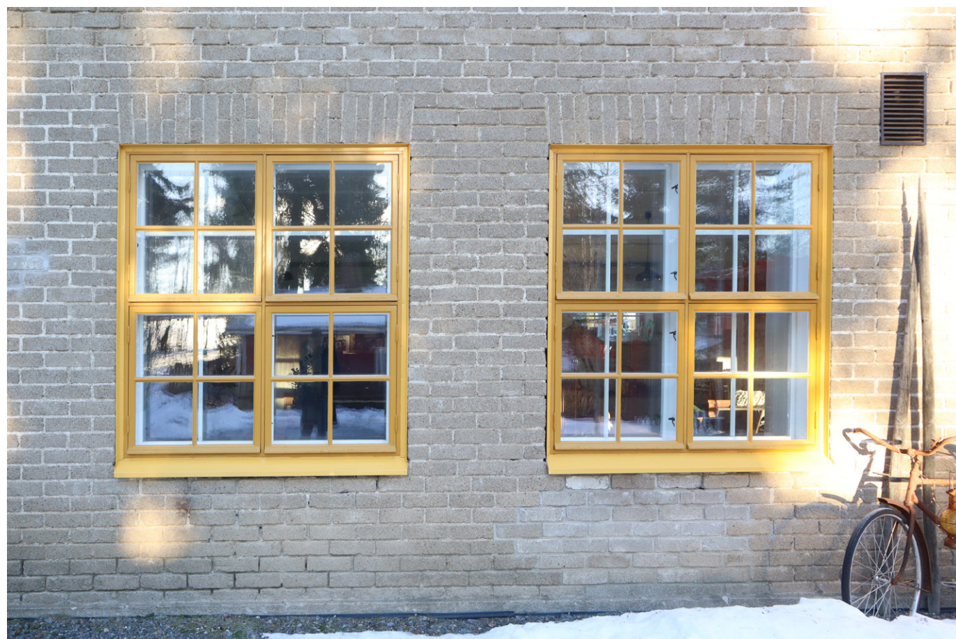
Vanhat puikkunat on kunnostettu 2010-luvulla. Ikkuna-aukot on tuettu holvimuurauksella.
