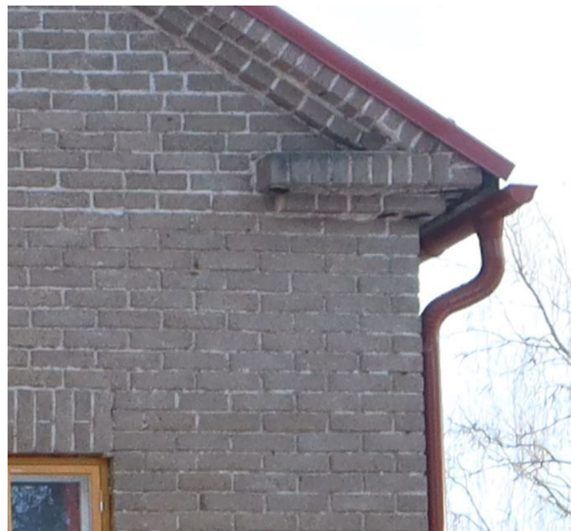
Porrastuen muurattuun räystääseen liittyy päädyssä ns kissanpenkki-aiheet.
