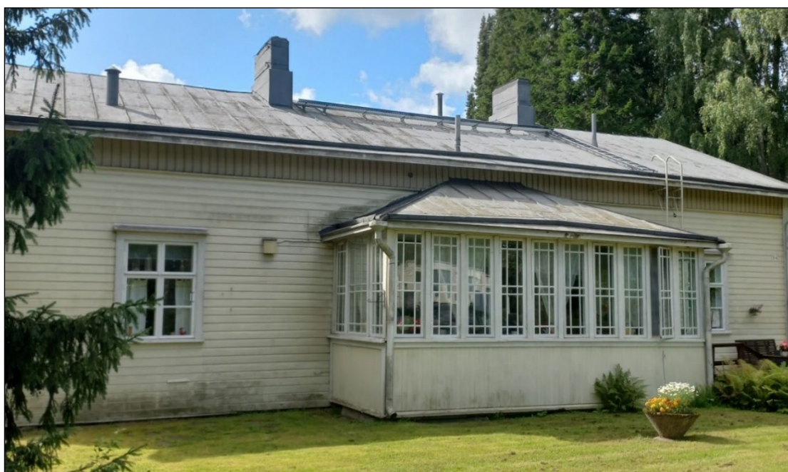
Kuva 8. Tontilla sijaitseva asuinrakennus. (Kuva: Aino Niiva, 2024)
