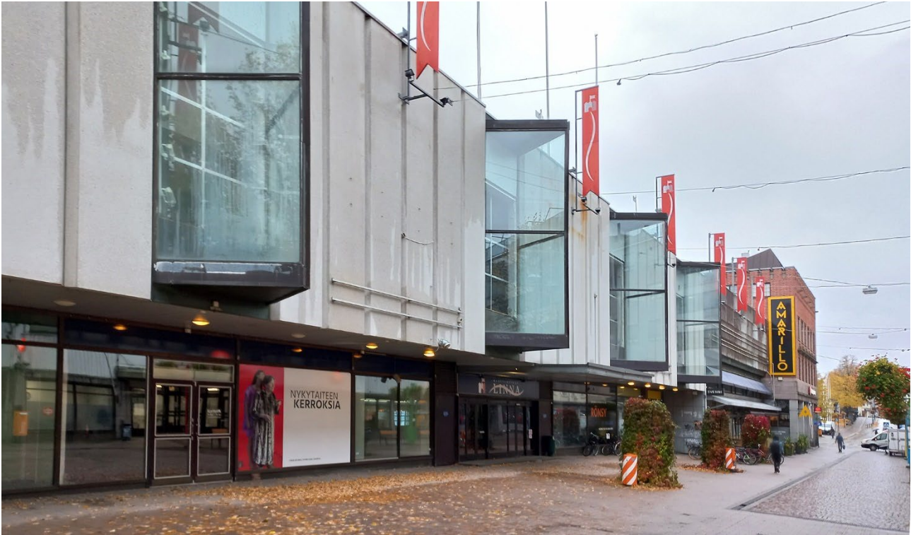
Kuva 7 Sokoksen julkisivua kävelykatu Reskalle, taustalla Kopinkulma.
