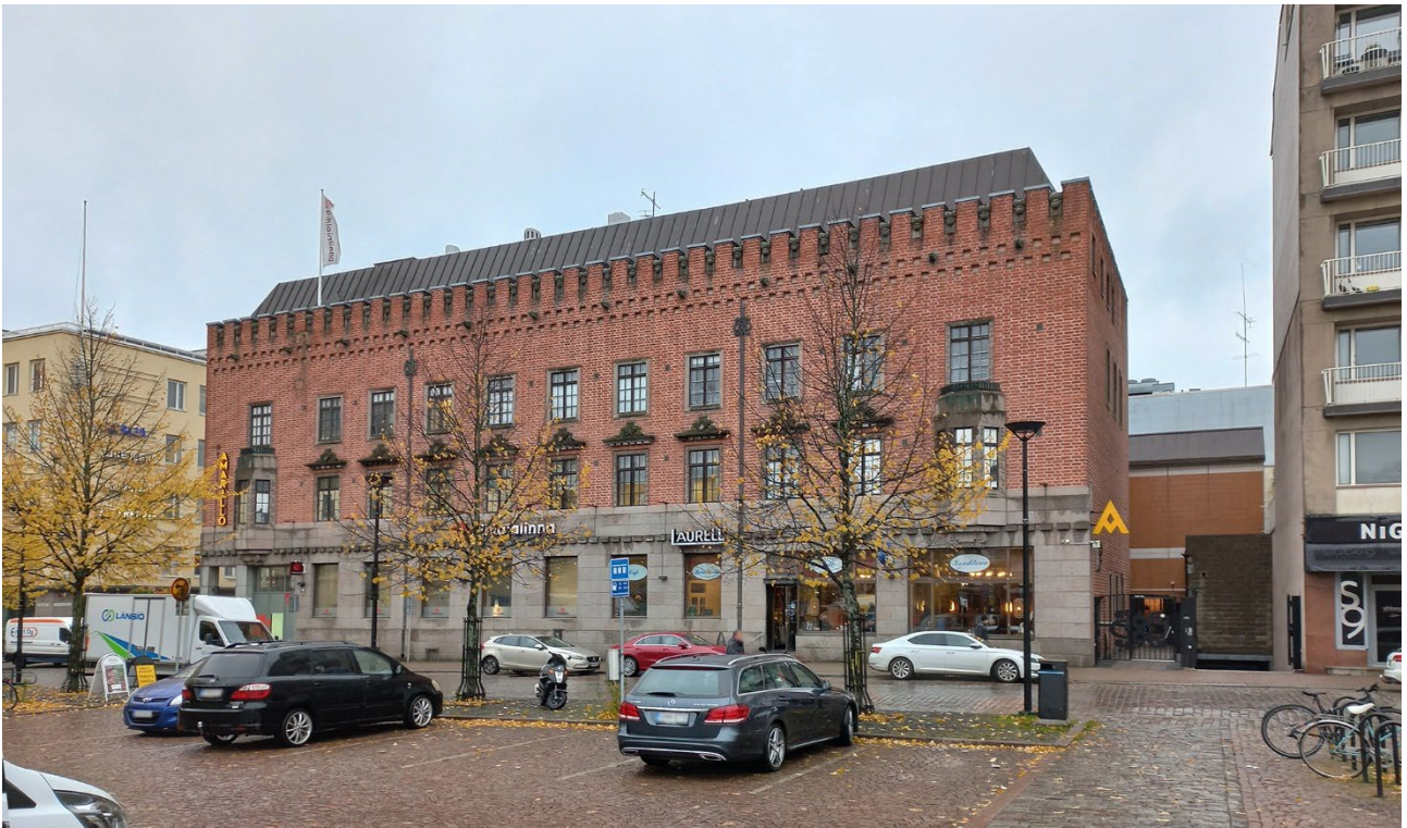
Kuva 6 Kopinkulman alkuperäisen osan julkisivu torin suuntaan.
