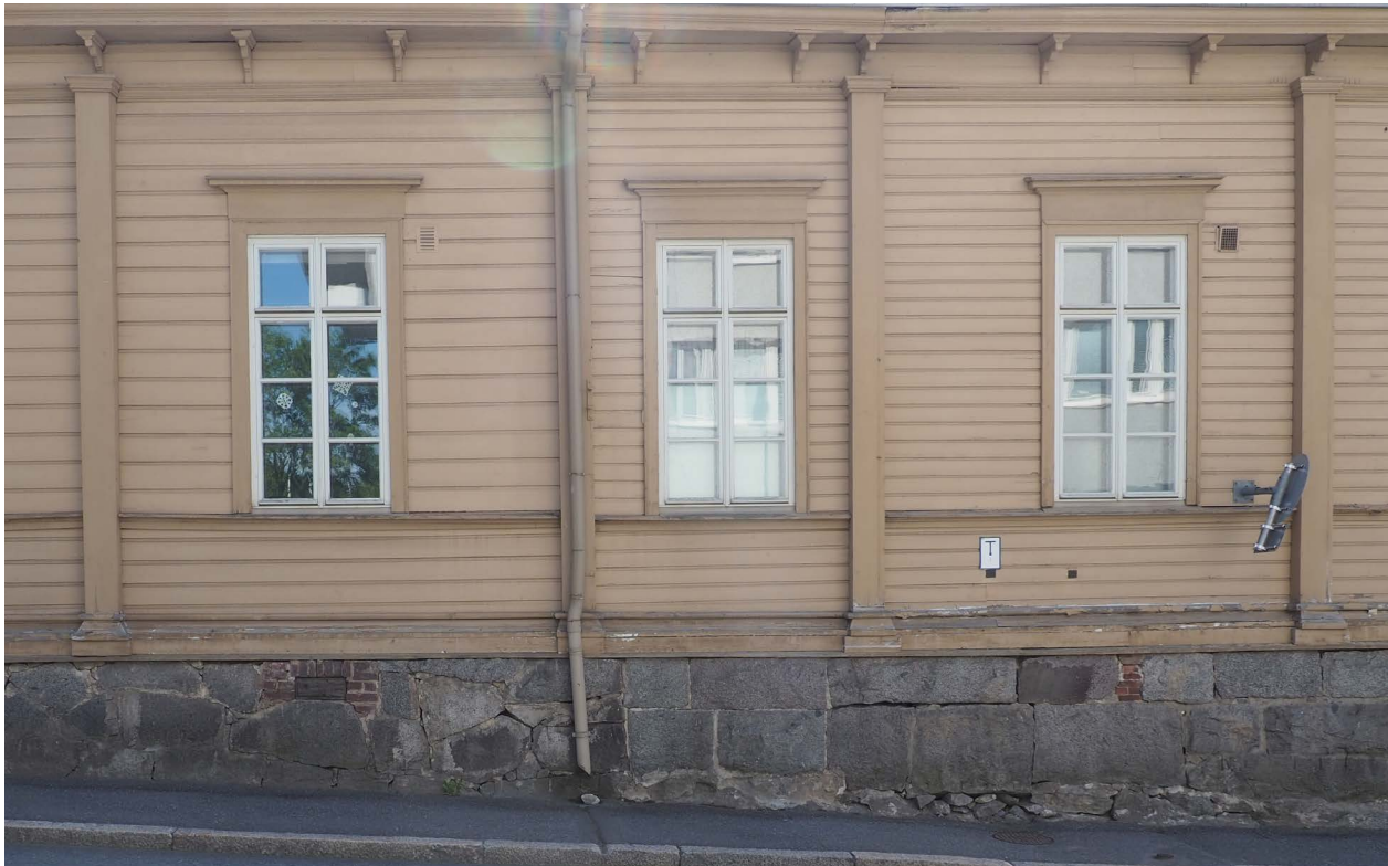
Pohjoisjulkisivun julkisivulaudoituksen leveydestä ja sokkelikivien muodosta on erotettavissa kohta, jossa vuoden 1858 rakennusosa vaihtuu uudempaan. Kapea pilasterien väli on osin 1930-luvulta, jolloin kadunpuoleinen sisäänkäynti poistettiin. Sen oikealla puolella sokkeli ja julkisivun puuosat ovat vuodelta 1895.
