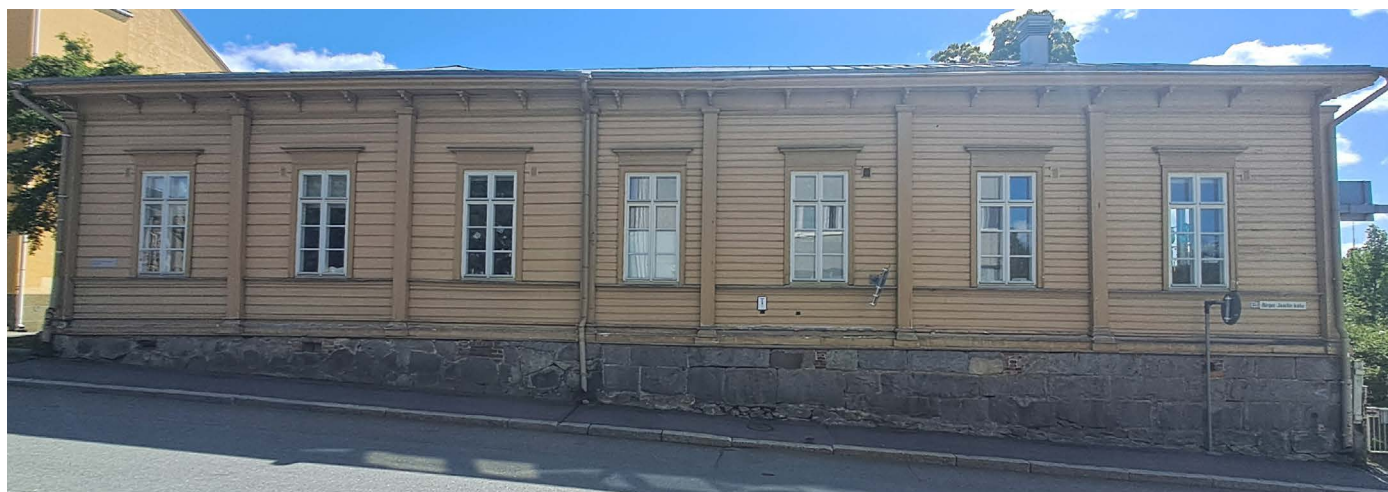
Rouvasseuran talon pohjoisjulkisivu vuonna 2025.
