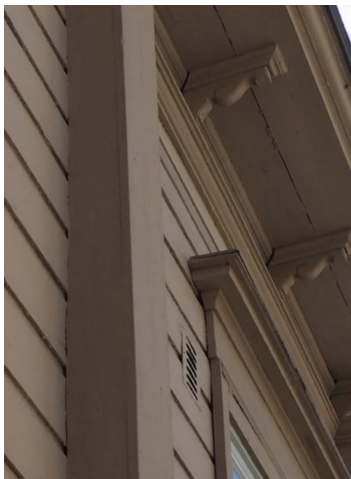
Pohjoisjulkisivun julkisivulaudoituksen leveydestä ja sokkelikivien muodosta on erotettavissa kohta, jossa vuoden 1858 rakennusosa vaihtuu uudempaan. Kapea pilasterien väli on osin 1930-luvulta, jolloin kadunpuoleinen sisäänkäynti poistettiin. Sen oikealla puolella sokkeli ja julkisivun puuosat ovat vuodelta 1895.
