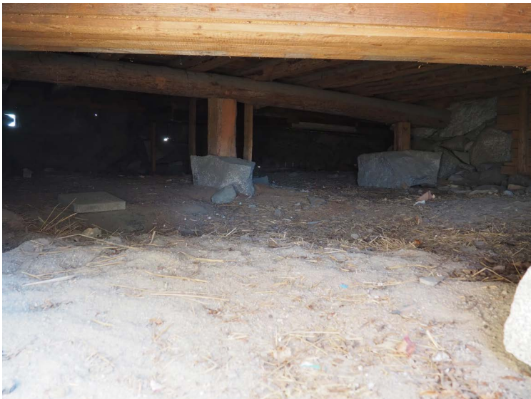
Vuonna 1895 rakennetun siiven alapohjaa.
