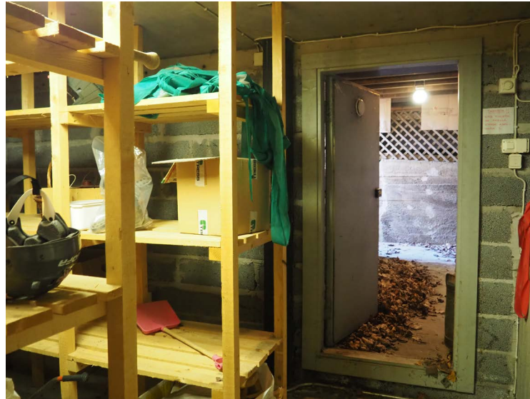
Vuonna 1995 valmistuneen siiven alla sijaitseva kellaritila.
