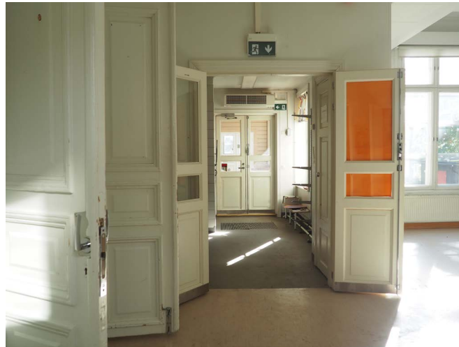
Näkymä eteistilasta 114 märkäeteistilaan 113, joka on rakennut monessa vaiheessa.
