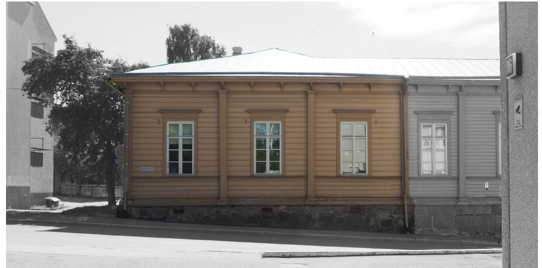
Rakennuksen alkuperäinen ilme on säilynyt melko hyvin. Kuvassa alkuperäinen pohjoispääty, josta myöhemmin tuli osa pitkää julkisivua. Pilasterit ovat luultavasti myöhemmältä ajalta, koska mutta ne on myös luonnosteltu lyijykynällä alkuperäisten piirustusten päälle.
