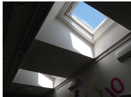
Puitteet on uusittu, mutta kattoikkunat ovat malliltaan ja asettelultaan yhä vuonna 2025 alkuperäisenlaiset.
