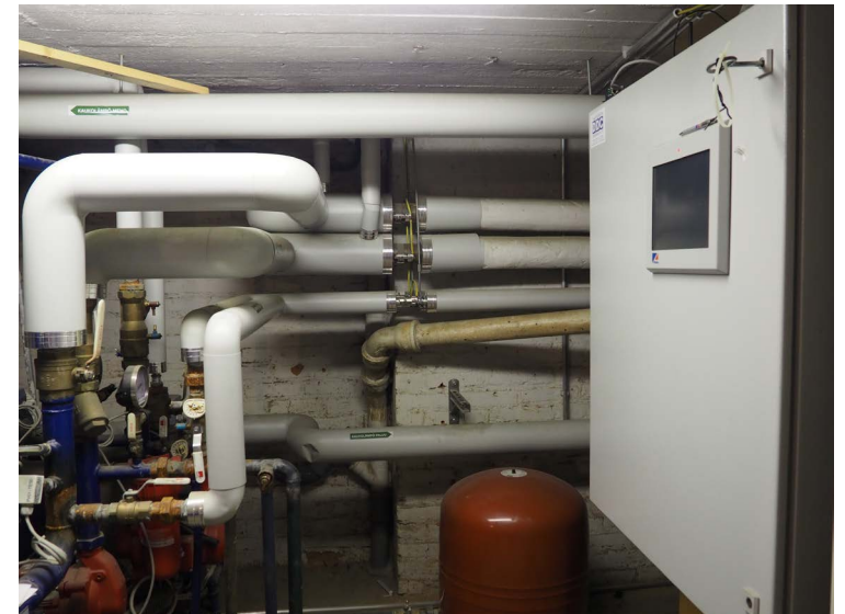
Talon keskivaiheilla sijaitseva kellaritila, joka rakennettiin pannuhuoneeksi ja koksivarastoksi 1930-luvulla.
