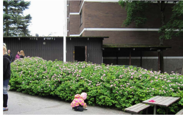
1900-luvun loppupuolella rakennettu ja vuonna 2015 purettu vaja ja katos tontin eteläreunalla kuvattuina vuonna 2014. Takana näkyy vuonna 1980 rakennetun kerrostalon pääty. (Kuva: Hämeenlinnan kaupunki, Tilapalvelut)
