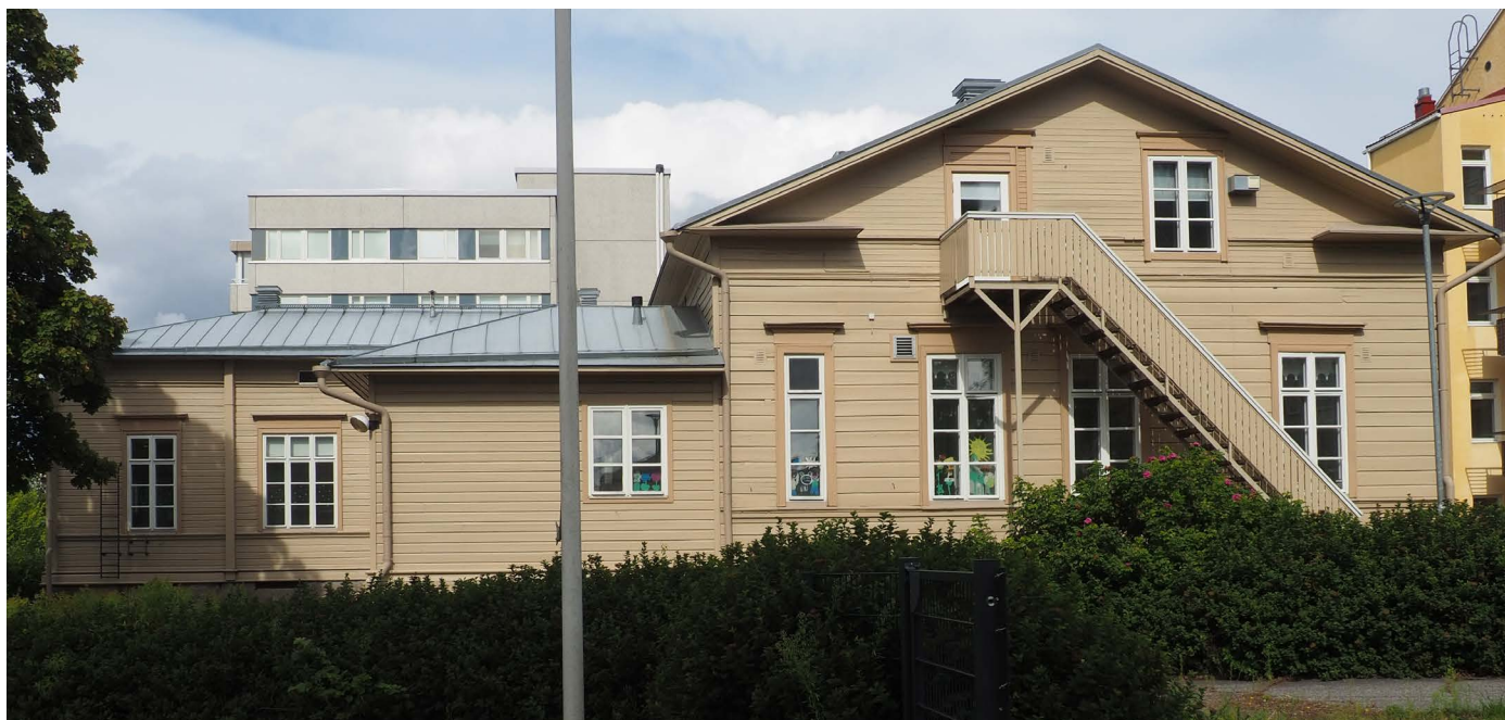
Rouvasseuran talon eteläjulkisivu vuonna 2025.
