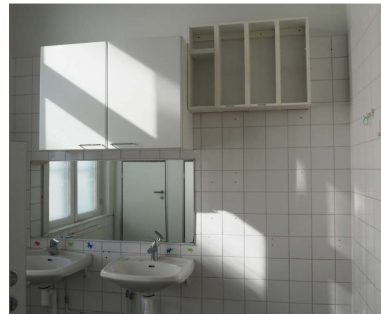
Viimeisen peruskorjauksen yhteydessä rakennettu wc-tila 119.
