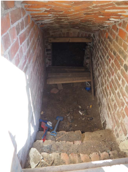
Kellaritila rakennuksen länsipäädyssä.
