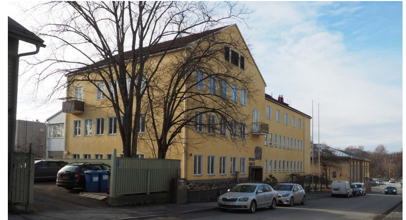
Uppsalatalon katujulkisivu ja sen takana rouvasseuran talo.
