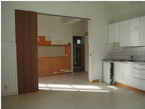
Tilat 108 ja 107 yhdessä tilan 104 kanssa muodostivat alunperin opettajan asunnon ja myöhemmin henkilökunnan tiloja. Seinään on avattu paljeovi 1900-luvun loppupuolella.
