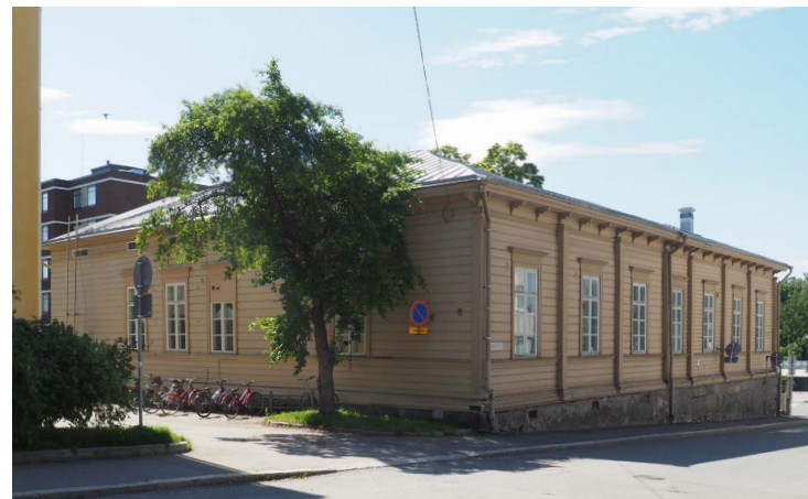
Rouvasseuran talon itä- ja pohjoisjulkisivut kesällä 2025.
