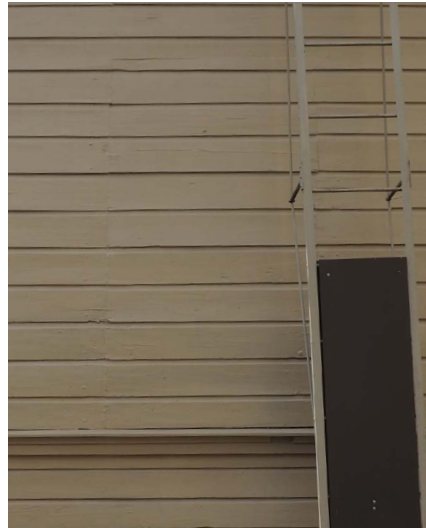
Julkisivuvuorauksen saumoista on hienovaraisesti huomattavissa kohta, josta ikkuna on poistettu 1930-luvulla.
