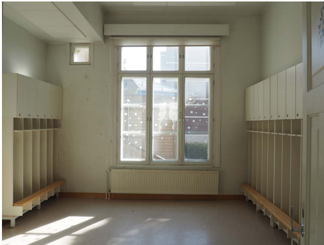
Tilassa 114 ja sen ympärillä on vuosien kuluessa tapahtunut paljon muutoksia. Pieni ikkuna on jääne 1930-luvun wc-tilasta, joka on myöhemmin purettu.
