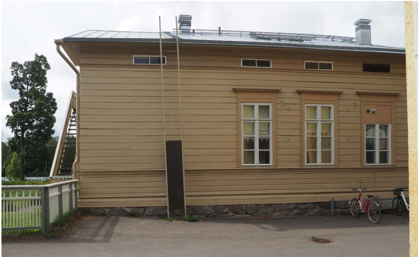
Itäjulkisivun leveä julkisivuvuoraus ja epäsäännöllinen sokkeli ovat 1850-luvulta. Myös ullakon ikkunat ovat alkuperäisiä.
