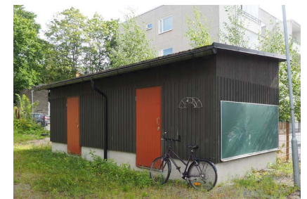
Vuonna 2015 tontin eteläreunalle valmistunut pihavarasto.
