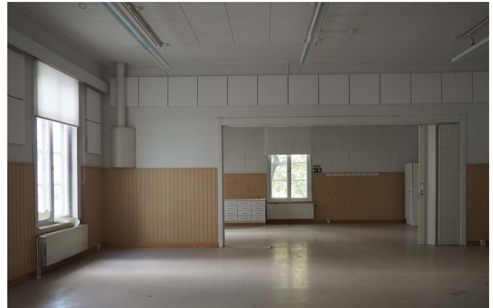
Sama tila ja uudempi samaan kohtaan sijoittuva paljeoviseinä vuonna 2025.
