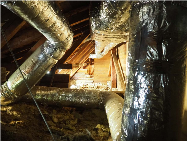
2020-luvun ilmanvaihtoputkia rouvasseuran talon ullakolla.
