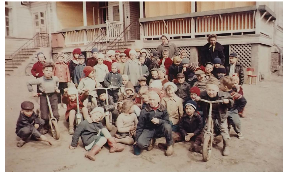
Vuonna 1960 otetusta pihakuvasta näkee, että kuisti on ollut 1950-luvun lopun muutostöiden ja julkisivusta ulkonevan tuulikaapin rakentamisen jälkeen melko monimuotoinen. (Kuva: Hämeenlinnan kaupunginarkisto)
