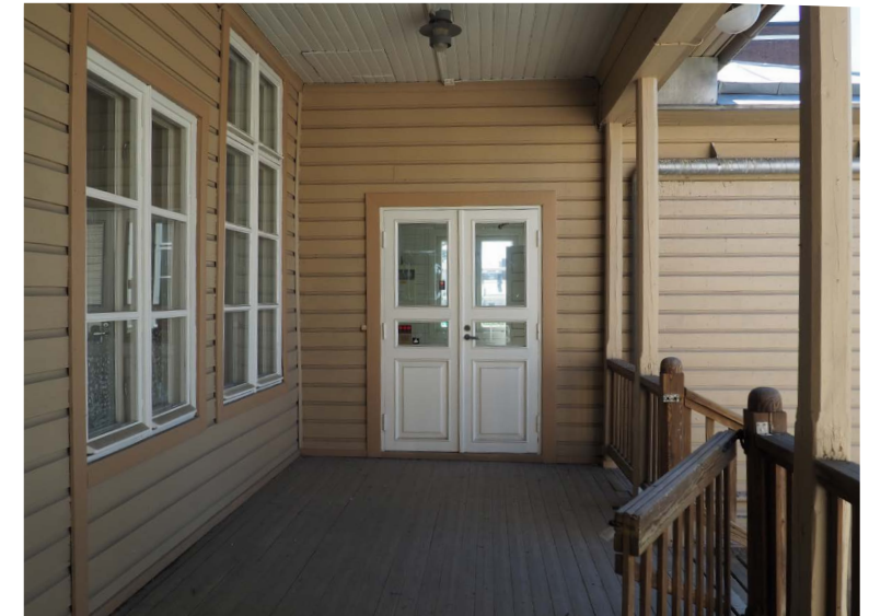
Rakennuksen pääsisäänkäynnit sijoittuvat nykyään kuistin pätyihin ei- vältä alkuperäiseen tapaan länsijulkisivulle. Seinäpanelointi on sahattua puutavaraa, ja vaikuttaa siltä, että se on uusittu kuistin takaseinällä sa- malla, kun vuoden 1995 uusi rakennusosa on toteutettu. Kuistin lattia ja katto ovat oletettavasti vanhemmalta ajalta.
