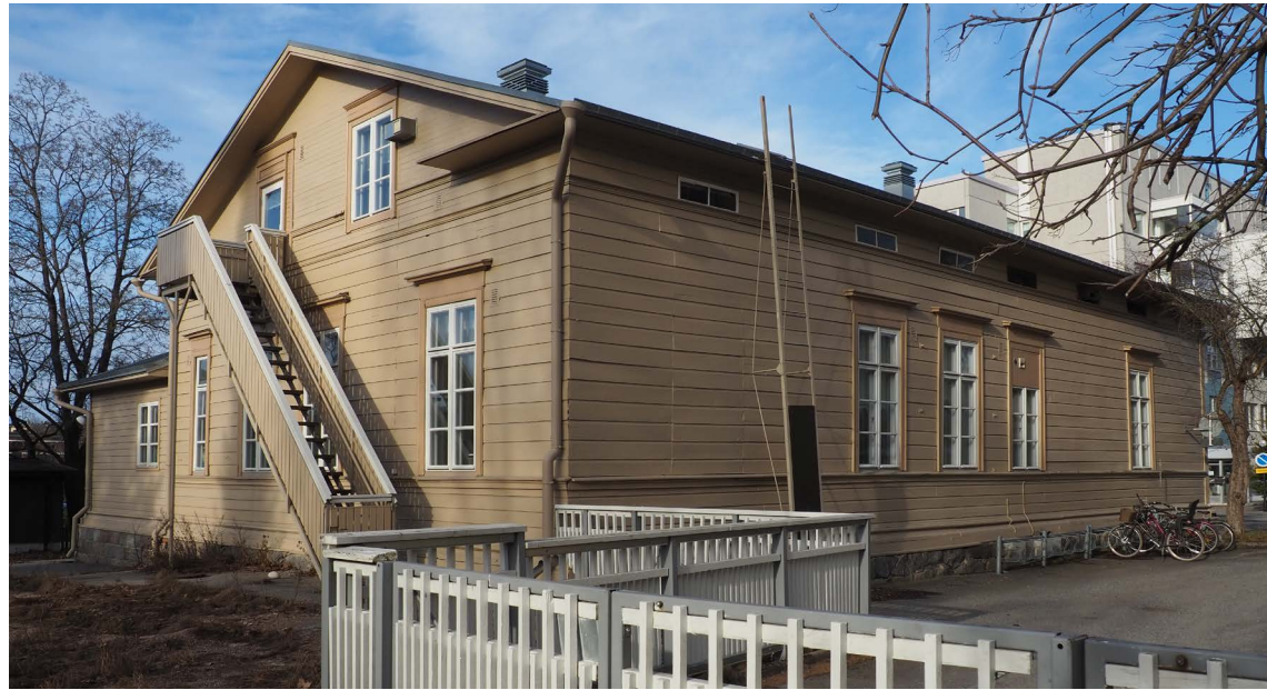
Osa ullakon ikkunoista on poistettu ja jäljellä on verkotetut aukot. Talotikkaan ikä ei ole tiedossa. Päädyn poistumistieporras rakennettiin ensimmäisen kerran 1950-luvulla, mutta nykyinen porras on 1980-luvulta.
