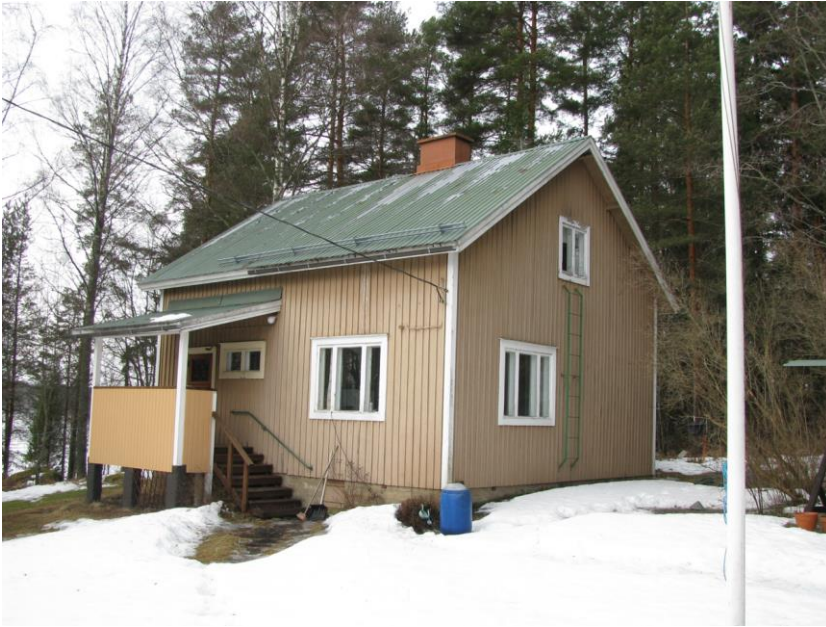
Kuva 8. Tilan Telkkä I asuinrakennus.
