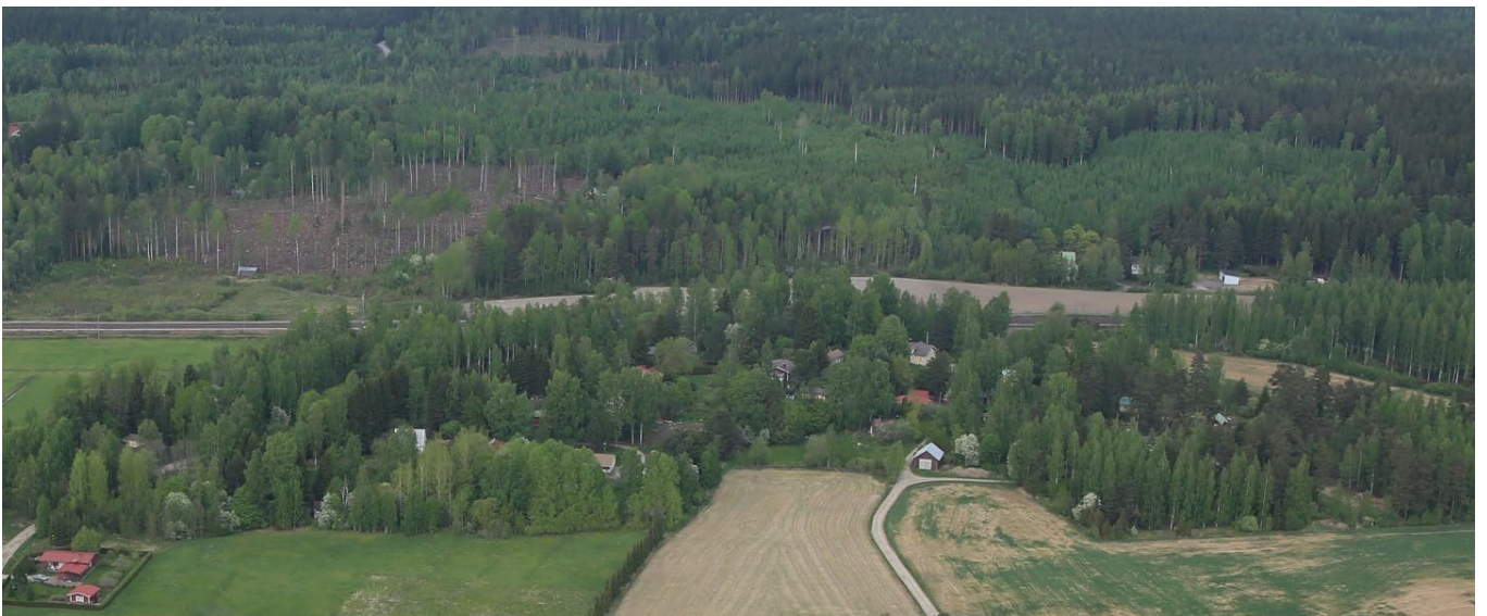
Kuva 13. Turkinmäentien pohjoisosaan sijoittuvaa vanhan mäkitupalaisalueen rakennettua ympäristöä.
