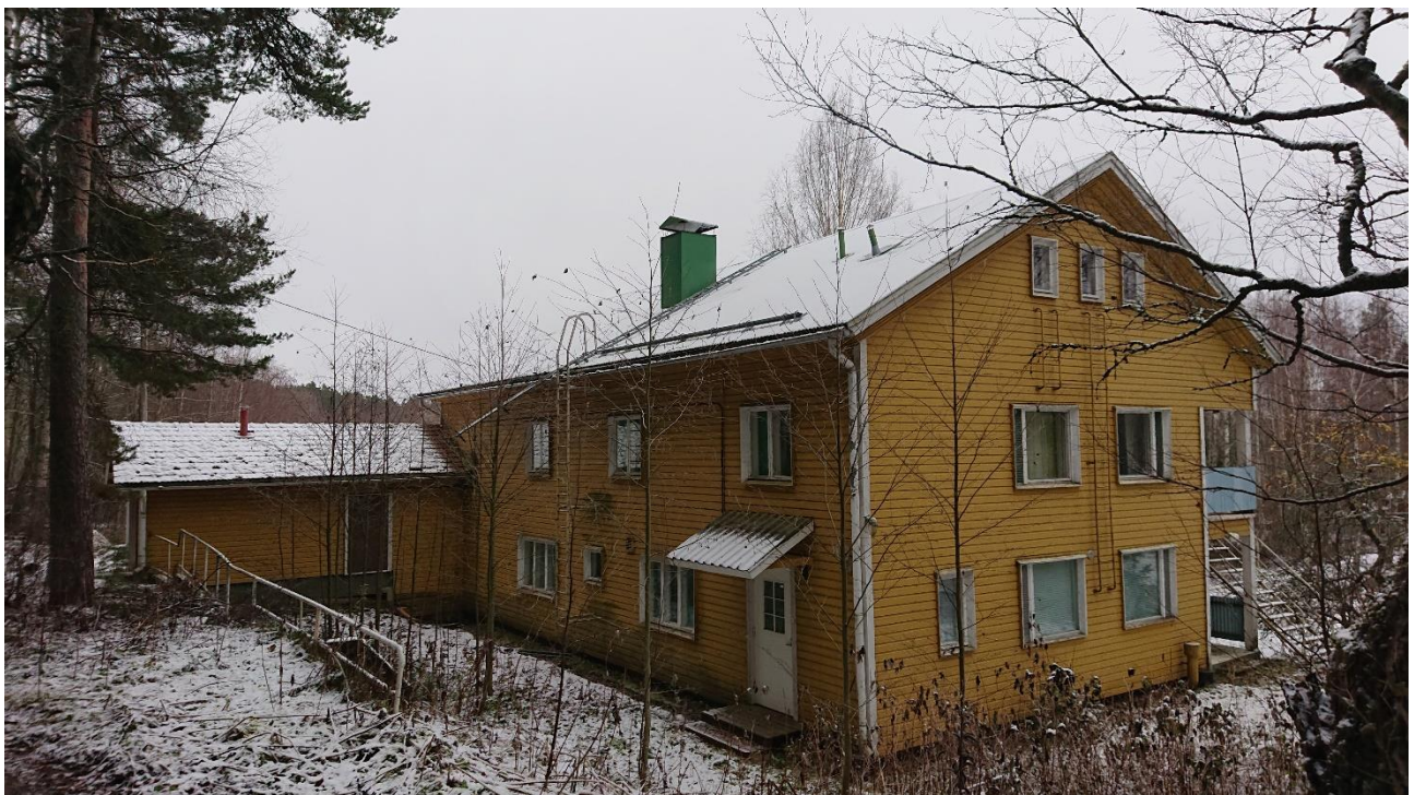
Kuva 10. Entinen täysihoitolarakennus luoteen suunnasta kuvattuna (Arto Remes, 15.11.2023).
