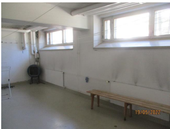
Kuva 5.7 Liitelevypattereita kuivaushuoneessa
