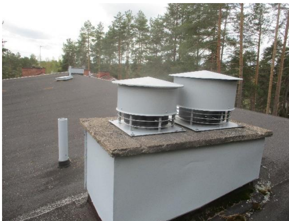
Kuva 7.1 Vesikatolla olevat huippuimurit
