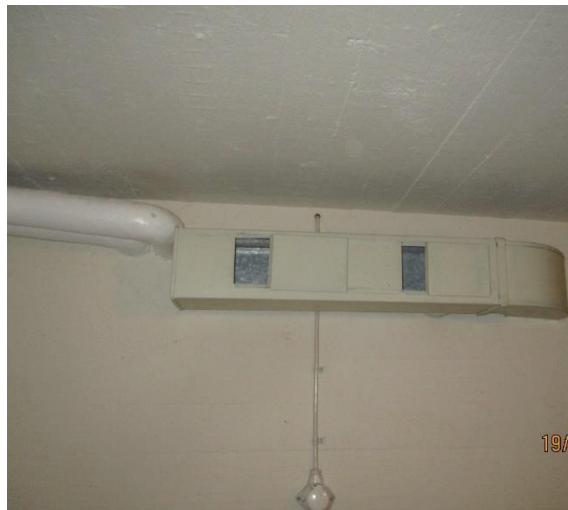
Kuva 7.4 Väestönsuojassa peltikanavistoa
