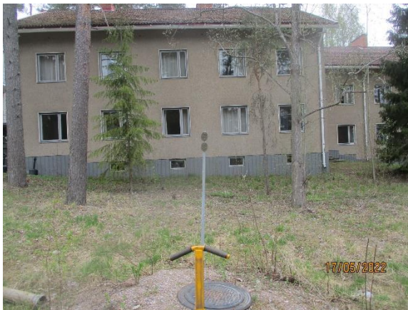
Kuva 6.1 Uusittuja kaupungin liitoskaivoja asuntolan 1 puoleisella reunustalla
