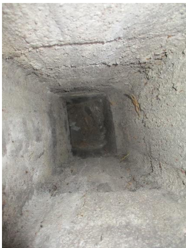
Kuva 7.3 Rakenneaineinen hormi
