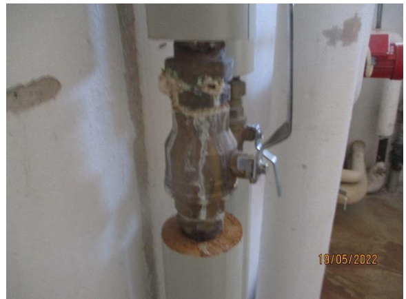
Kuva 6.3 Pallosulkuventtiilissä hapettumaa
