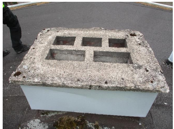
Kuva 7.2 Rakenneaineisien hormien piippuryhmä
