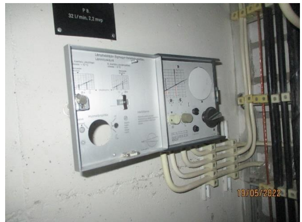
Lämmitysverkon lämmönsäätimenä on vanha Landis & Gyr Sigmagyr-Variator säädin. Ajanmukaistaminen olisi jo suositeltavaa.
