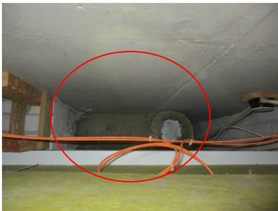
Kuva 7.3 Alakaton sisään asennettua ilmanvaihtokanavaa, joka on eristetty te- räslankaverkolla sidotulla villalla
