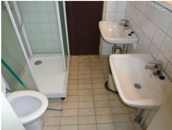
Kuva 6.5 Pesualtaat ovat alkuperäiset, mutta hanat on uusittu 2000-luvulla
