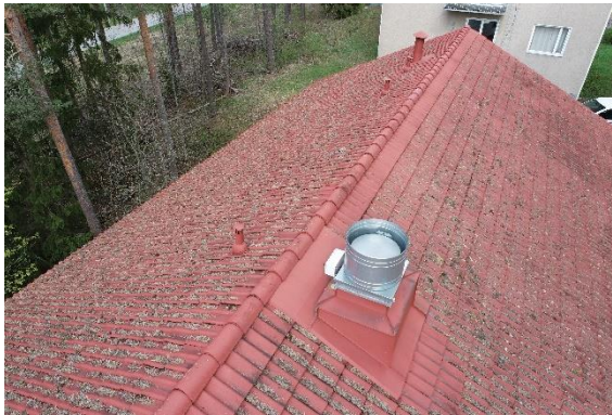
Kuva 7.3 Vesikatolla on yksi huippuimuri, joka on havainnoidun perusteella melko uusi, tarkempi tekninen kilpitieto jäi kirjaamatta puutteellisen kulkureitin takia.
