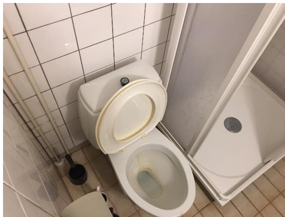
Kuva 6.6 wc-istuimina on pääosin alkuperäiset Arabia-istuimet, joissa on vetonuppihuuhtelulla varustetut vesisäiliöt.
