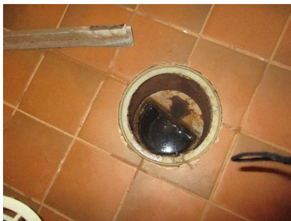
Kuva 6.6 Valurautainen lattiakaivo koro-kerenkaalla
