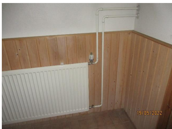
Kuva 5.9 Teräslevypatteri ja termostaatti- nen patteriventtiili
