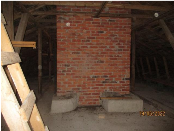
Kuva 7.3 Rakenneaineisia hormirakenteita ullakolla
