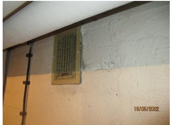
Kuva 7.2 poistoilmasäleikkö kellarissa
