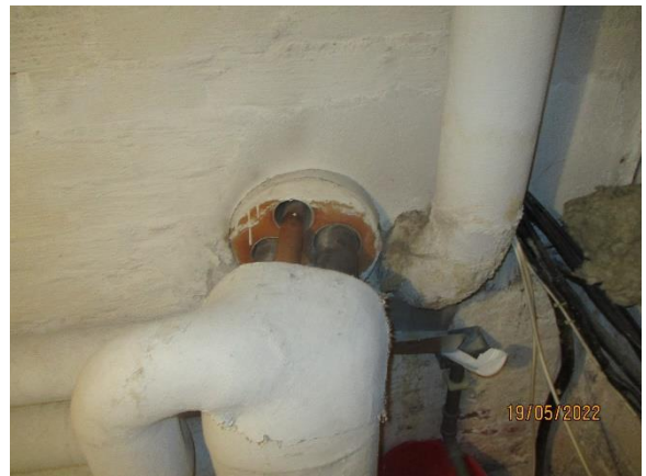
Kuva 6.3 Putkielementit tulevat rakennukseen kellarin tekniseen tilaan portaikon alla.
