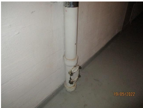
Kuva 6.4 Jäteveden pystyviemäri, alkupe- räistä valurautaviemäriä
