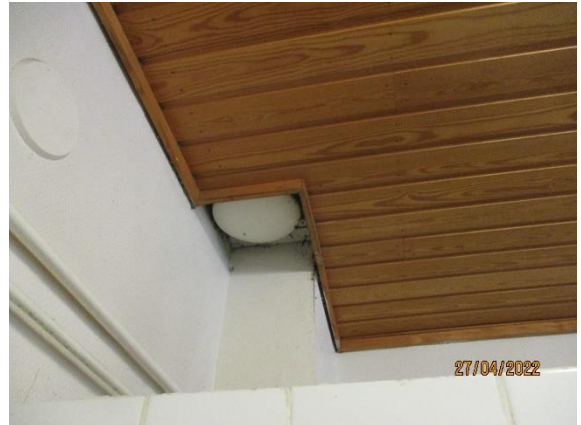
Kuva 7.4 Ilmanvaihtoventtiili märkätilassa
