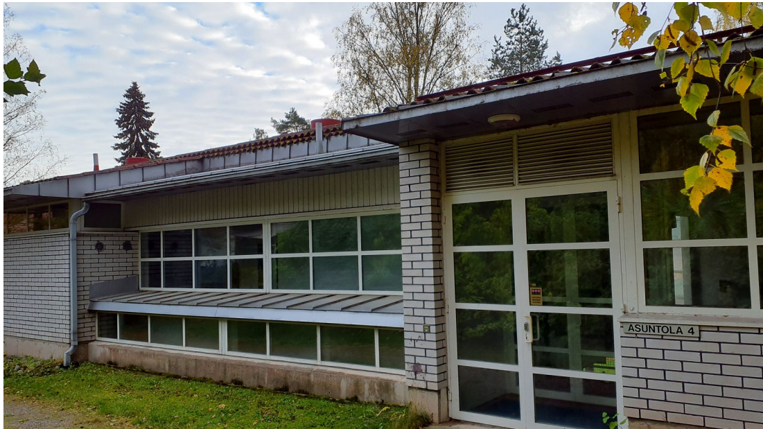
Kuva 3. Vuonna 1985 rakennettu asuntolassa 4 on peltikatto ja tiilirakenne, ullakko ja välikaton tila puuttuu. Ulkoarvio: Heikko.
