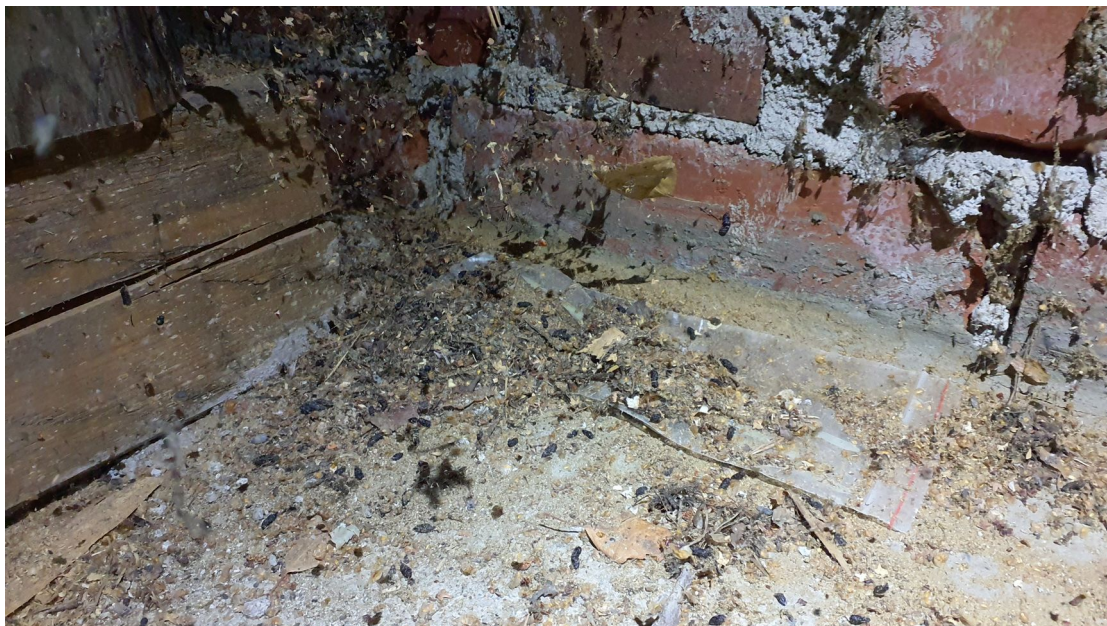
Kuva 6. Koulurakennuksen keskiosan itäpään piippu 4, jonka tyvellä ja osittain hämähäkin verkoissa yli sata kpl ulostepapanoita (näyte3).
