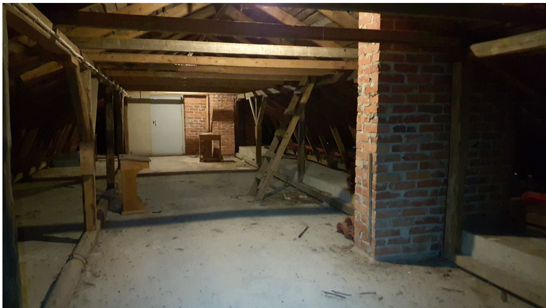
Kuva 9. Yleiskuva koulun päärakennuksen ullakolta, jota läpäisevät ilmastointipiiput. Itäinen ja läntinen ullakko on erotettu seinällä.
