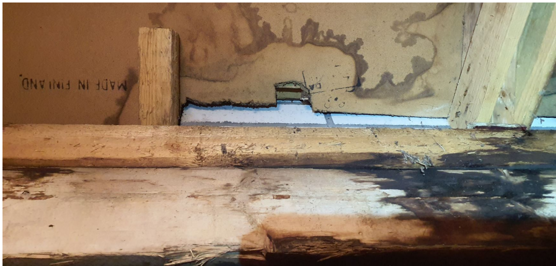
Kuva 12. Asuntola 3:n ullakon katossa on mahdollinen lepakoiden käyttämä kulkuväylä välikaton pahvin raoissa.
